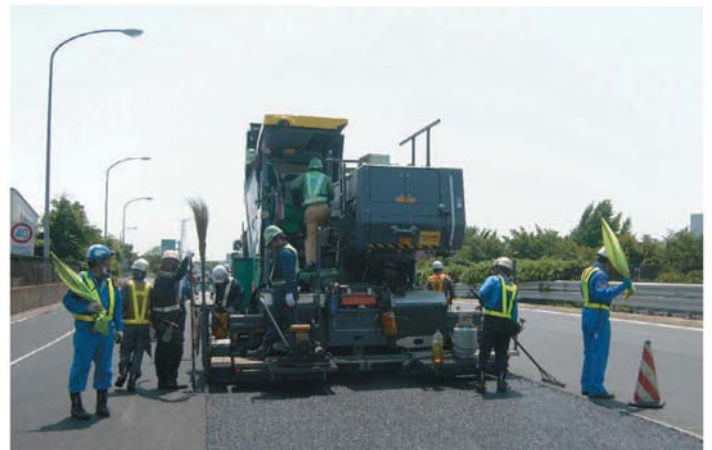
乳剤散布装置付きアスファルトフィニッシャによる施工状況
