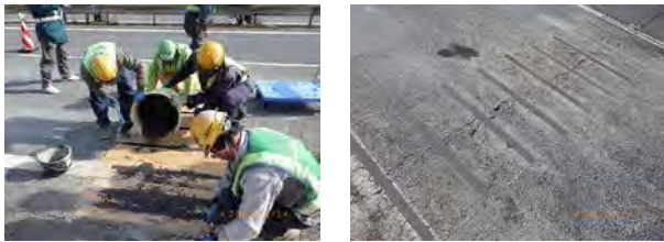
写真-4 モルタル打設(左)、モルタル打設完了(右)
