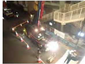
写真-5 ラフタークレーンによる合材供給状況
