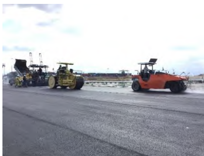
写真-5 施工状況
