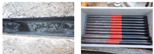
写真-2 撤去部清掃完了(左)、ダウエルバー(右)
