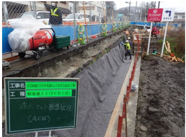
写真-8 遮水マット設置状況
