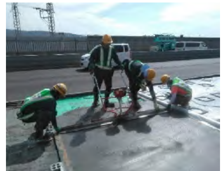
写真-2 大型エンジンスクリード使用
