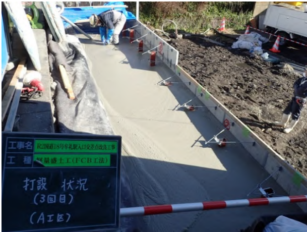
写真-10 軽量発泡盛土打設状況
