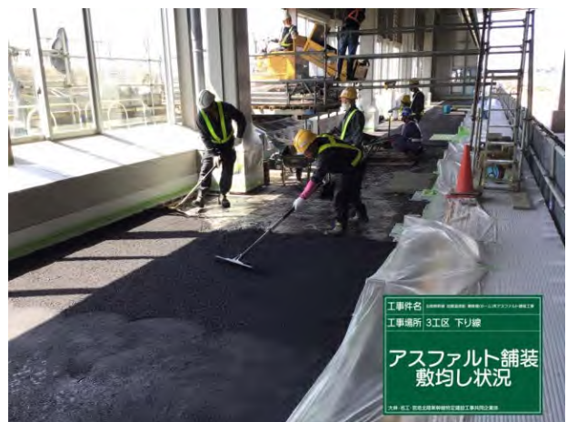
写真-5 レベリング層の施工
