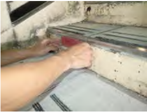
写真-2 紫外線FPRシート貼付け状況
