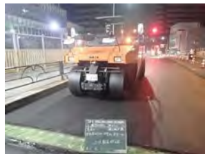
写真-3 舗装施工状況(新田端大橋)
