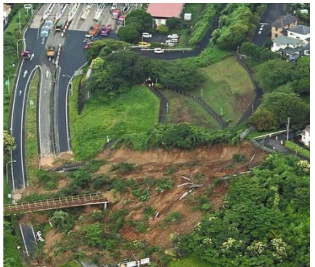
写真-2 法面崩壊による道路付帯施設の破壊状況
