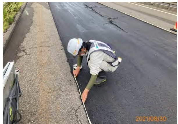
写真-1 成型目地材の設置
