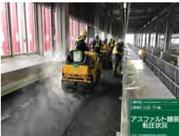
写真-4 コンバインドローラによる転圧
