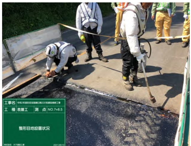
写真-4 成型目地の設置状況
