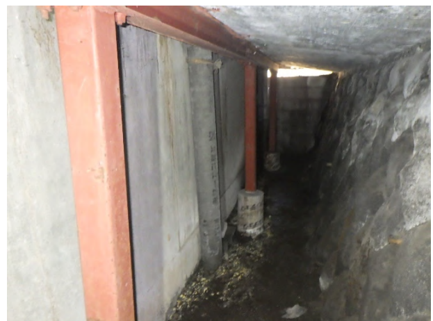
写真-4 B工区着工前
