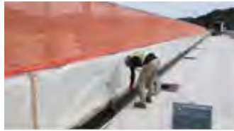
写真-3 端部防水施工状況
