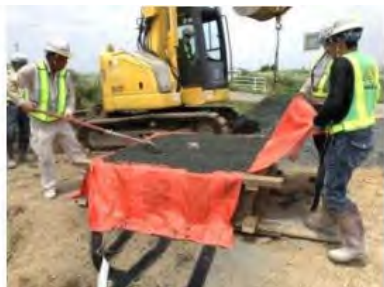
型枠天端まで投入
