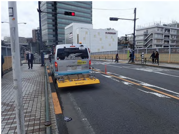
写真-1 床版キャッチャーによる調査
