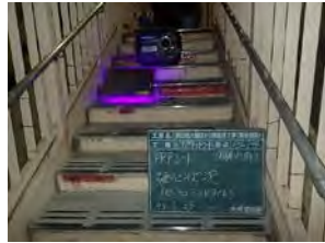
写真-2 紫外線FPRシート貼付け状況
