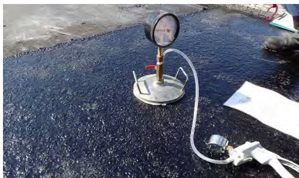
写真-6 真空透気試験実施状況
