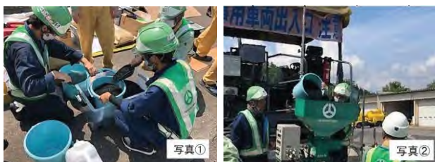
写真-2 ゴムチップ投入前確認①・投入状況②
