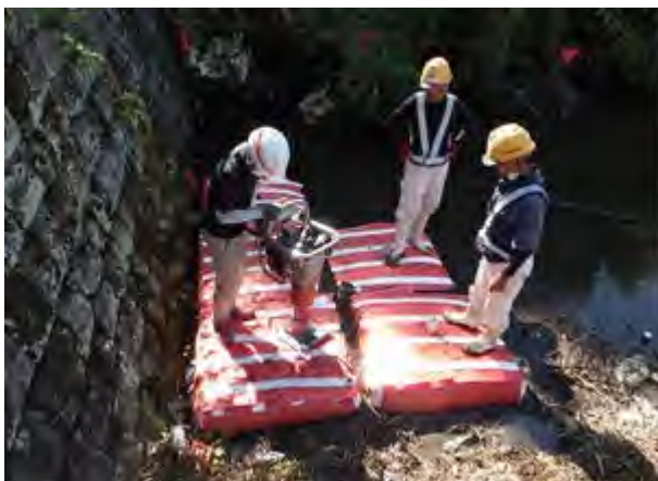
写真-4 ランマによる締め固め状況
