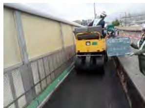
写真-4 舗装施工状況(南大橋)
