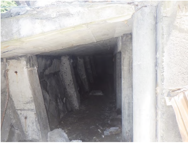
写真-5 C工区着工前
