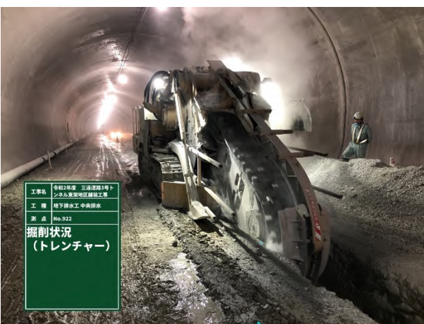
写真-3 掘削状況
