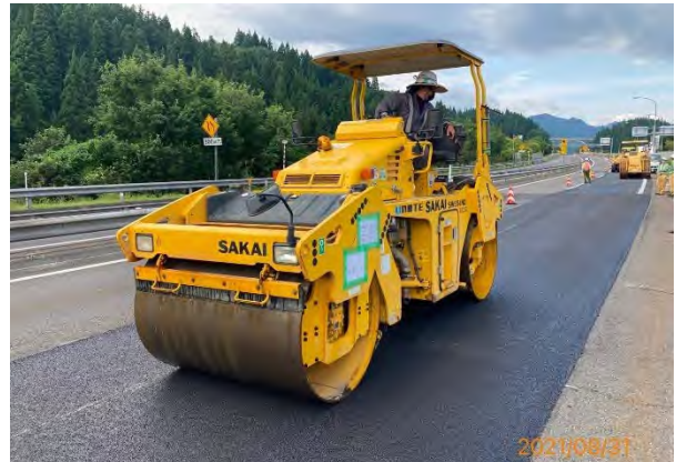
写真-3 二次転圧状況 (水平振動ローラ)
