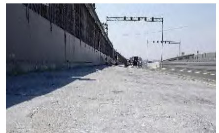
写真-3 施工完了全景
