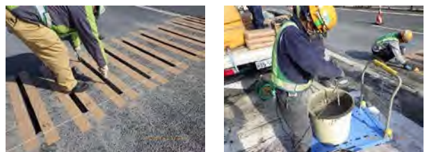
写真-3 ダウエルバー設置(左)、モルタル混合(右)
