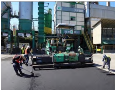
写真-3 試験施工状況
