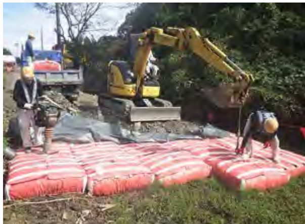
写真-7 施工状況
