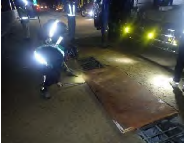
写真-3 鉄板敷設状況
