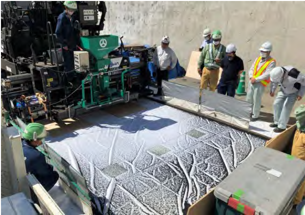
写真-5 ゴムチップ散布量試験の実施状況
