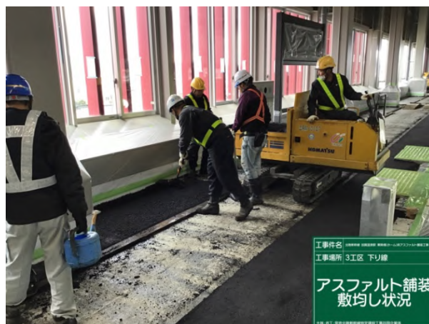
写真-1 キャリアダンプによる合材搬入
