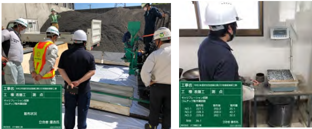
写真-6 ゴムチップ散布量の確認
