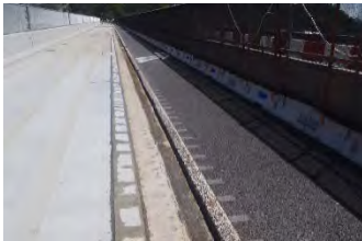
写真-1 残存シート防水
