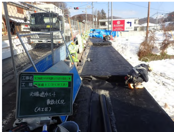
写真-11 天端遮水シート設置状況
