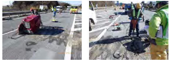
写真-1 カッター切断(左)、舗装版撤去(右)
