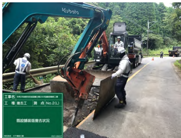
写真-1 既設舗装版の撤去状況
