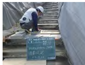
写真-6 ノンスリップタイル施工状況
