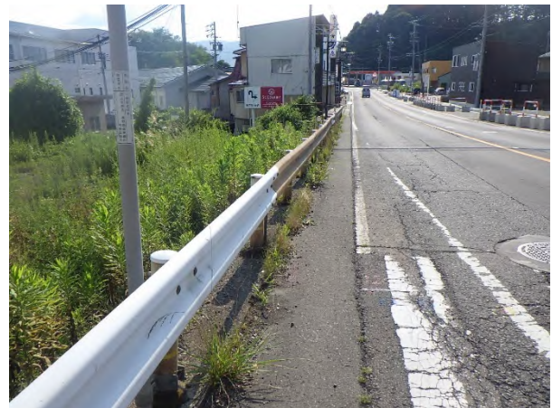
写真-3 A工区着工前
