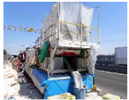
写真-1 車上プラント配置状況
