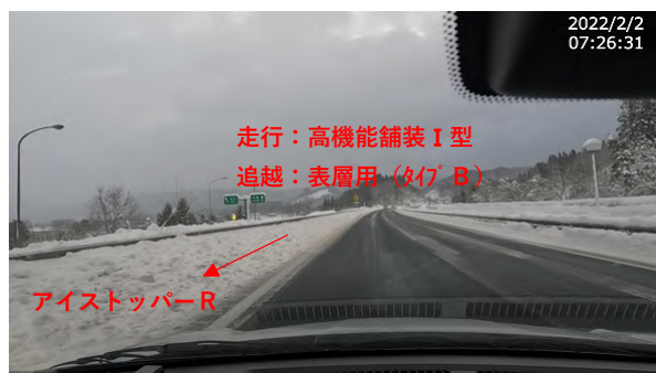
写真-5 アイストッパーR区間の路面状況(終点側)
