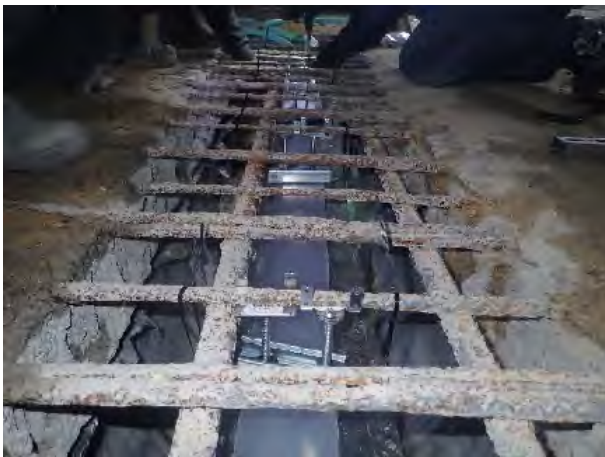
写真-5 押さえ型枠設置状況
