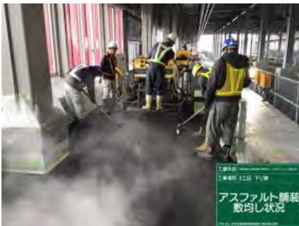
写真-3 アスファルトフィニッシャによる施工
