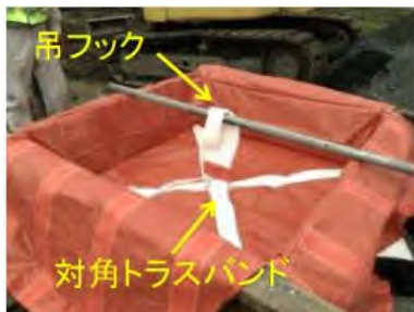
専用型枠内に D・Box をセット
