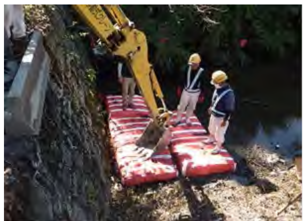
写真-3 バックホウによる加圧状況
