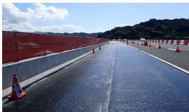
写真-7 BLG施工完了全景
