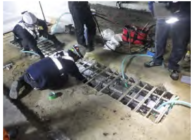
写真-1 ウレタン注入状況
