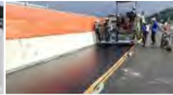
写真-4 BLG施工状況
