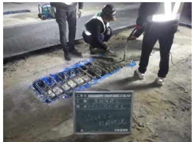
写真-2 ジェットコンクリート打設状況
