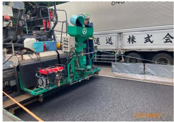
写真-2 ゴムチップ散布状況
