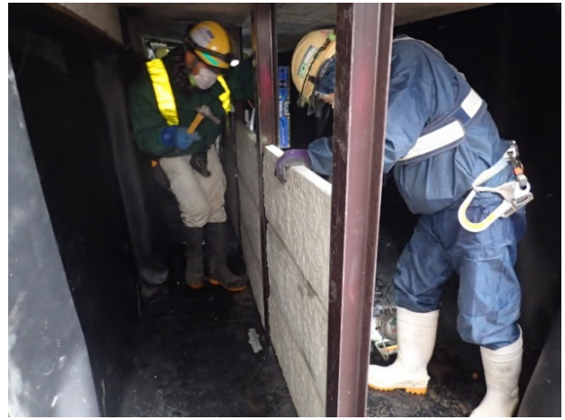
写真-7 残存型枠(当社提案工法)
