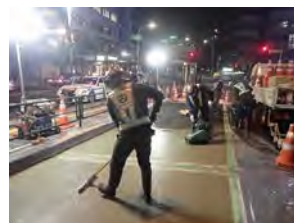
写真-7 半たわみ性舗装施工状況
