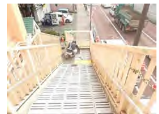
写真-6 ノンスリップタイル施工状況
