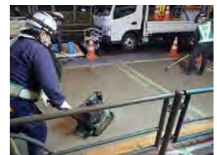
写真-7 半たわみ性舗装施工状況
