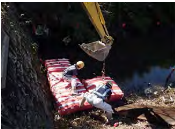
写真-2 敷設状況
