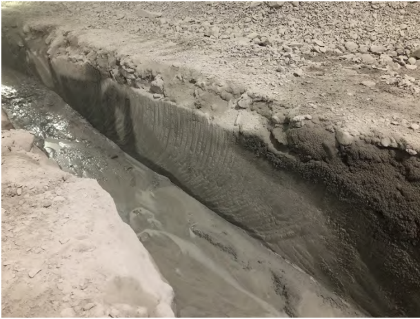
写真-6 掘削断面
