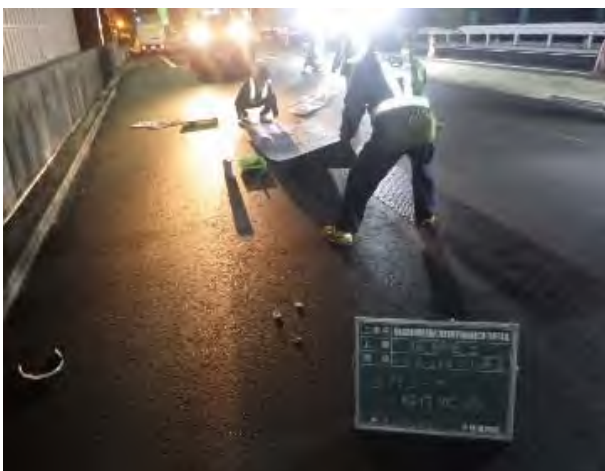
写真-4 路面補修シート施工状況
