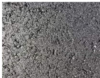
写真-6 施工直後の路面状況
