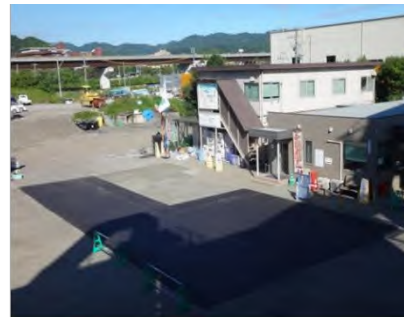
写真-4 試験施工箇所全景
