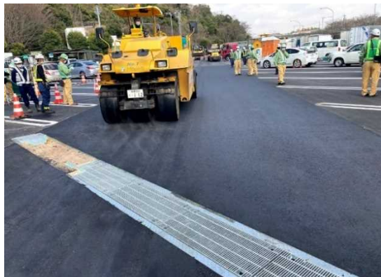
写真-3 タフアスコン施工状況
