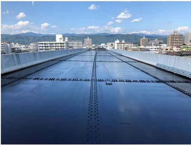
写真-5 プライマー塗布の完了状況
