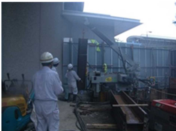
写真-8 クリアパイル工法の施工状況
