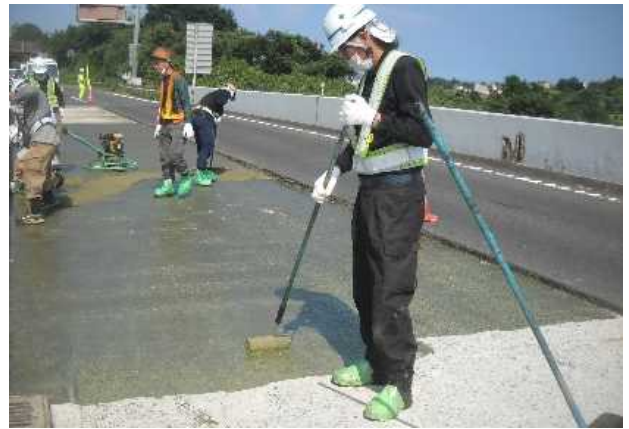
写真-3 HQプライマーの施工状況
