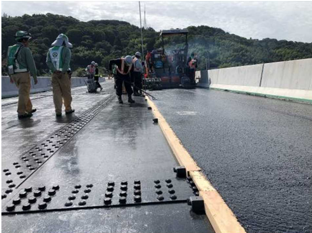
写真-6 型枠の固定状況
