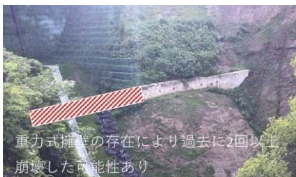
写真-13 既設重力式擁壁の存在
