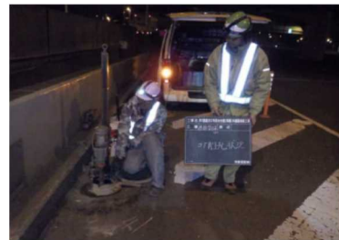
写真-5 コア削孔状況
