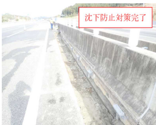
写真-6 沈下防止対策完了
