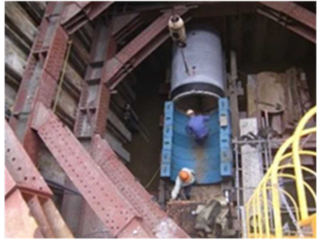
写真-5 「 \phi 1350 刃口推進工」の施工状況
