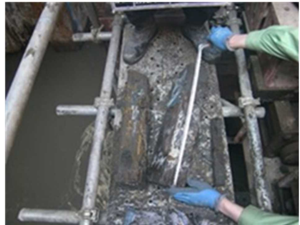
写真-6 推進中の障害物
