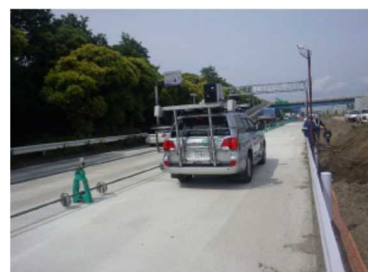
写真-13 RIMによる平坦性測定状況
