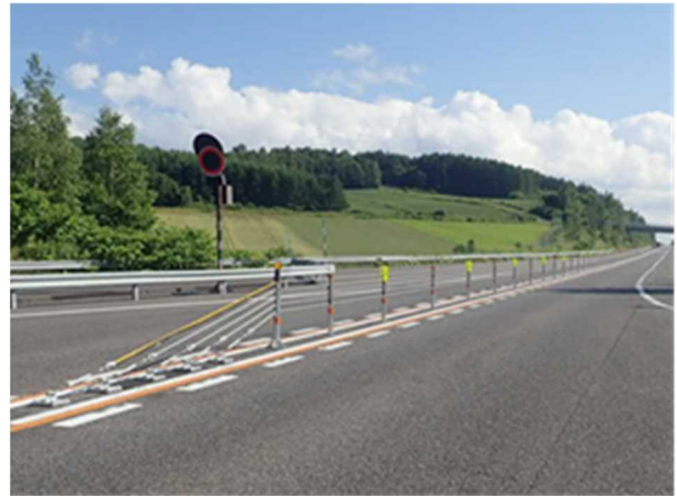
写真-1 車線区分柵(ワイヤロープ)
