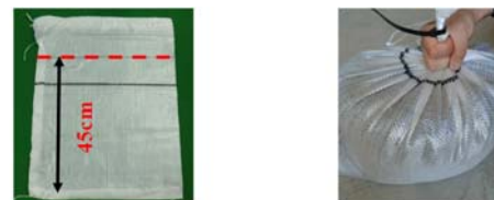
写真 2 土のうの標準的な詰め方
