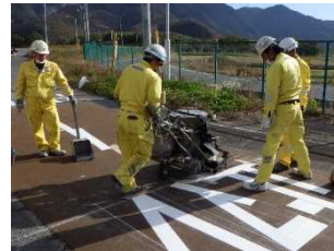
写真-15 ライン施工
