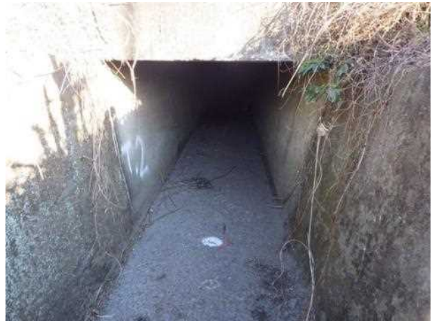
写真-1 既設排水路の入口の状況
