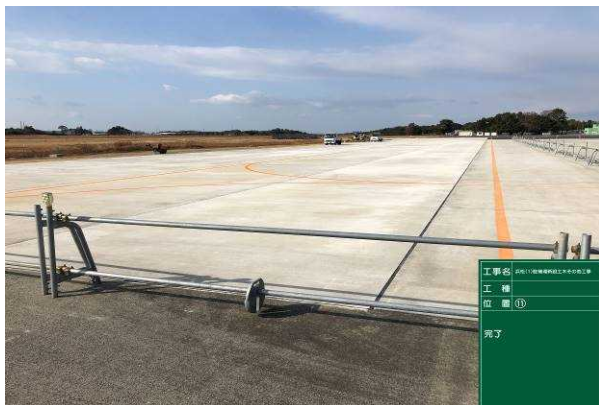
写真-11 誘導路コンクリート舗装全景
