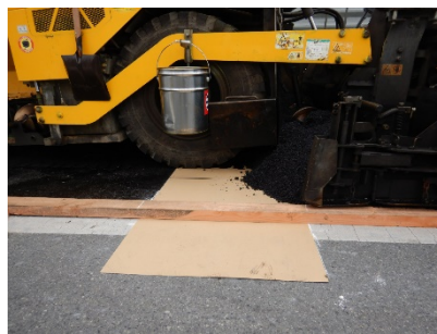
写真-2 全幅に及ぶ間隙の模擬
