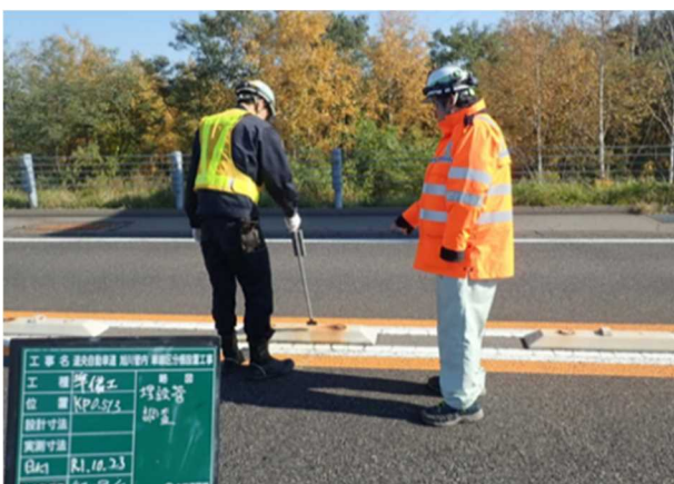
写真-3 現場踏査による埋設物の確認状況(埋設ケーブル探査機)
