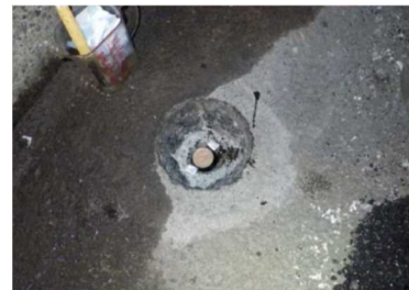
写真-6 水抜管設置状況
