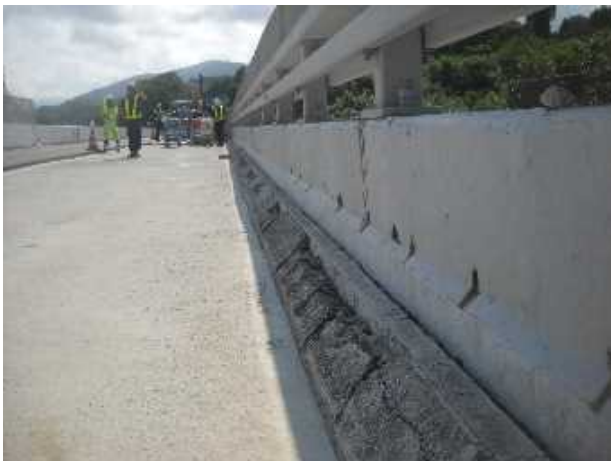
写真-2 端部縁石部の状況
