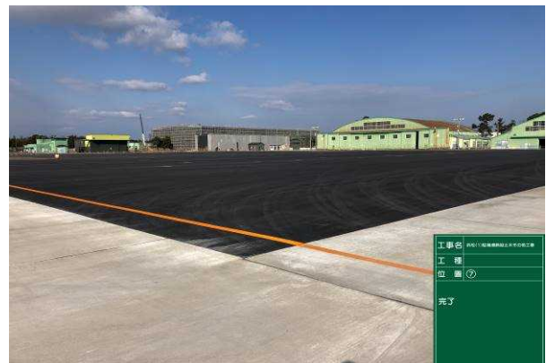
写真-12 駐機場アスファルト舗装全景
