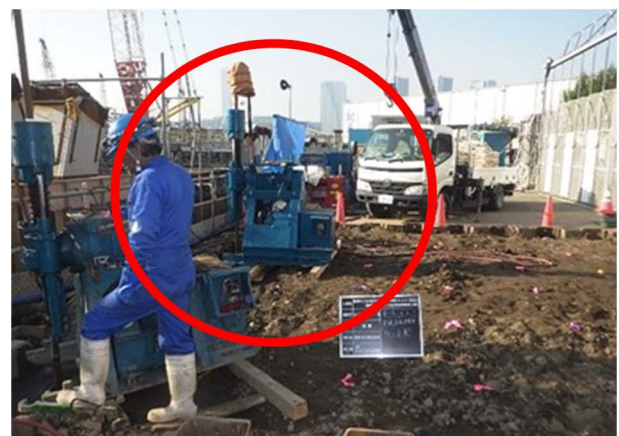
写真-3 立坑底盤改良(恒久グラウト材注入工)状況
