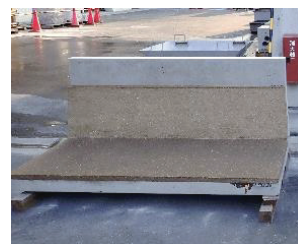
写真-3 施工完了後
