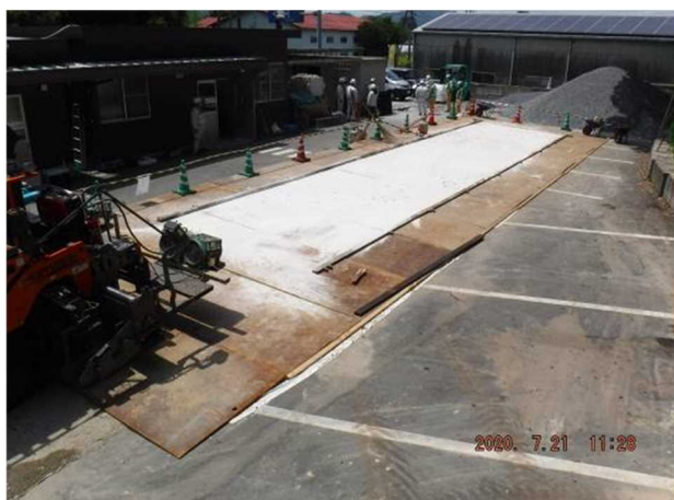
写真-2 試験施工時の鉄板設置状況
