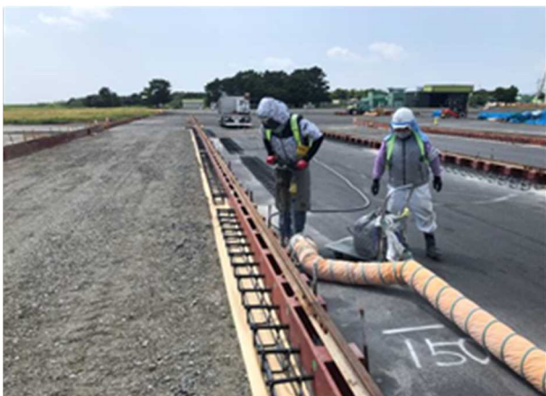
写真-2 鋼製型枠設置
