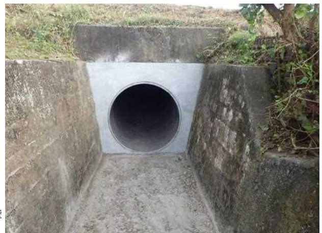
写真-11 完了状況
