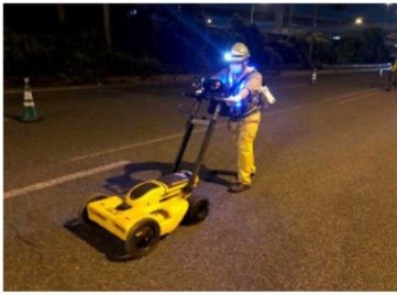
写真-14 地中レーザ探査機による埋設物の探査状況
