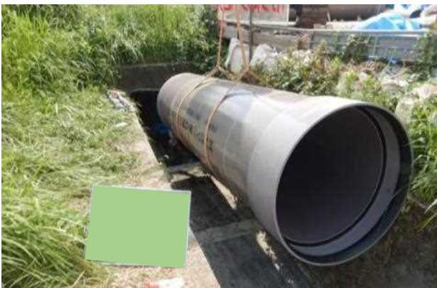
写真-3 FRPM管の吊下ろし状況
