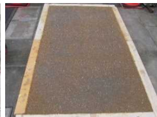
写真-6 施工完了
