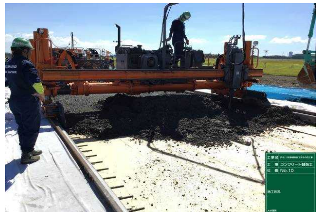
写真-4 コンクリートの状態確認
