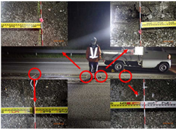
写真-6 埋設物直近支柱の離隔確認状況(立会)
