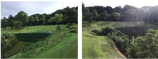
写真-3 崩壊部復旧完了
