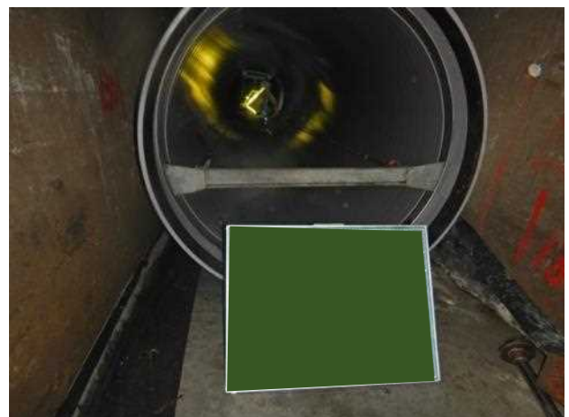
写真-7 FRPM管の接合状況
