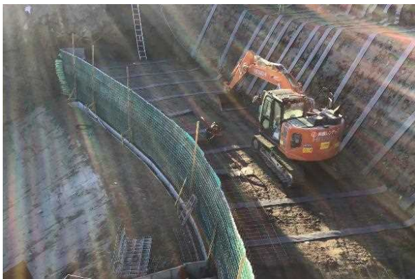
写真-8 パブリックドレーンの設置
