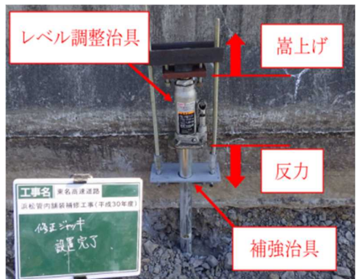
写真-4 レベル調整治具設置状況
