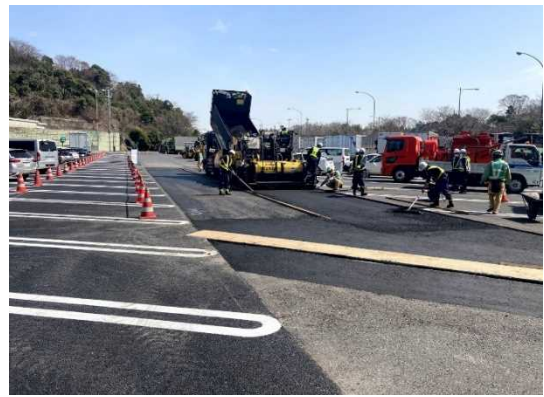
写真-1 HSアスコン施工状況
