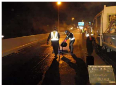
写真-9 防水材料の塗布状況
