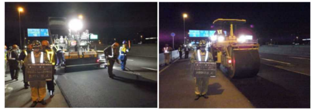
写真-11 表層の施工状況
