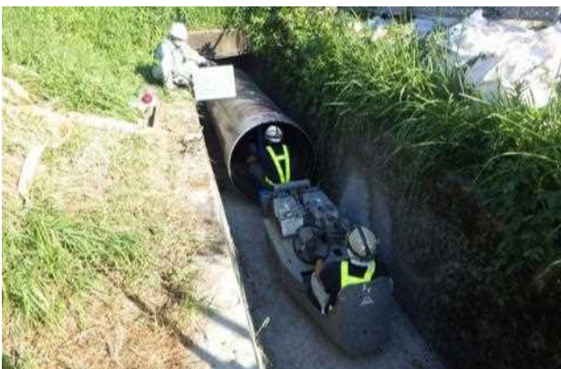
写真-4 既設排水路内でのFRPM管運搬状況(1)
