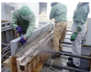
写真-1 水締めによる壁打設
