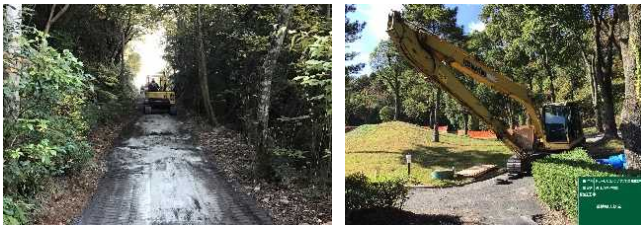
写真-7 スーパーロングアーム(14m級)搬入状況
