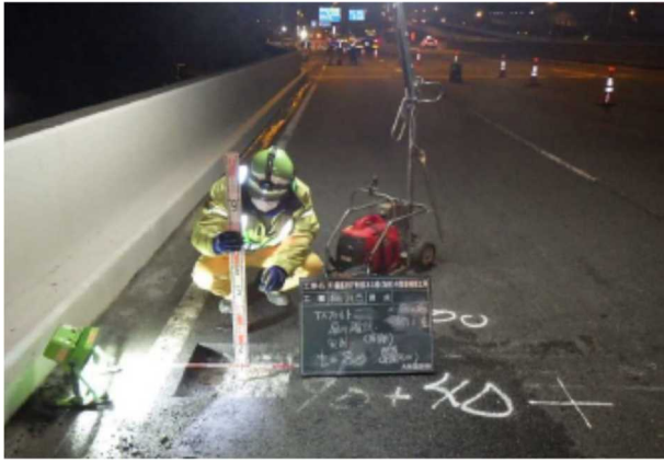
写真-1 既設防水の確認状況
