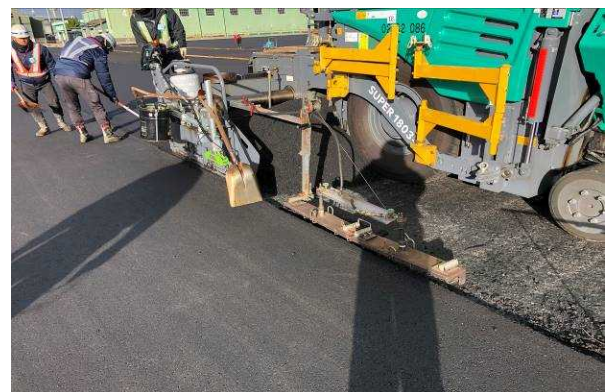
写真-9 L型ジョイントヒータによる加熱
