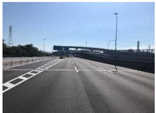
写真-20 施工完了状況
