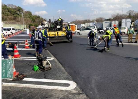
写真-2 タフアスコン施工状況
