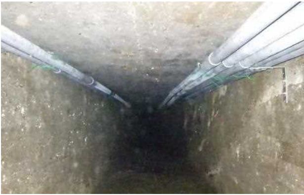
写真-2 塩ビ管の設置状況
