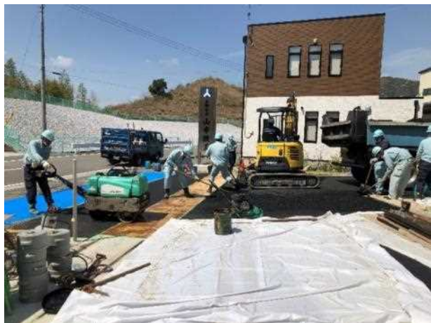
写真-3 人力による施工状況
