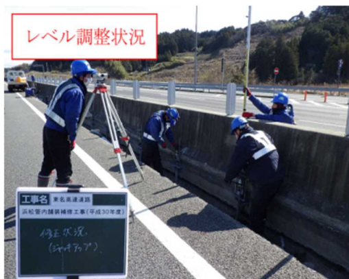
写真-5 レベル調整状況
