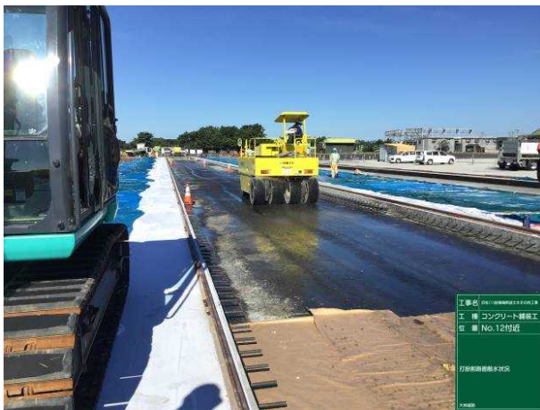
写真-1 散水による冷却
