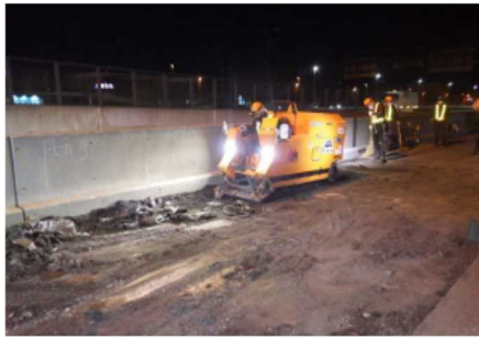
写真-8 剥ぎ取り機械による既設防水層の撤去状況
