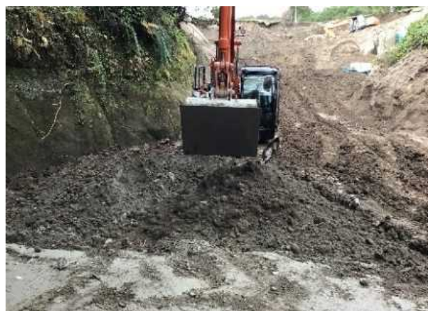
写真-6 重機走路のセメント改良
