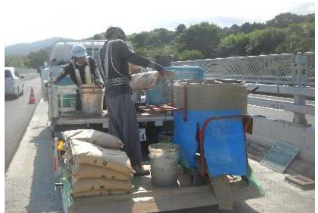
写真-4 HQモルタルの製造状況
