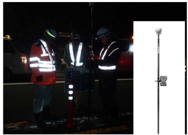
写真-4 GNSS機器による位置測量状況(センター管路位置)
