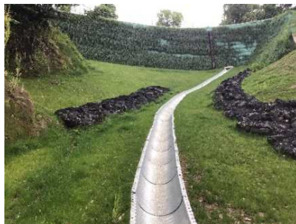
写真-10 崩壊土改良後の緑化状況
