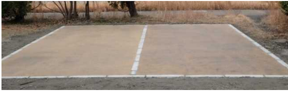
写真-7 施工場所(3か月後)
