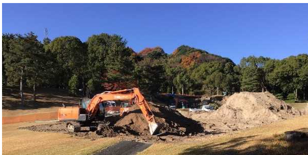
写真-4 レディースティー掘下げによる盛土材確保
