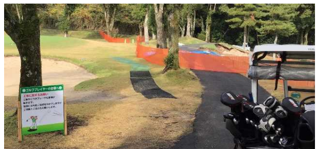
写真-5 工事お願い看板
