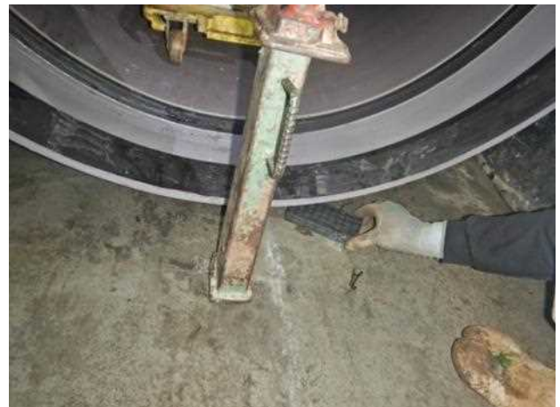
写真-6 管台設置状況
