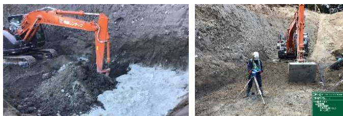
写真-11 基礎部改良・支持力確認状況
