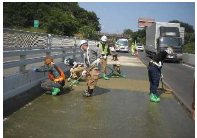
写真-5 HQモルタルの施工状況
