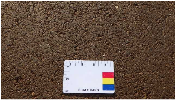
写真-18 舗装面の拡大
