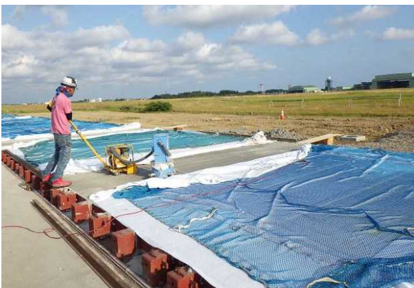
写真-6 乾式による目地カッタ切斷
