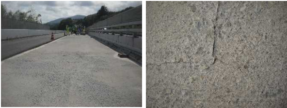
写真-1 既設コンクリート床版面の状況
