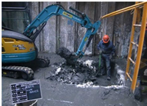
写真-9 小型バックホウによる攪拌状況
