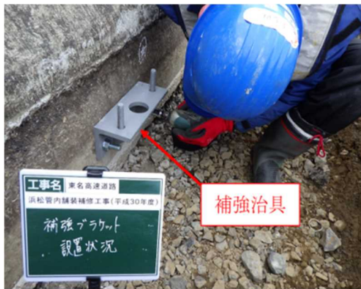
写真-1 補強治具器具設置状況
