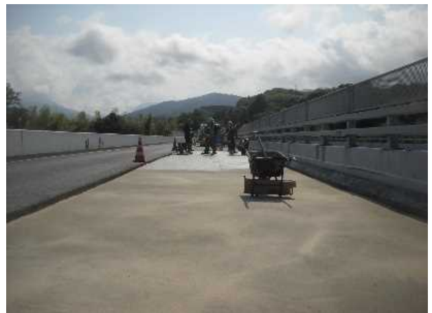
写真-6 グレードⅡ前下地処理の完成状況
