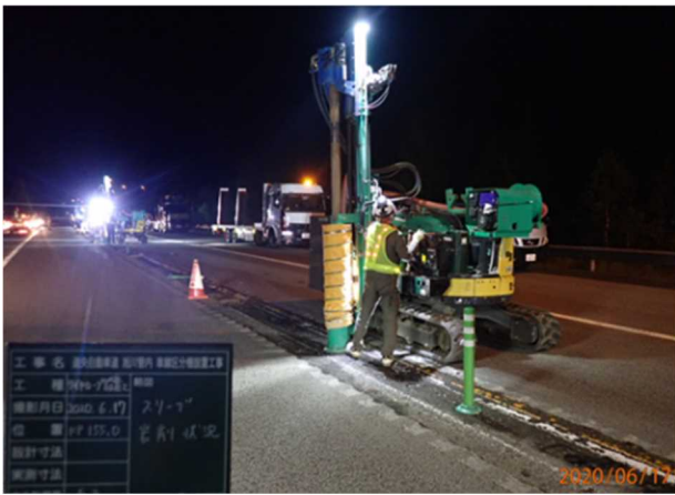
写真-2 スリーブ岩削状況
