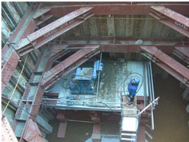
写真-4 路線防護水平注入状況
