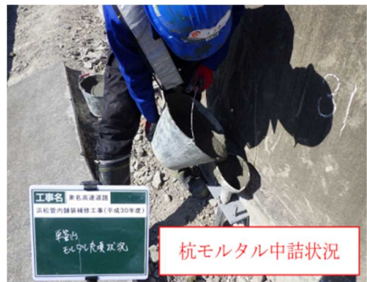
写真-3 杭モルタル中詰状況
