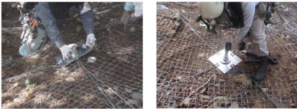
写真-2 ESプレート設置状況
