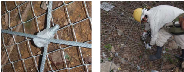
写真-3 クリップ設置状況
