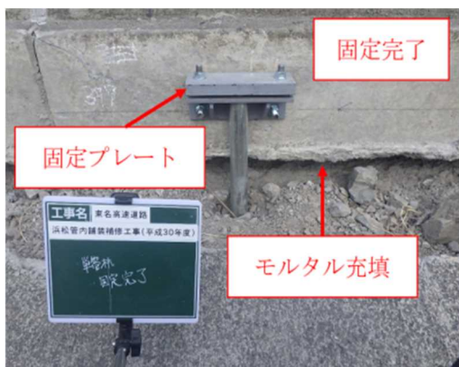
写真-7 固定完了
