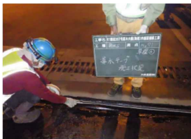
写真-10 導水テープの施工状況
