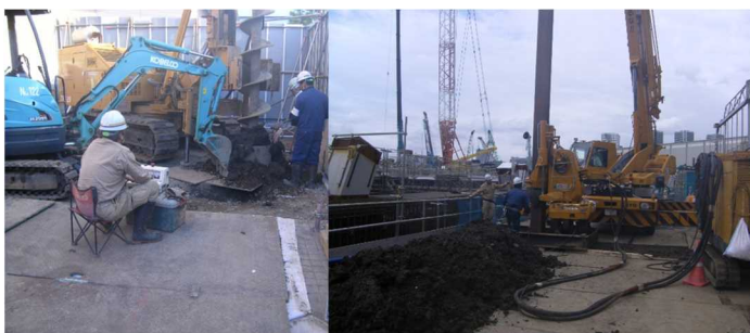
写真-1 シートパイル(IV型 L=11.5m)先行削孔・油圧圧入状況
