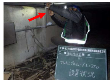
写真-7 フレキシブルチューブ(導水パイプ)設置状況
