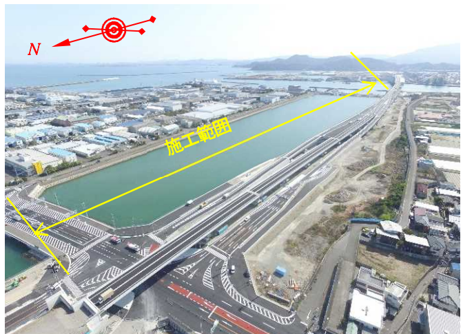
写真-1 現場施工範囲
