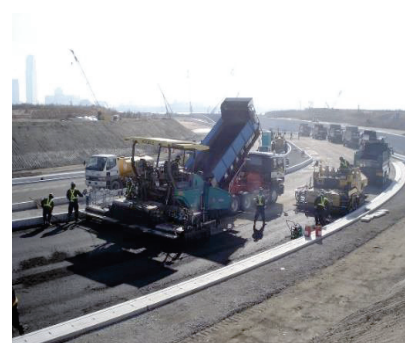
写真-1 従来の舗設状況
