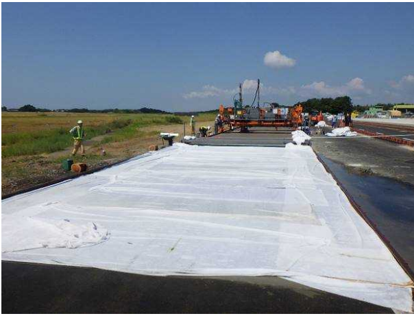
写真-5 打設直後の散水養生
