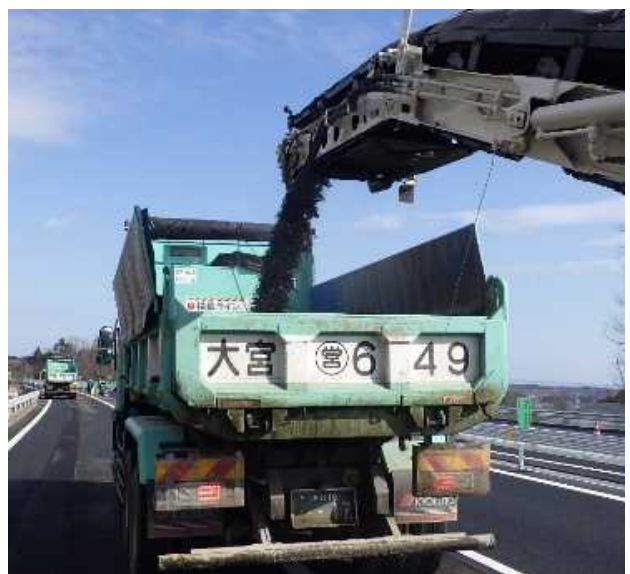
写真-6 切削廃材積込み(スケールダンプ)
