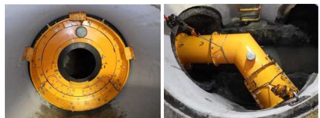
写真-3 スペーサープラグ、方向転換管の設置状況
