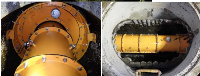
写真-2 吊込み状況→設置状況→設置完了状況
