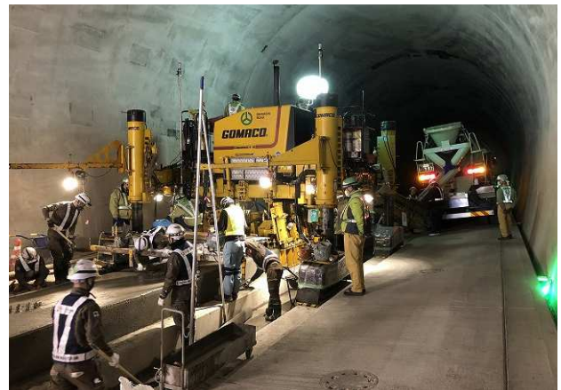
写真-2 本施工実施状況(第2鯖江トンネル)
