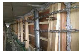
写真-8 モルタル注入工
