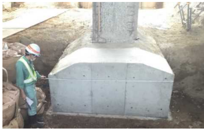
写真-3 底版拡幅補強
