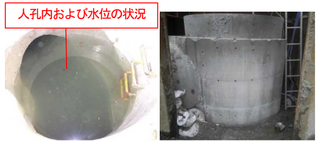
写真-6 人孔内外の状況
