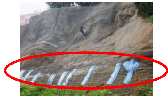
写真-6 裏面排水材を敷設状況
