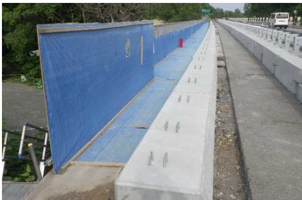
写真-4 地覆コンクリート施工完了
