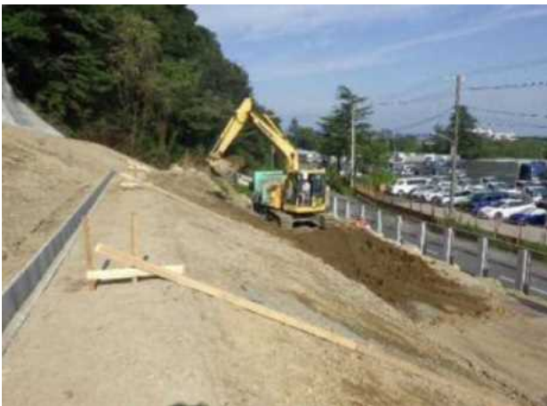
写真-8 法面整形状況
