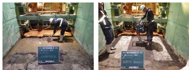
写真-6 ボックスカルバート基礎工
