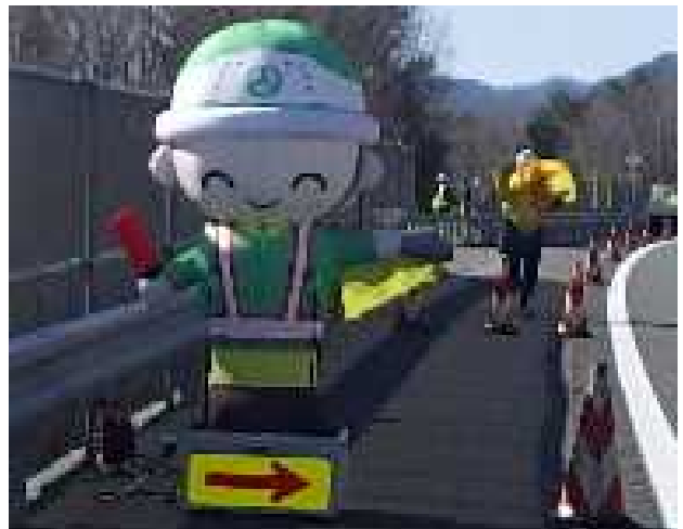
写真-5 バルーン設置
