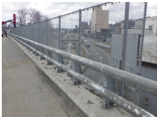
写真-9 鋼製高欄塗装変性後
