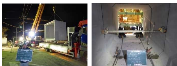
写真-7 ボックスカルバートの敷設(その1)
