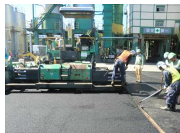
写真-3 試験施工状況
