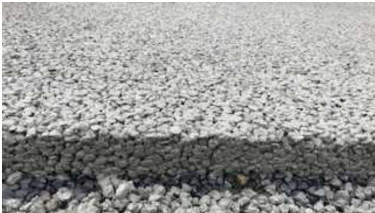
写真-4 ポーラスコンクリート断面
