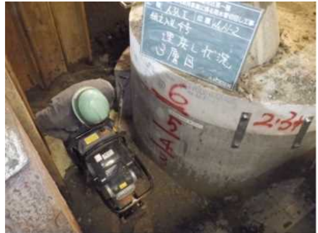
写真-7 人孔まわり締め固め状況
