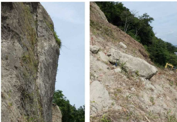
写真-3 亀裂による板状剥離箇所およびブロック崩落跡
