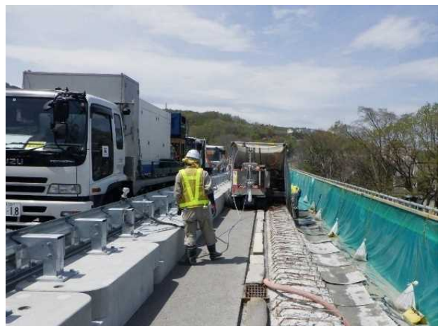
写真-1 WJ施工状況
