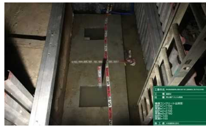
写真-1 均しコン完了
