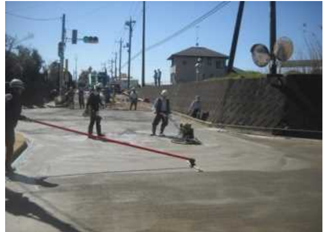
写真-6 平たん仕上げ状況
