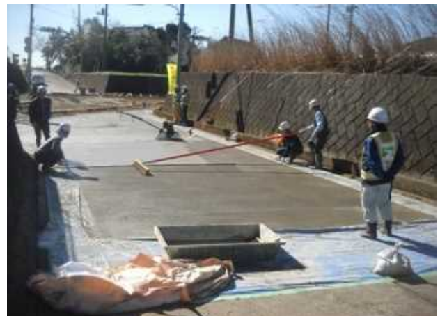
写真-7 粗面仕上げ状況
