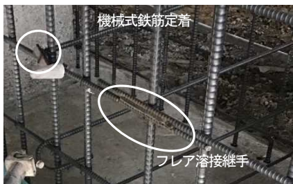
写真-6 帯鉄筋定着・継手
