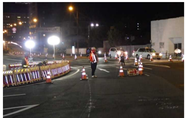
写真-3 交差点監視員の配置
