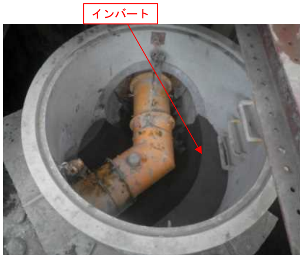
写真-5 インバートコンクリートの打設完了状況
