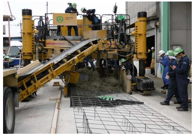
写真-1 試験施工実施状況
