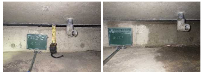
写真-5 延長床版と踏掛版の開き(施工前、施工後)
