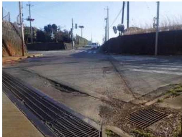
写真-1 既設コンクリート版の状況
