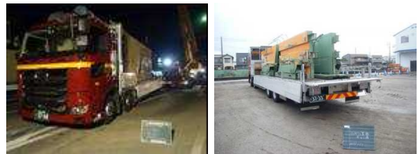
写真-10 OSJ機の解体・搬出・運搬
