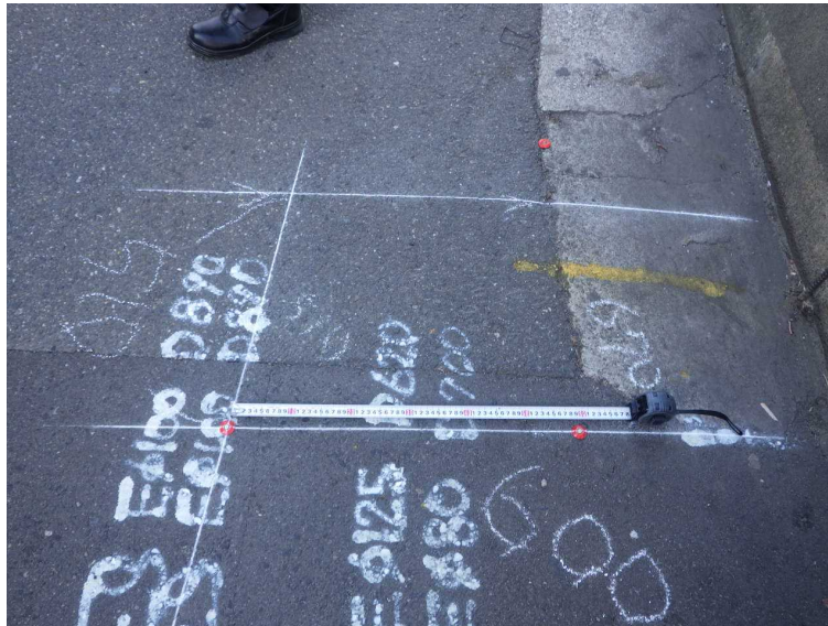
写真-6 現地埋設物マーキング
