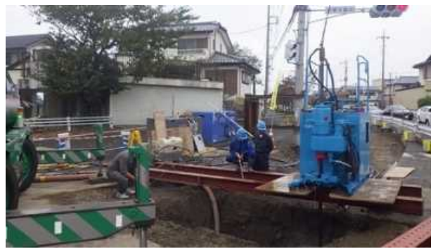
写真-2 JSG機作業状況
