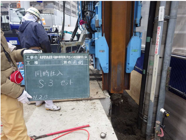
写真-3 施工状況—鋼矢板圧入
