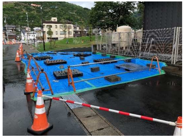
写真-5 舗装面の台風養生
