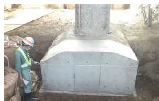
写真-4 底版拡幅完了
