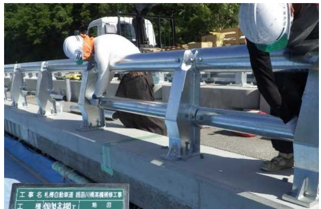
写真-5 鋼製高欄A1取り付け状況
