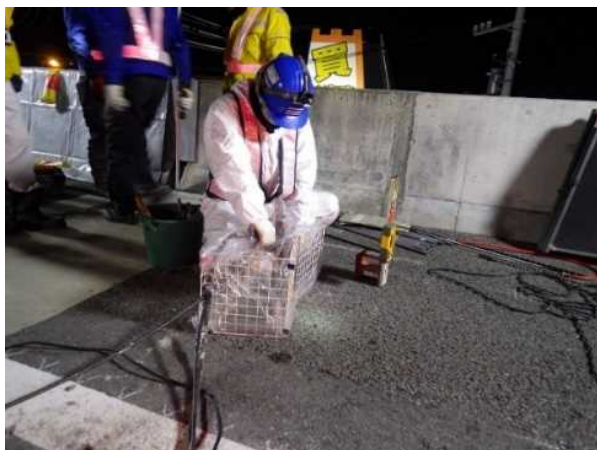
写真-3 注入状況
