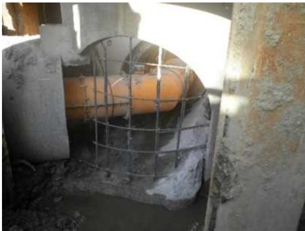
写真-4 人孔まわりの施工状況
