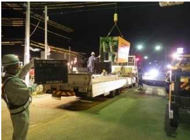
写真-3 OSJ 機の搬入状況
