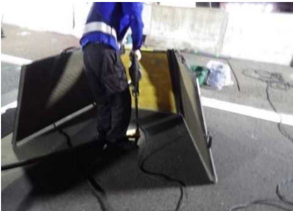
写真-2 削孔状況
