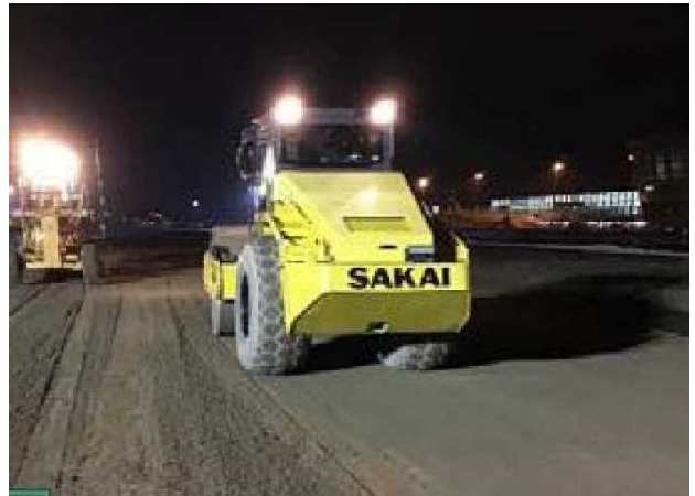
写真-1 本システムを使用した締固め状況
