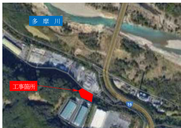
写真-2 法面崩壊(工事)箇所(Google Mapから引用) 当該箇所は多摩川河川段丘の縁に位置する。
