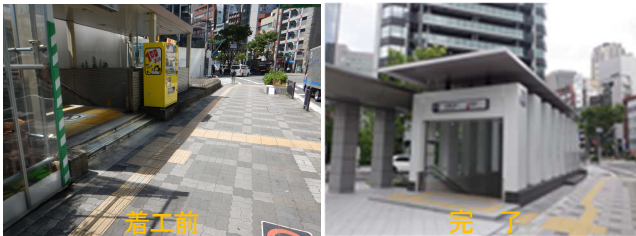
写真-1 着工前および完了
