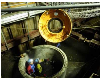
図-7 スペーサープラグとバイパス管の設置図
