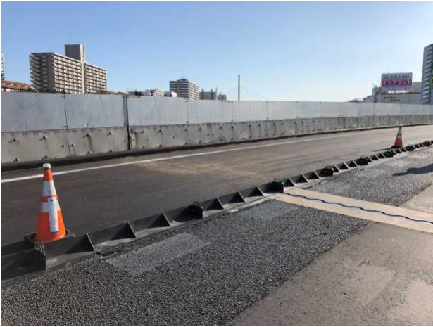
写真-1 鋼製型枠設置状況
