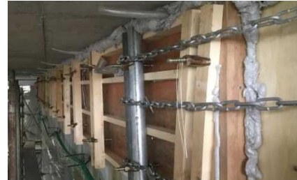
写真-8 モルタル注入工
