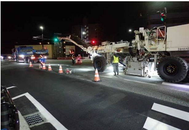
写真-1 交差点中央部の施工(例)
