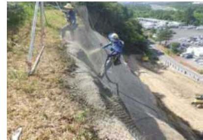
写真-5 モルタル吹付け状況
