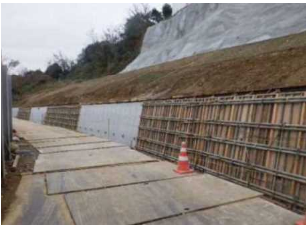
写真-9 擁壁型枠設置状況
