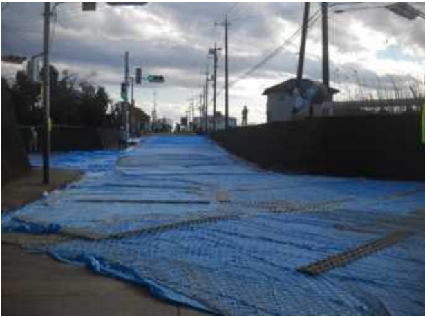
写真-8 養生状況
