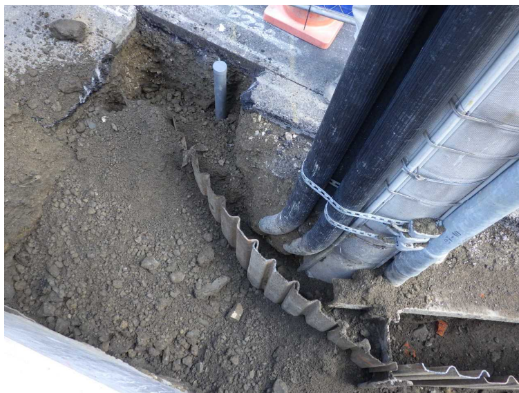
写真-7 埋設管防護
