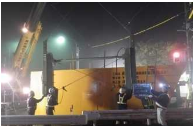
写真-4 OSJ 機の組立
