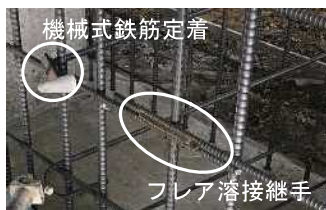
写真-7 帯鉄筋定着・継手
