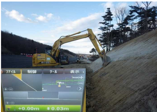
写真-3 ICT バックホウおよびモニター
