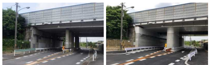
写真-9 着工前・完成(A1橋台、P1橋脚)
