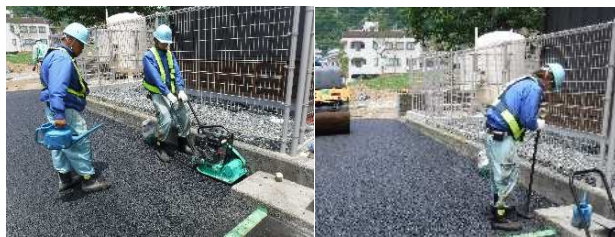
写真-2 表層における端部の締固め
