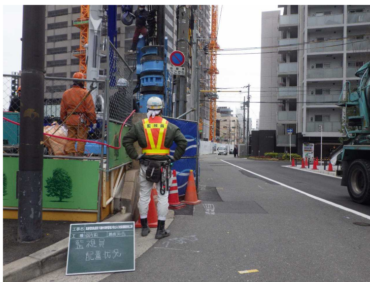
写真-8 道路占用・施工状況
