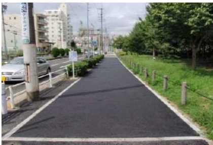
写真-1 保水性アスファルト舗装
