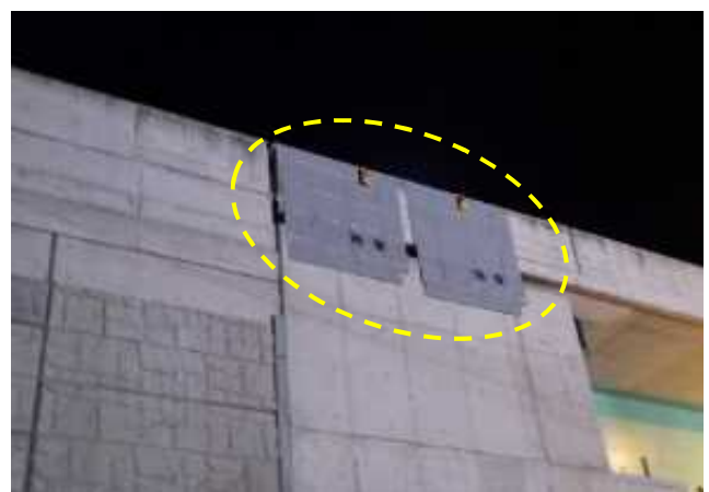
写真-6 防音シート設置状況
