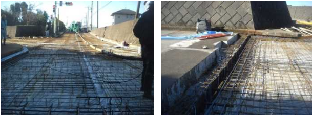
写真-3 目地金物等の設置状況
