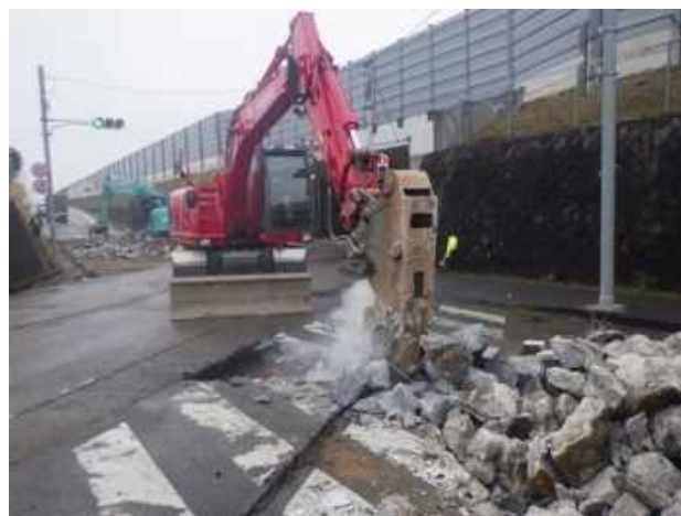
写真-2 既設コンクリート版の撤去状況
