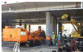
写真-3 補強杭施工状況
