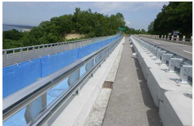
写真-7 鋼製高欄A1取り付け完了
