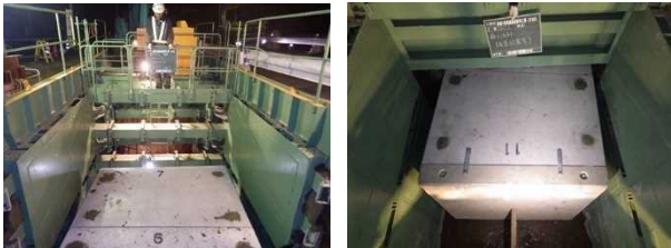
写真-8 ボックスカルバートの敷設(その2)
