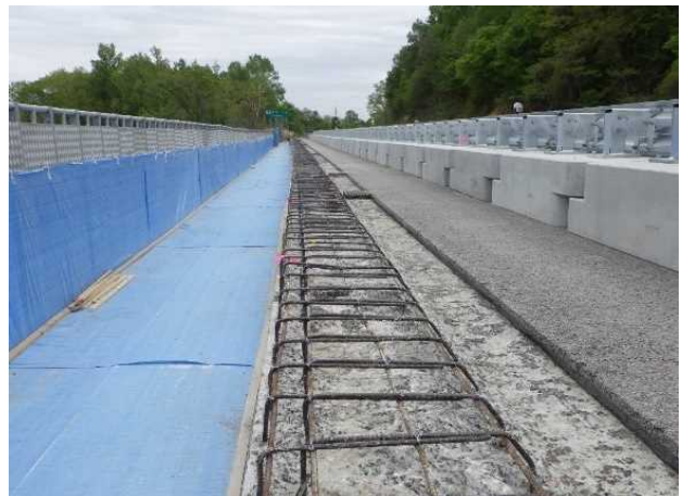
写真-2 WJ施工完了
