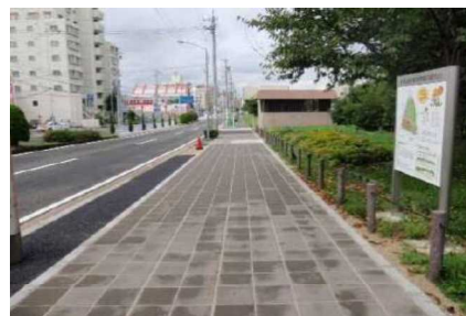
写真-2 保水性ブロック舗装
