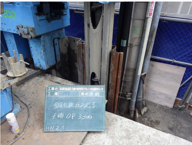
写真-4 施工状況—鋼矢板圧入完了
