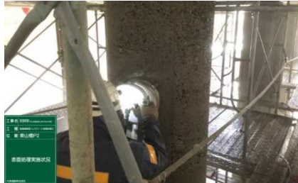
写真-4 表面処理状況
