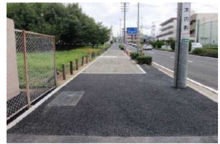
写真-3 透水性アスファルト舗装
