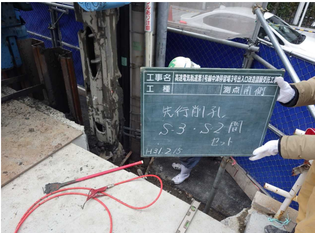
写真-2 施工状況—先行削孔
