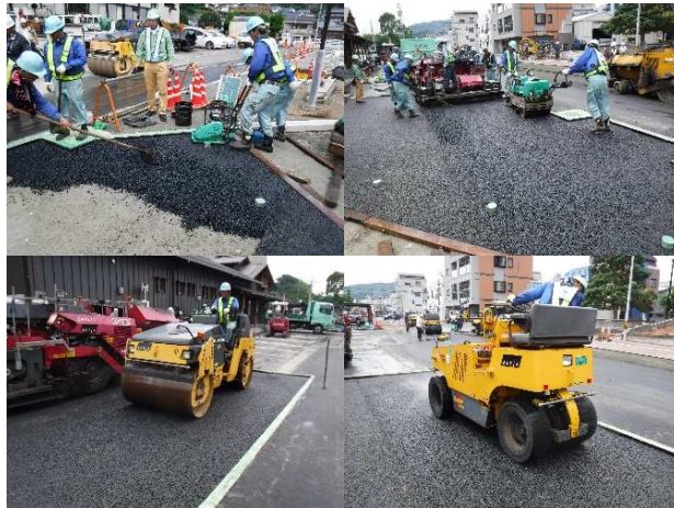
写真-1 基層の舗設状況
