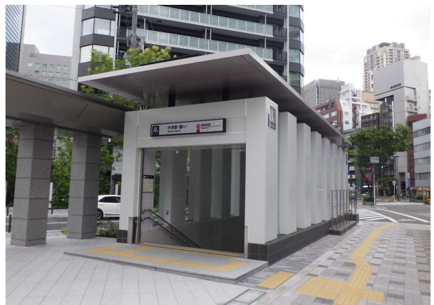
写真-5 完成写真
