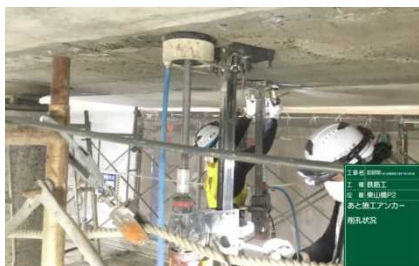
写真-5 鉄筋定着部削孔
