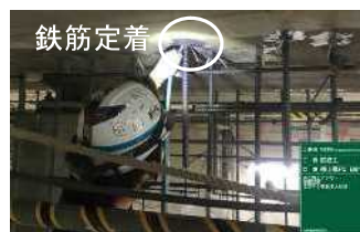
写真-6 軸方向鉄筋定着
