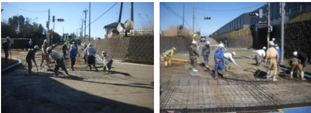
写真-4 敷きならし・締め状況
