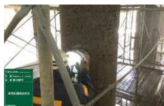
写真-5 表面処理工
