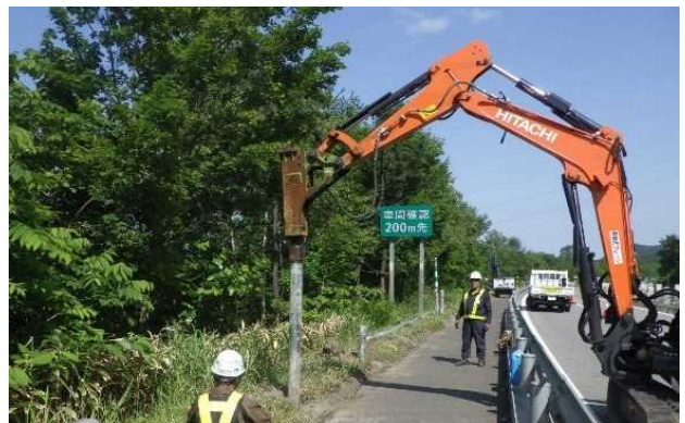
写真-6 防護柵支柱打込み状況
