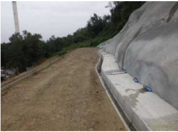
写真-7 法面側溝の施工状況
