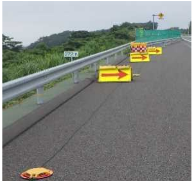
写真-4 ミチテラ設置
