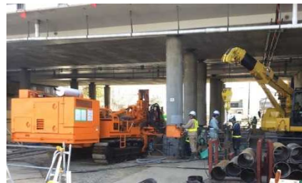
写真-2 基礎杭施工状況
