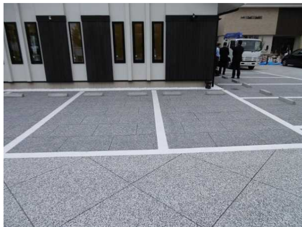
写真-9 車室部の明確化
