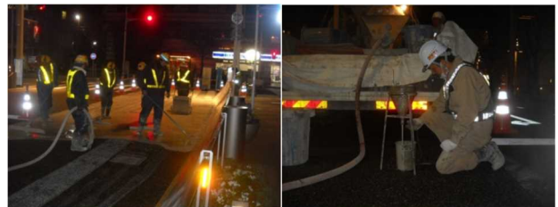
写真-7 保水材の注入状況
