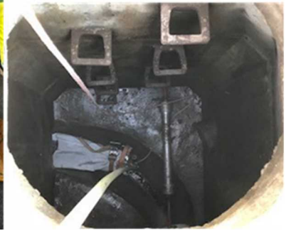
メインライナー挿入後のエンドパッカー設置
