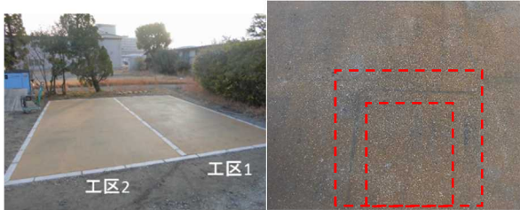
写真-4 施工完了後
