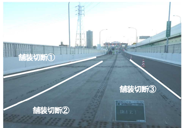
写真-3 既設舗装撤去完了状況(走行車線)
