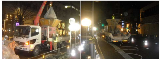
写真-6 保水材の製造状況
