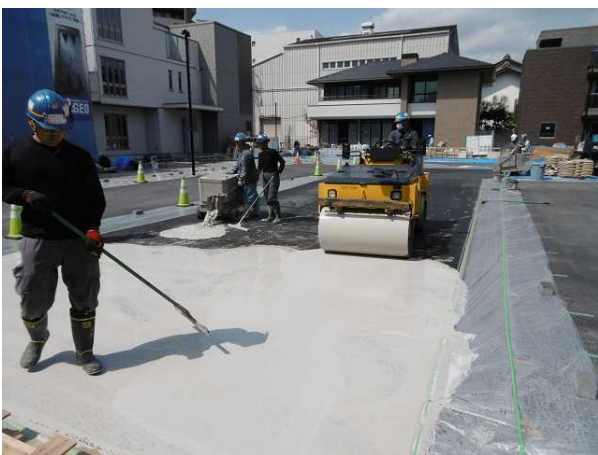
写真-3 保水材充填状況(通路部)
