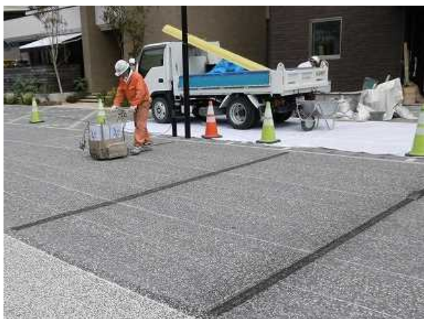
写真-7 路面標示用プライマー散布状況
