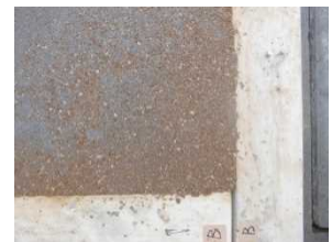
写真-3 施工完了後(2)
