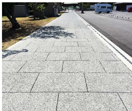
写真-1 横長の馬目地 5:4 W1000×D800 1/2 ずらし
