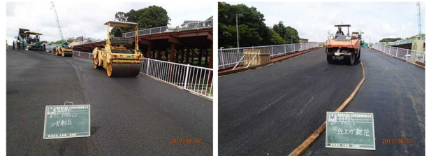
写真-8 表層工施工状況 (転圧)
