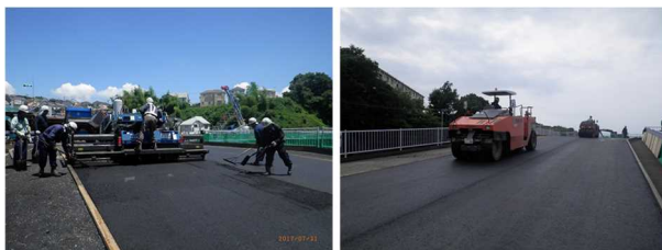
写真-6 基層工施工状況
