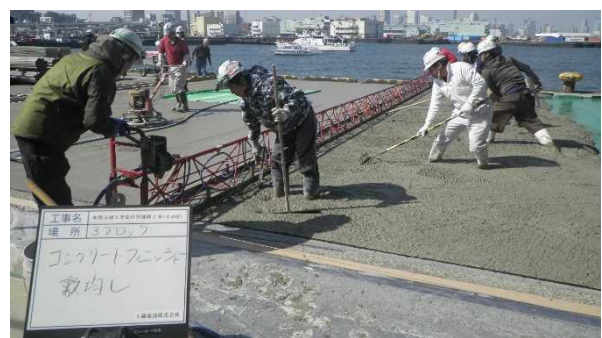
写真-3 レーザーバックによる敷きならし状況
