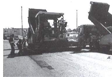
写真-8 MCAs/F による施工状況
