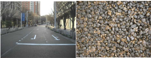
<自然色排水性混合物の舗設後>
