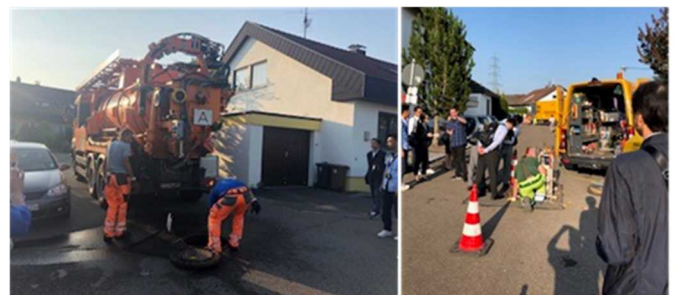
大型洗浄車による管内洗浄
