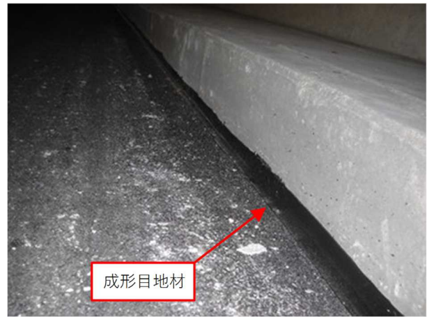
写真-9 端部成形目地材貼り付け
