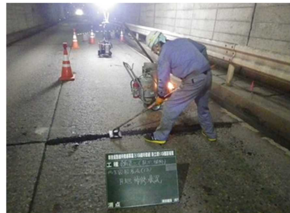
写真-4 目地補修状況
