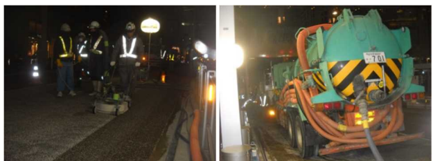
写真-9 WJ施工状況
