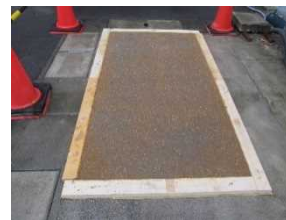
写真-2 施工完了後(1)
