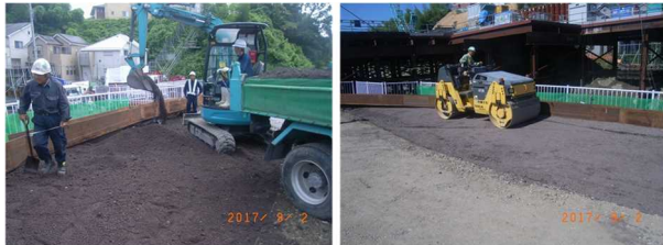
写真-5 路盤工 (軽量骨材) 施工状況
