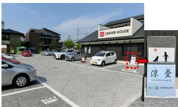
写真-10 オープン後の涼畳の状況と工法説明看板
