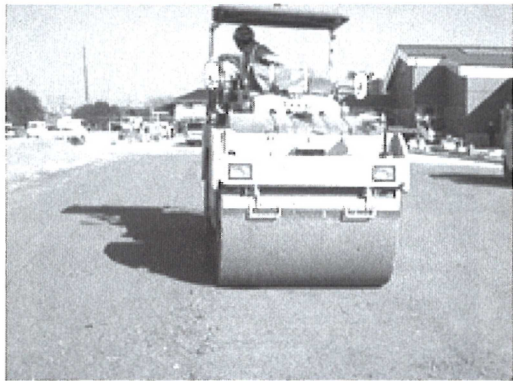
写真-6 \alpha システムによる転圧状況
