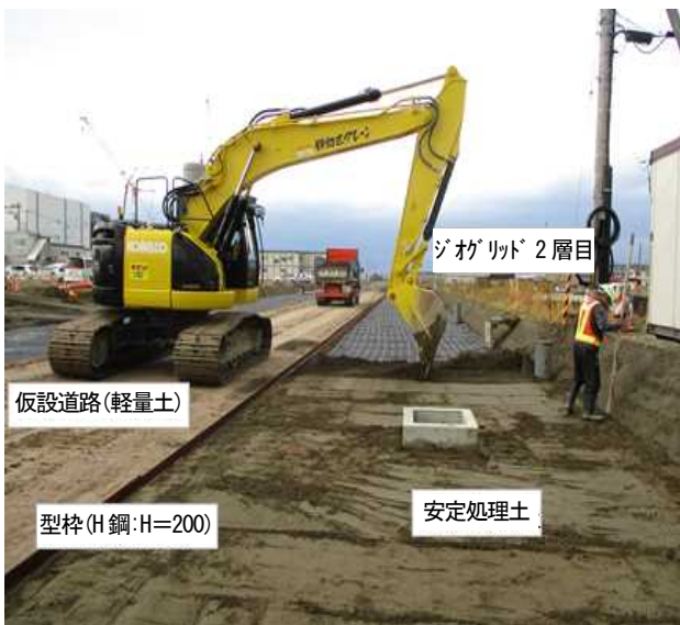
写真-2 安定処理土の敷きならし
