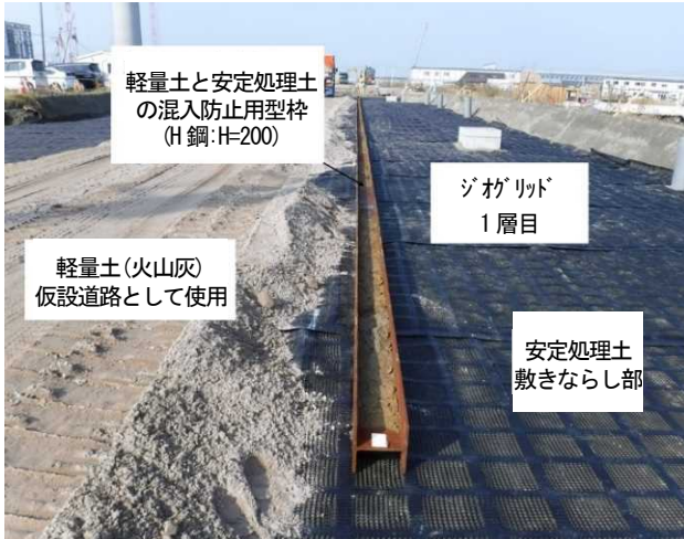
写真-1 仮設道路と型枠
