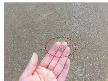
写真-9 工区2の近接写真(2ヶ月後)
