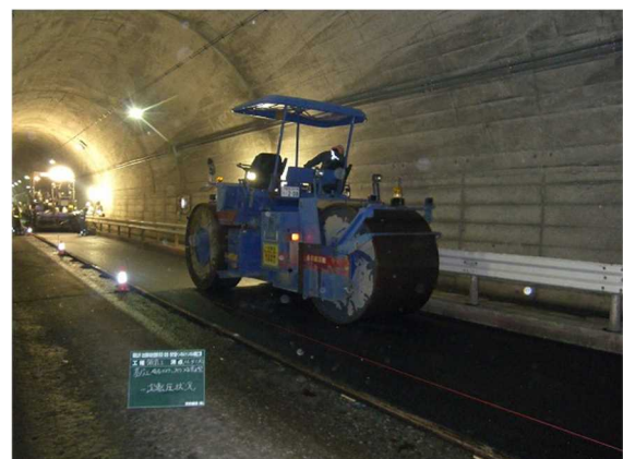
写真-6 転圧状況(マカダムローラ)
