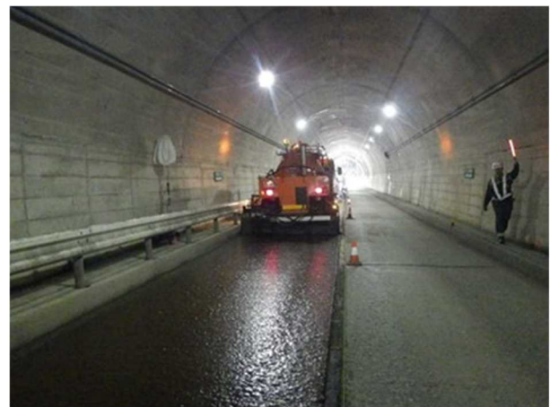
写真-10 タックコート工 乳剤散布状況
