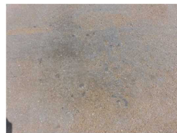
写真-8 工区1の近接写真(2ヶ月後)
