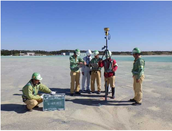
写真-3 沈下板収束立会状況
