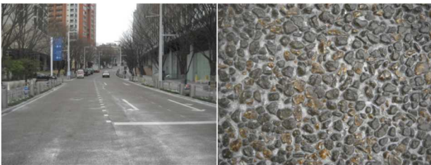
<保水材の注入後>
