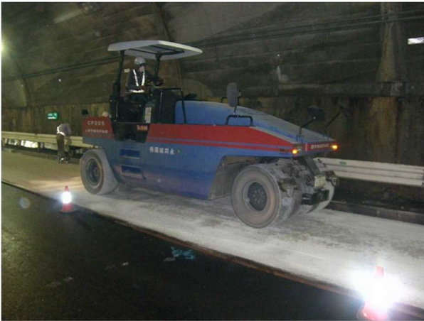
写真-13 二次転圧状況(タイヤローラ)
