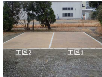
写真-7 施工から2ヶ月後
