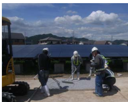
写真-4 砕石敷ならし状況
