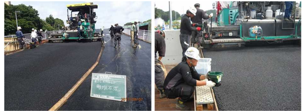
写真-7 表層工施工状況 (敷きならし、ゴムチップ散布)
