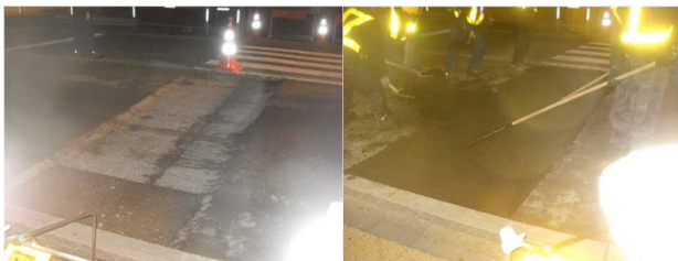
写真-4 既設舗装ひび割れ箇所の施工状況
