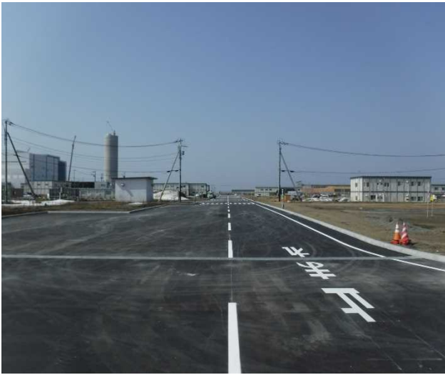
写真-4 完成写真(車道舗装)
