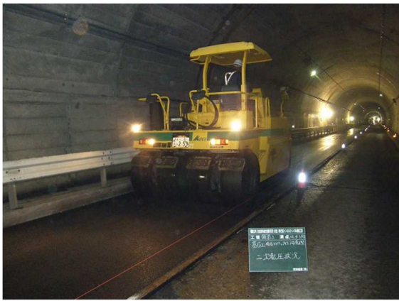
写真-7 転圧状況(タイヤローラ)
