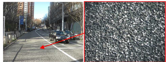
写真-2 平成30年2月時点の既設舗装の状況
