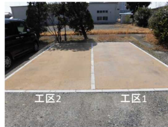
写真-6 施工完了後
