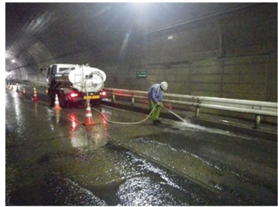
写真-3 既設コンクリート舗装清掃状況
