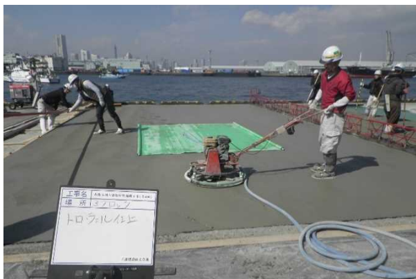
写真-5 トロウセル仕上げ状況
