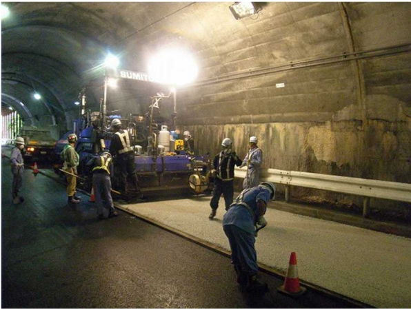
写真-11 敷きならし状況
