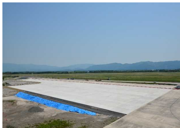
写真-7 完成状況
