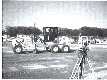
写真-5 MCMG による敷きならし状況
