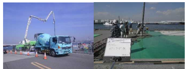
写真-2 ポンプによる打設状況
