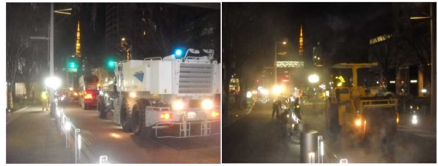
写真-5 自然色排水性舗装の舗設状況
