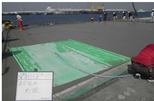
写真-4 真空処理状況
