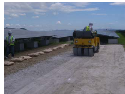
写真-3 転圧状況
