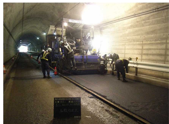
写真-5 敷きならし状況
