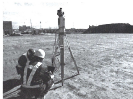
写真-4 TLSによる路床盛土工の出来形測定状況
