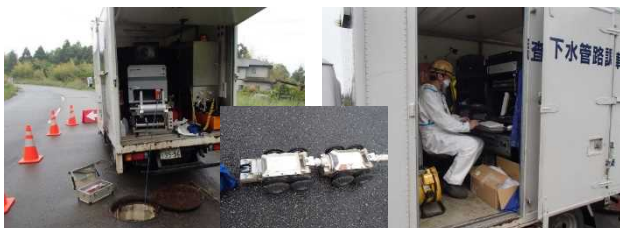
写真-6 下水管のカメラ調査
