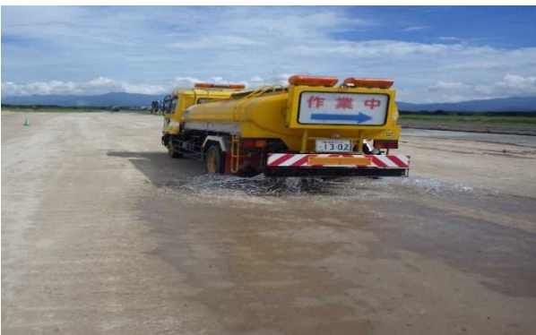
写真-4 散水状況
