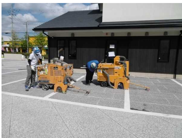
写真-8 カッタ目地施工状況
