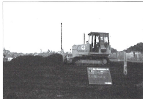
写真-3 MCブルドーザによる路床盛土施工状況
