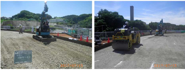
写真-4 路盤工 (RM-40) 施工状況
