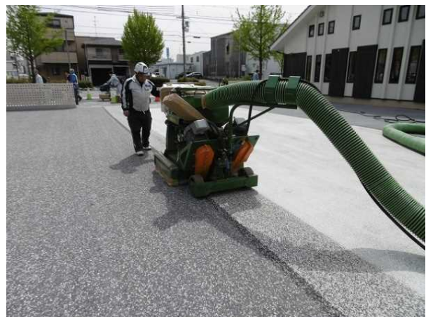
写真-6 通路部における研掃状況
