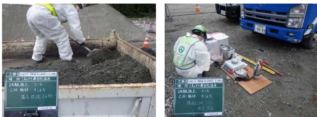
写真-5 再資源化試験施工状況
