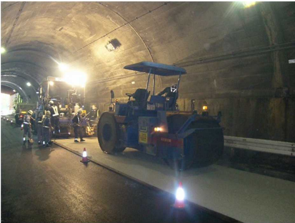
写真-12 初転圧状況(マカダムローラ)
