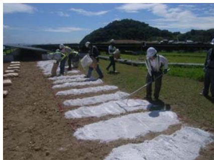
写真-1 固化材敷ならし状況
