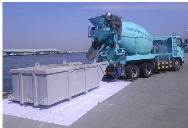
写真-6 洗浄水投入状況
