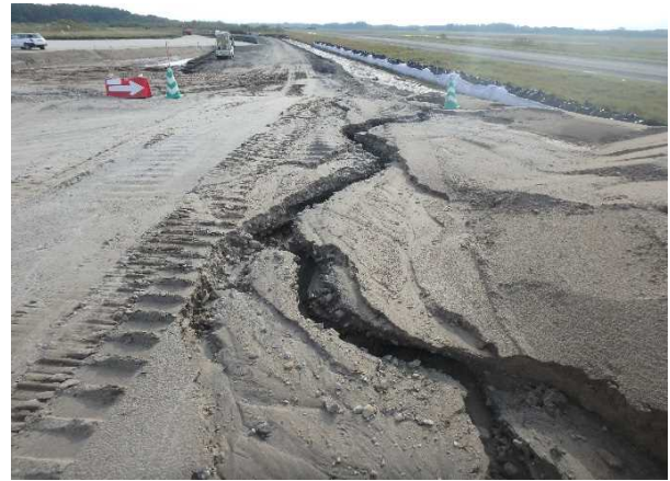
写真-6 雨水による浸食
