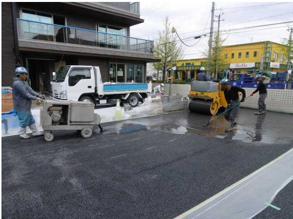
写真-2 保水材充填状況(車室部)
