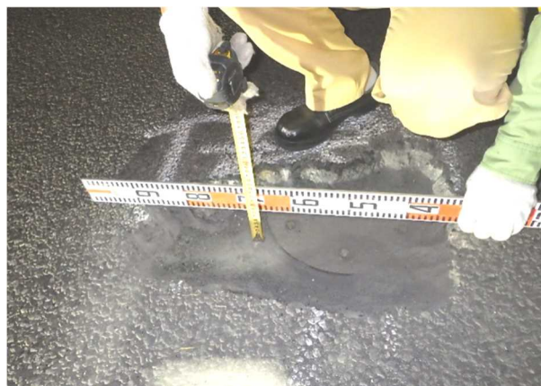
写真-2 人力撤去による目視確認状況
