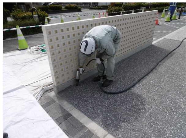
写真-5 ジェットタガネによる研掃状況
