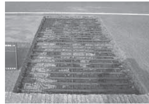
写真-6 はつり施工後の状況
