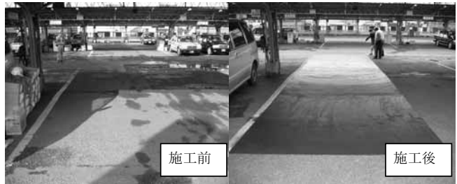
写真一五 施工事例①
