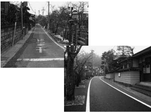
写真-11 施工前風景と施工後風景
