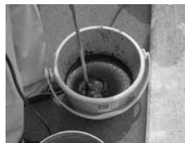
写真-1 攪拌混合状況
