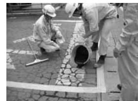
写真-2 流し込み状況
