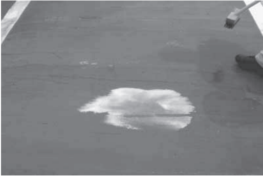
写真-10 洗浄状況
