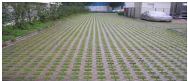
写真-4 緑化舗装現況
