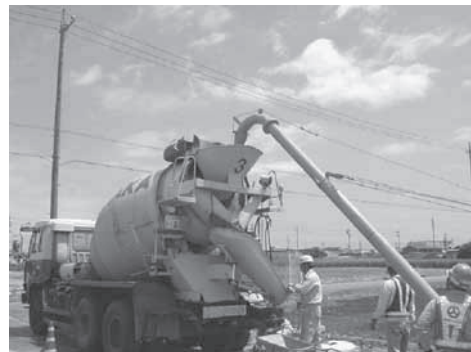
写真-2 ファイバー混合状況
