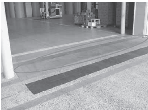
写真－6 施工2ヶ月後
