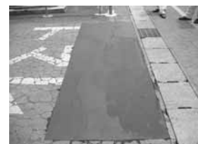
写真-4 施工完了
