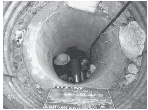
写真-5 新設管押込み状況
