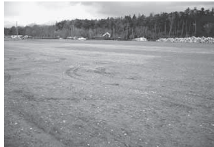
写真-9 路盤完成
