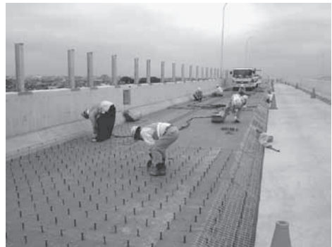
写真-4 スタッド施工状況
