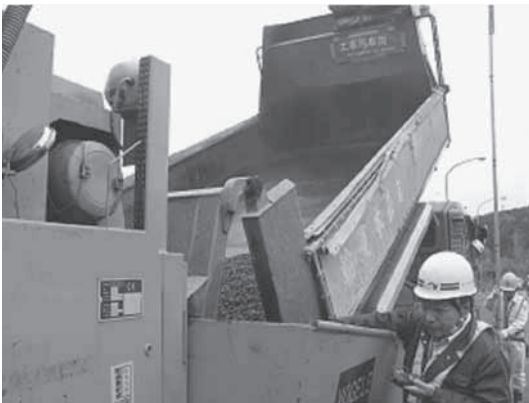
写真-5 荷下ろし状況
