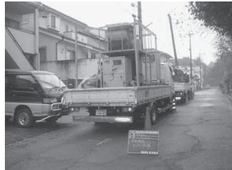
写真-8 モルタル打設プラント車
