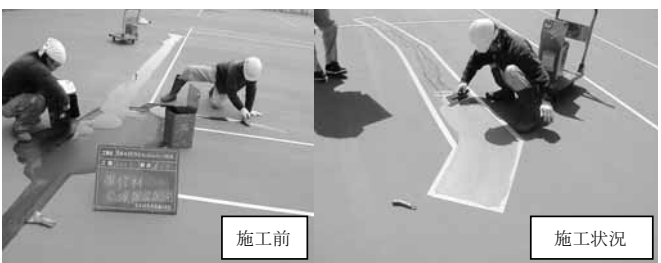
写真一九 施工事例⑤
