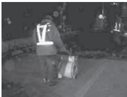
写真-8 余剰保水材吸取り
