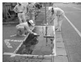
写真-3 敷き均し状況
