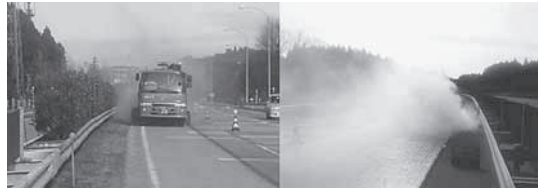
写真-4 防水材料の散布状況
