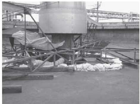
写真-6 汚泥沈殿槽中央部
