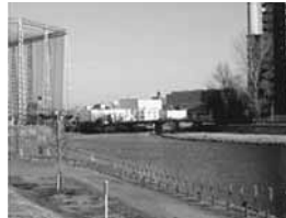
写真－1 橋の全景
