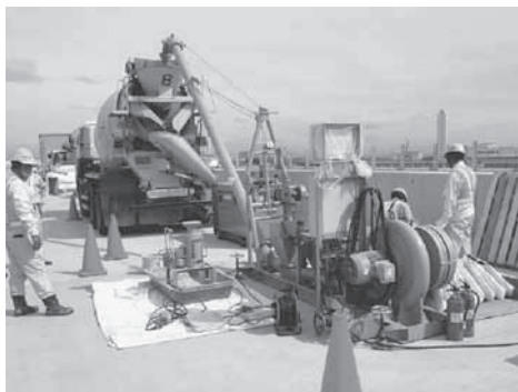
写真-5 ファイバー投入状況
