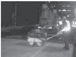
写真-7 振動による注入
