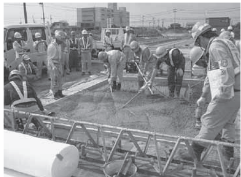
写真-3 ファイバー施工状況
