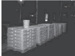
写真-2 保水材の現場搬入
