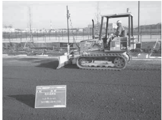
写真-1 ブルドーザによる施工状況（1）
