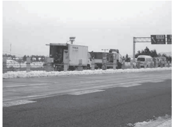
写真-2 中越震災復旧施工状況
