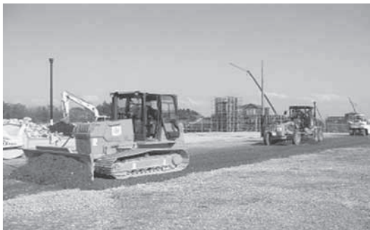
写真-8 2台同時に施工
