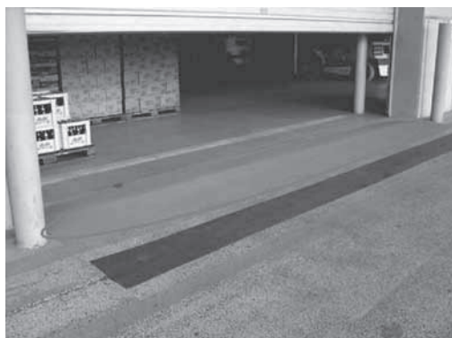
写真-5 施工直後
