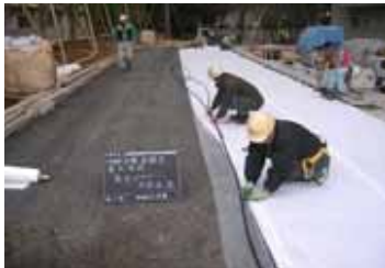
写真-1 灌水用点滴パイプ設置状況
