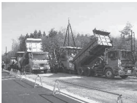
写真-6 ホットジョイントによる施工
