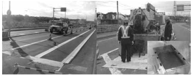
写真—1 型枠設置
