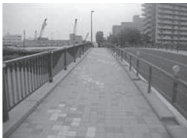
写真-5 歩道部タイル舗装
