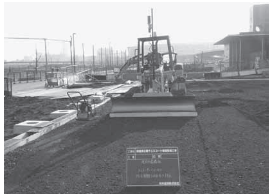
写真-2 ブルドーザによる施工状況（2）
