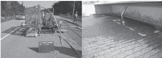
写真-5 コンクリート除去装置およびノズル部分
