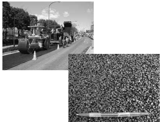
写真-10 施工風景と表面
