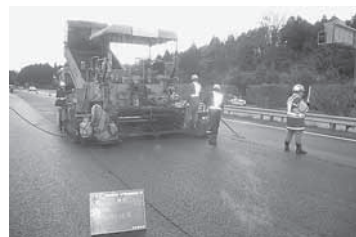
写真-2 ハイブリッド舗装の敷きならし状況
