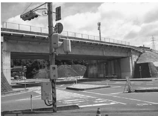
写真-1 施工現場
