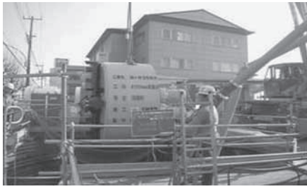
写真-2 掘進機の投入状況
