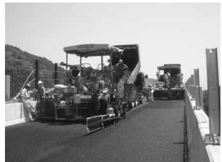
写真-3 施工状況
