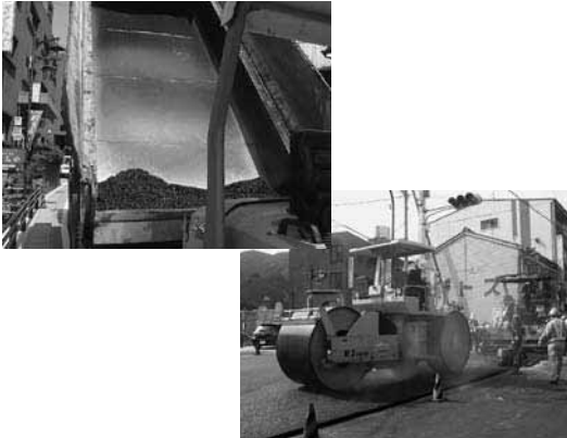
写真-7 ダンプアップ時と施工風景
