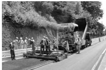
写真-1 ロール式を使用した施工状況
