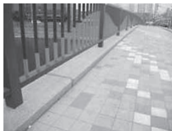
写真-8 擬石調の地覆コンクリート
