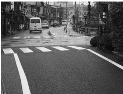
写真-12 視認性の向上 (奥：既設密粒度区間 手前：水とりこまちは区間)
