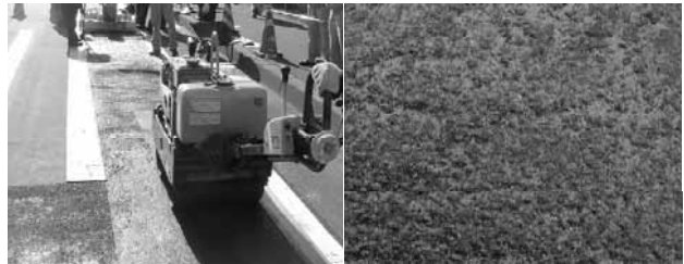
写真—5 転圧状況
