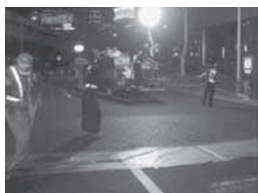
写真-14 骨材の散布
