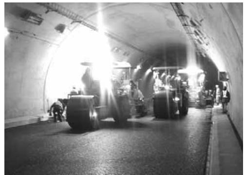
写真-2 初期転圧状況
