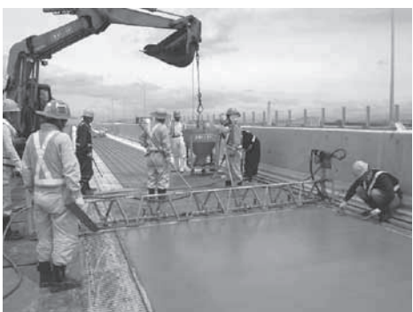
写真-6 SFRC打設状況
