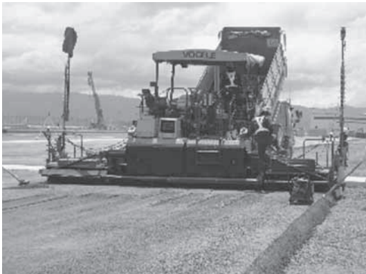
写真-7 ベースペーパーの施工状況図
