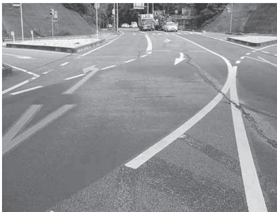
写真-3 施工6ヶ月後の状況
