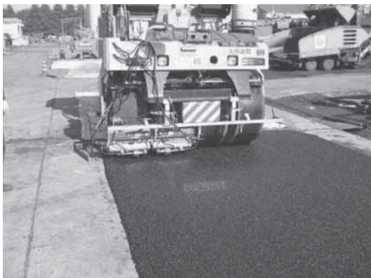
写真-2 試験施工二次転圧状況
