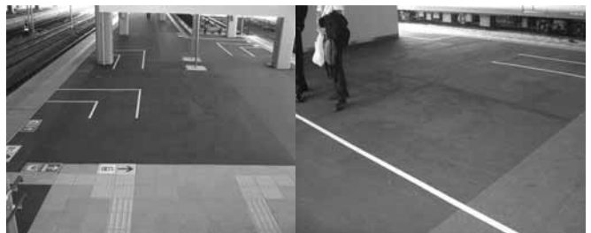
写真一七 施工事例③(施工後)
