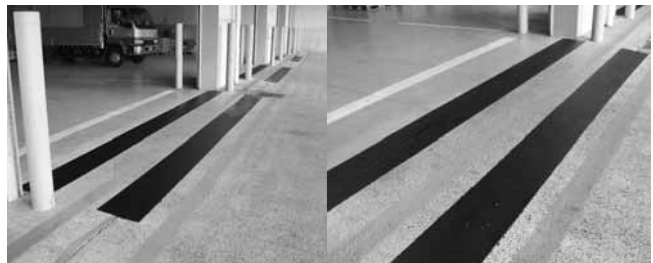
写真一六 施工事例②(施工後)
