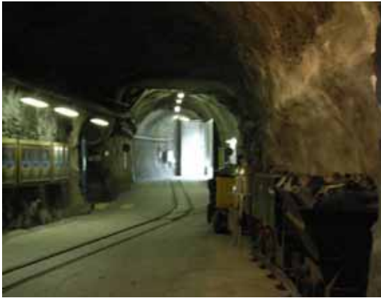
写真-2 実験用トンネルの内部
