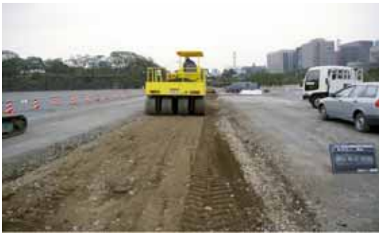
写真－5 路床転圧状況
