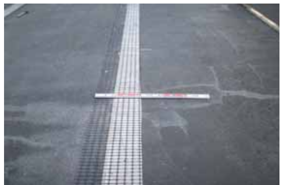
写真-3 ジオグリッドの設置完了
