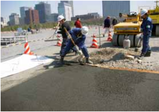
写真－13 コーナ部の円弧上すり付け
