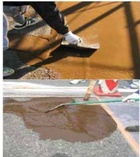
写真—3 敷きならし状況
