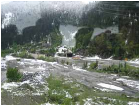
写真-11 1978年開通 アールベルグトンネルの入り口
