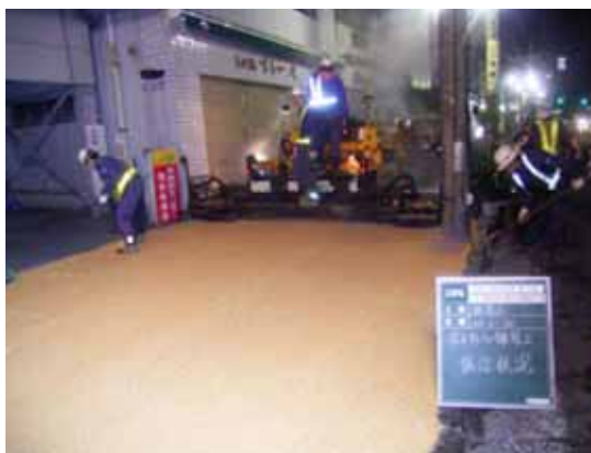
写真-2 舗設状況
