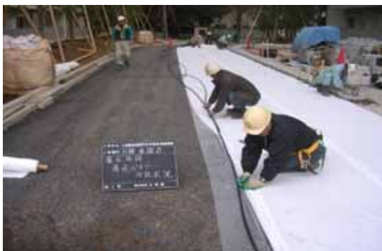
写真-1 灌水用点滴パイプ設置状況
