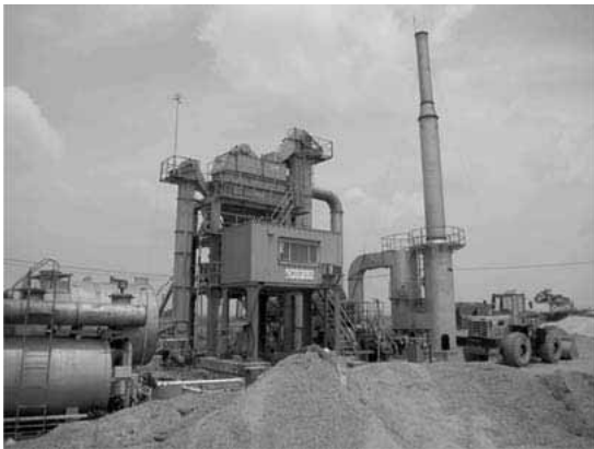
写真-1 ザーラム側アスファルトプラント
