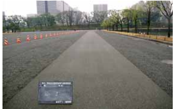
写真－14 完成後の状況
