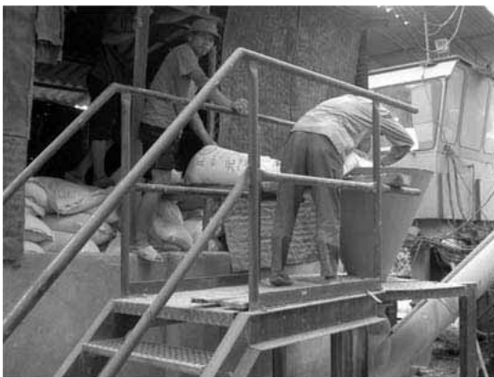
写真-2 人力による石粉の投入状況
