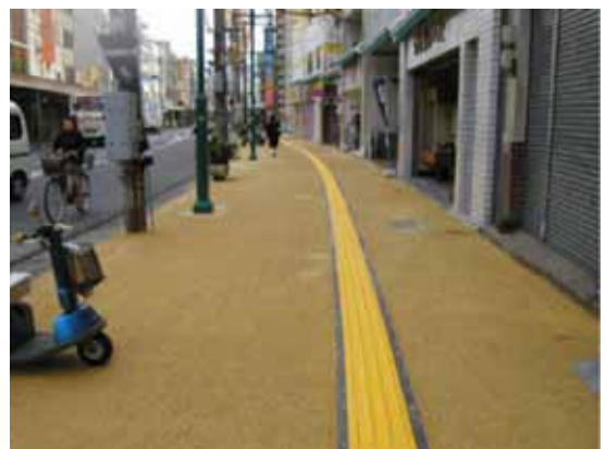
写真-1 施工完了
