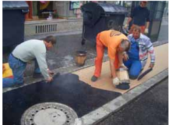
写真-13 路盤紙を敷き、コテで均す。
