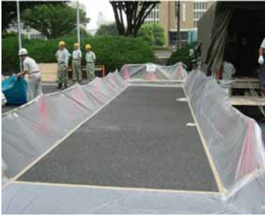
写真-2 施工前（清掃、マスキング終了時）
