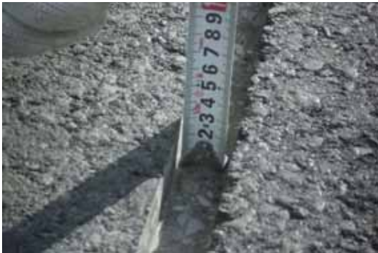
写真-1 点滴パイプ用溝
