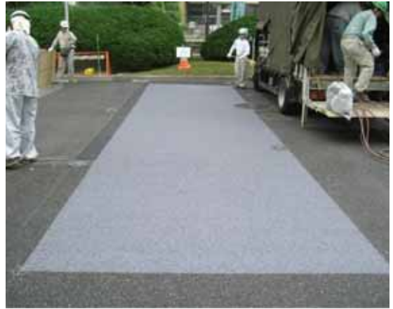
写真-5 施工完了
