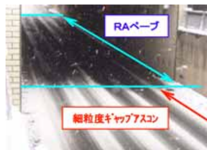
写真-4 供用後状況（冬期）
