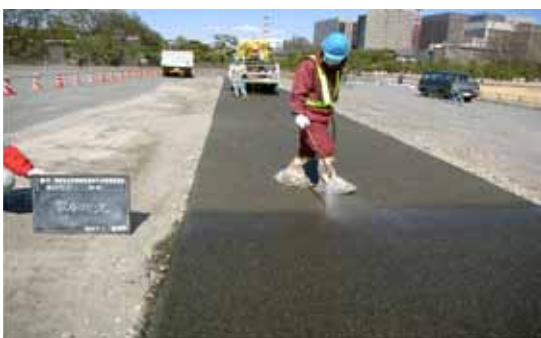
写真－9 樹脂コート工の状況
