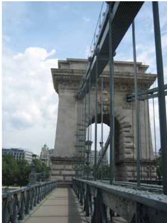
写真-16 セーチェニくさり橋の歩道部
