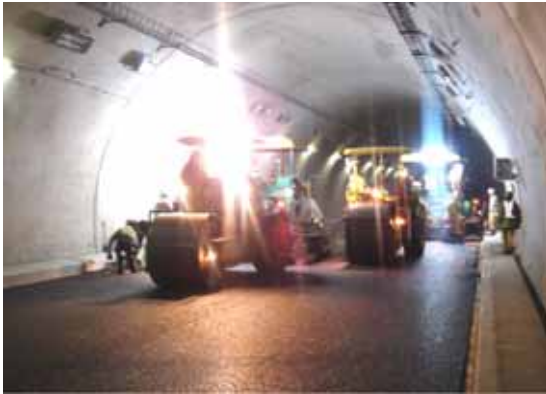
写真-3 初期転圧状況
