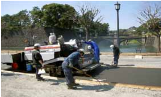
写真－8 敷きならし状況
