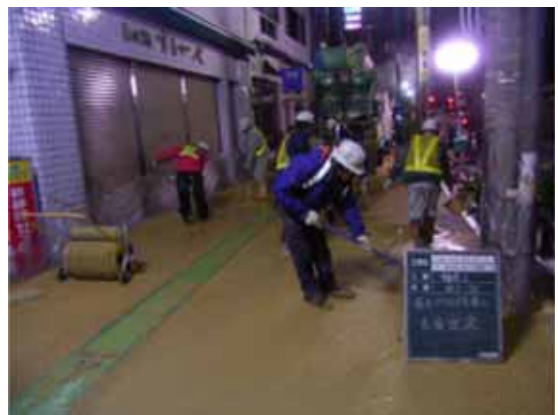
写真－3 保水材充填状況
