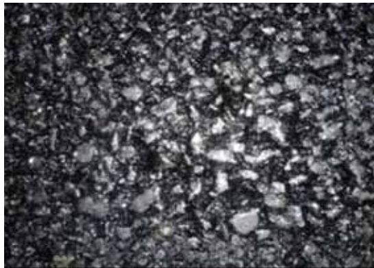
写真-4 表面仕上がり状況
