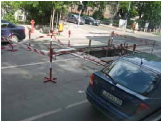
写真-17 簡素なバリケード
