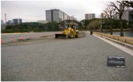
写真－3 既設玉砂利の鋤取り状況
