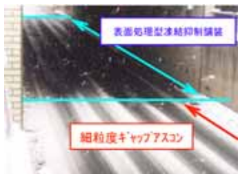
写真-1 供用後状況 (冬期)
