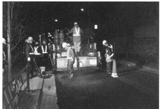
写真－1 表層施工状況
