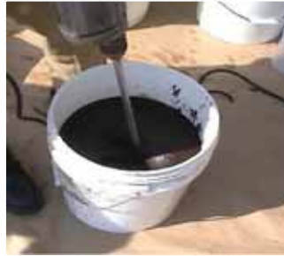
写真—5 混合状況
