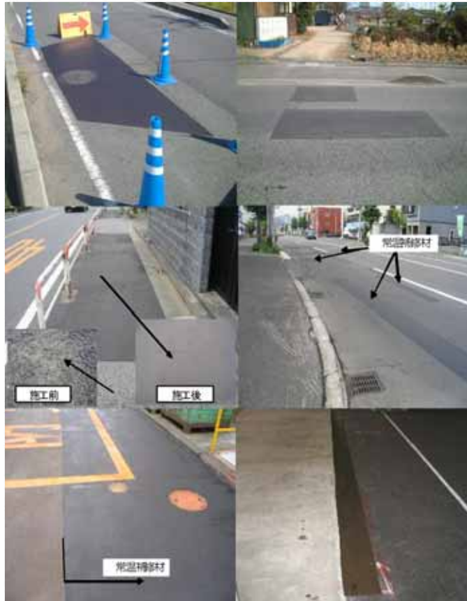
写真—7 各所施工状況
