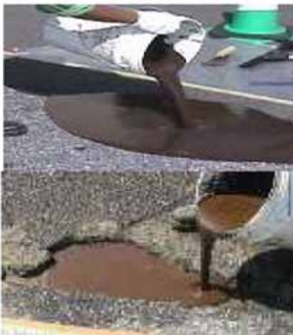
写真—2 混合物排出状況
