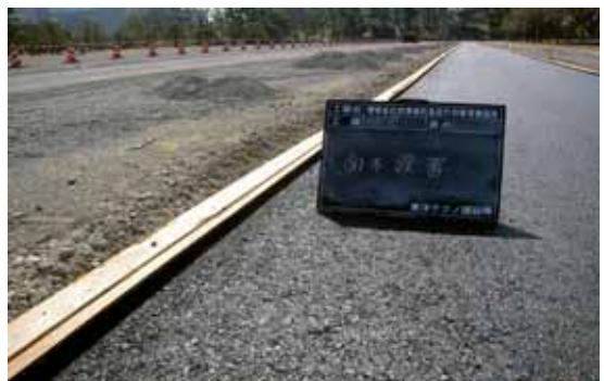
写真－11 舗装端面取りの型枠の設置状況
