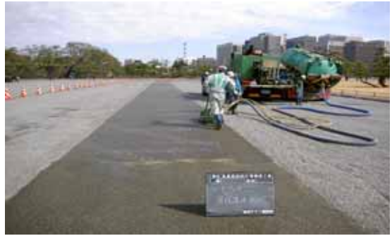
写真－10 ウォータージェットによる研掃の状況
