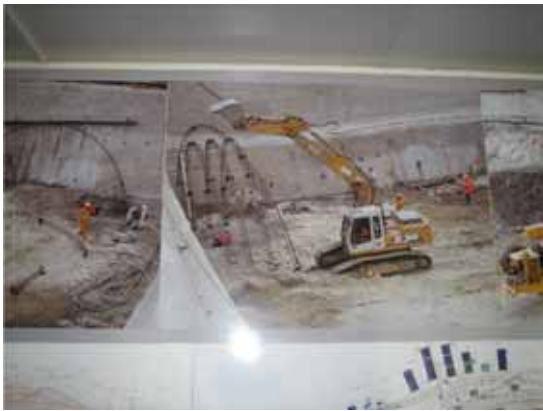
写真-18 支保工材をバックホウで釣って移動
