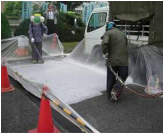
写真-3 遮熱性樹脂（下塗り） および硬質骨材の散布
