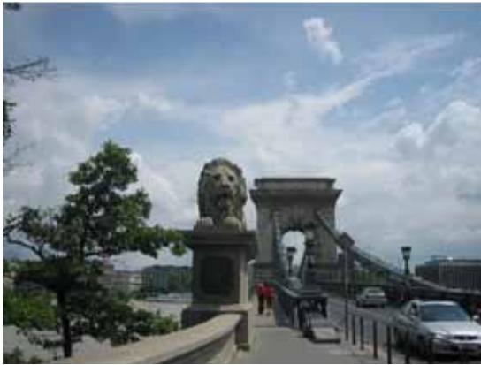
写真-15 セーチェニくさり橋
