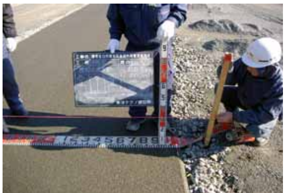
写真－12 舗装端面取りの仕上がり状況
