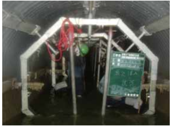
写真-4 裏込め注入状況
