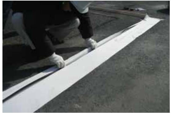
写真-2 導水シートの設置状況
