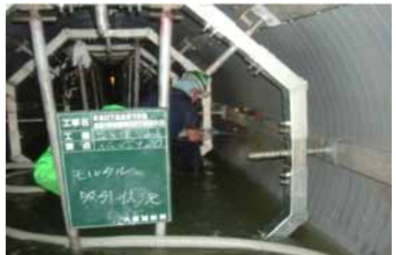
写真-5 モルタル吸引状況
