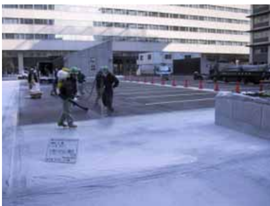
写真-1 下塗りと骨材散布の状況
