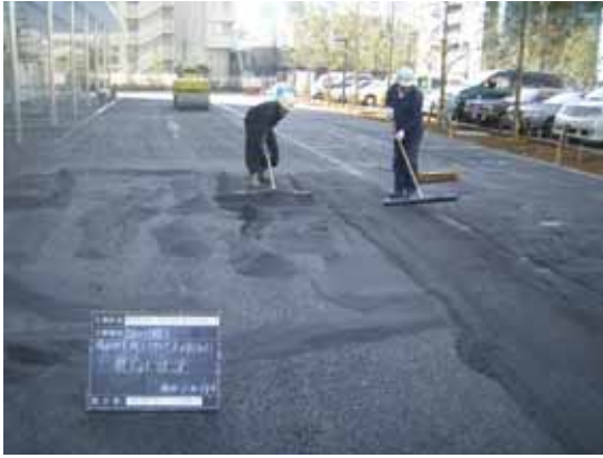
写真-4 揚水材充填状況
