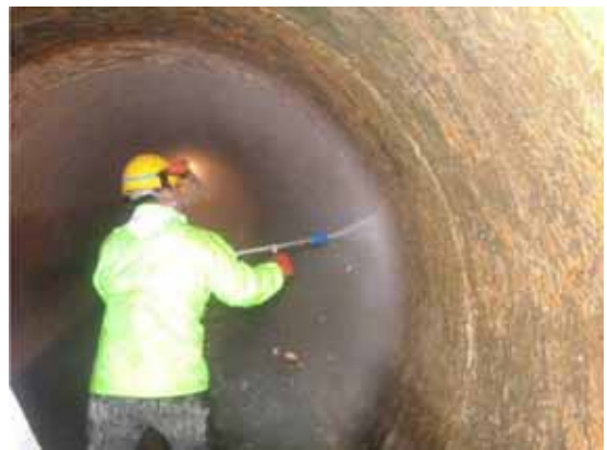
写真-2 既設管渠洗浄状況
