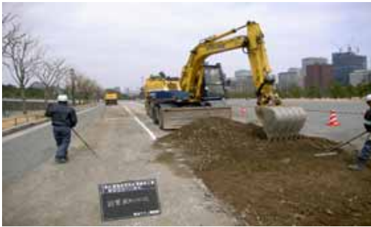
写真－4 床付け状況
