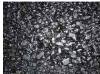
写真-3 仕上げ状況
