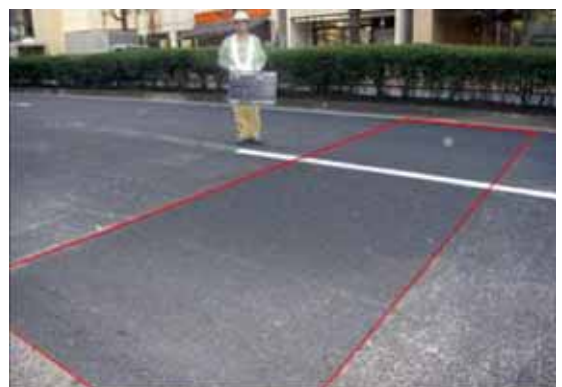
写真-4 Ⅲ工区
