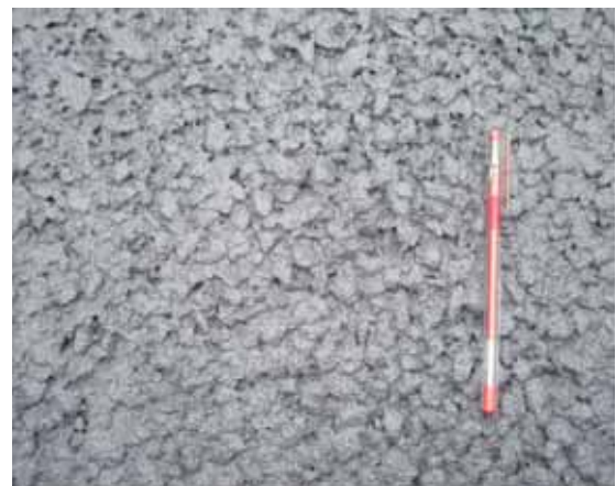
写真-6 路面状況
