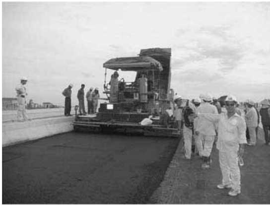
写真－8 敷きならし状況
