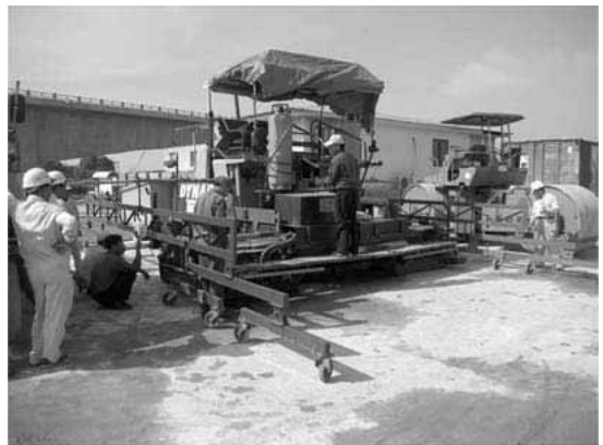
写真-7 アスファルトフィニッシャおよびスキ-
