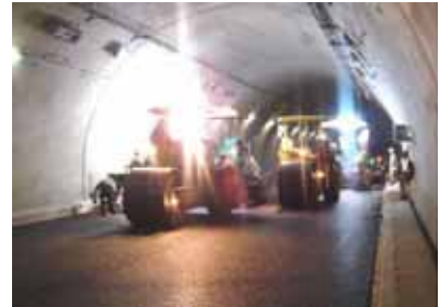
写真-2 舗設状況
