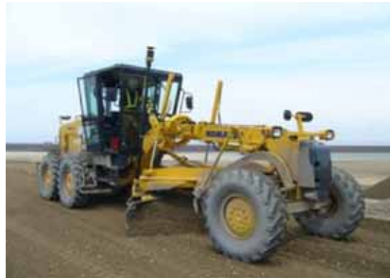
写真-1 mmGPS グレーダシステム施工状況
