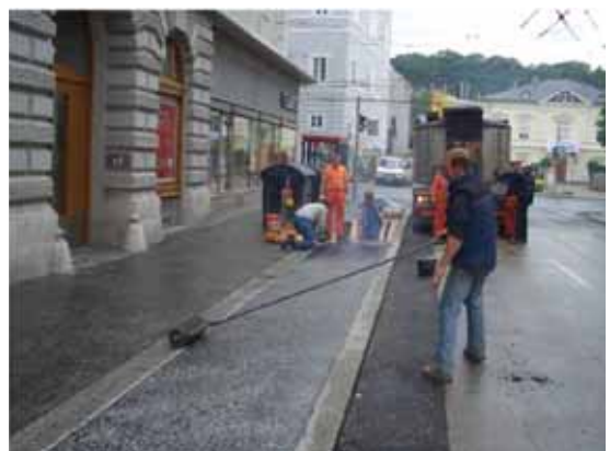
写真-14 ハンドローラーで仕上げ (全員 ヘルメット無し)
