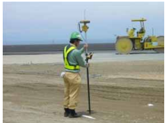
写真-2 検測キットによる出来形測定状況
