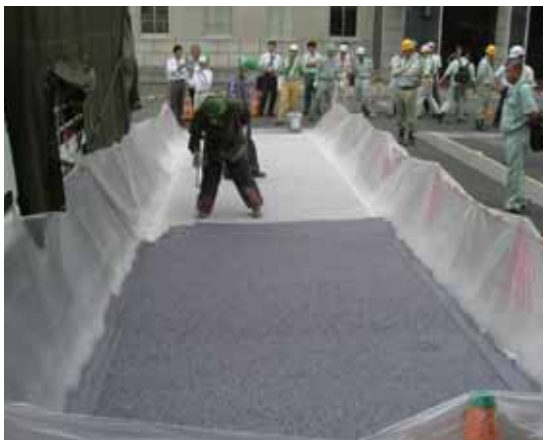
写真-4 遮熱性樹脂（上塗り）の散布
