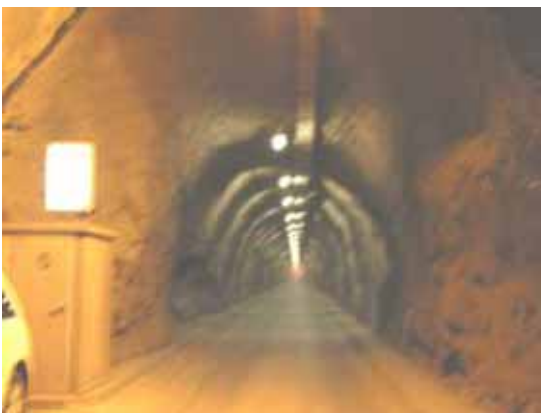
写真-3 モン・ラ・シェラ 有料トンネル内部
