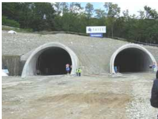
写真-7 トンネル坑口
