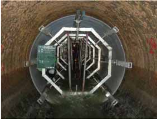
写真-3 支保工兼浮上防止工組立設置状況
