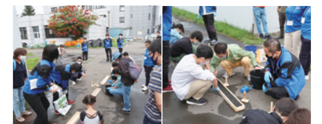
イベント参加者による「楽ファルト」の施工実験の様子
