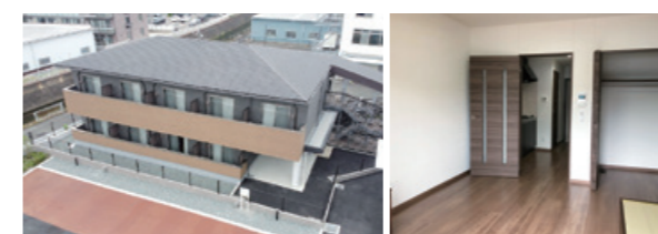
ワンルームマンションタイプの寮
