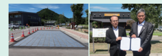
駐車場の路面に埋め込まれた太陽光発電パネル
