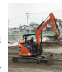
ICT搭載 小型バックホー
