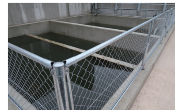
大分センターアスコン敷地内の沈砂池
