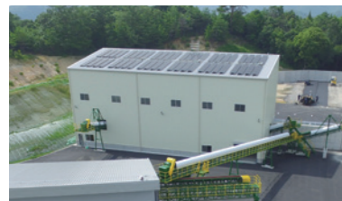
太陽光発電設備
