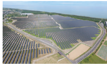
発電所建設に合わせて整備した周辺道路
