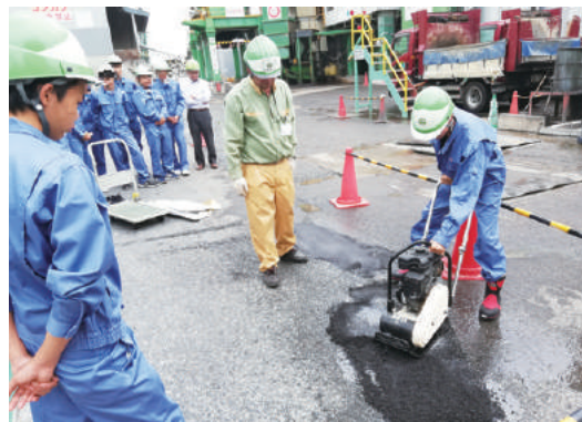
「楽ファルト」を使った施工体験
