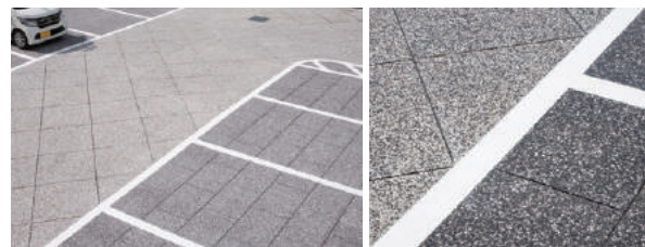
「涼畳」で舗装した路面
