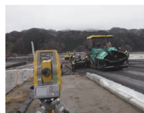
施工日数短縮によりCO 2 排出量削減へつながるICT舗装
