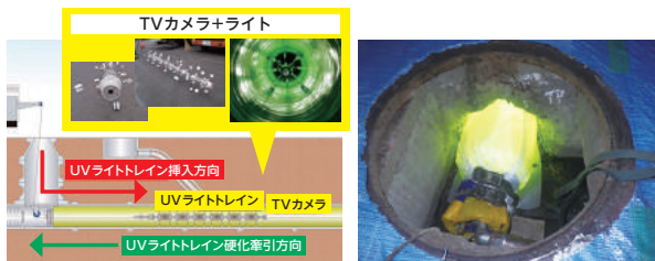
掘り起こしせず地中の配管を改修可能 UVライト照射状況
