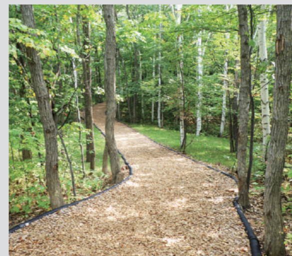
札幌国際大学クロスカントリーコース工事(2018年7月竣工)
