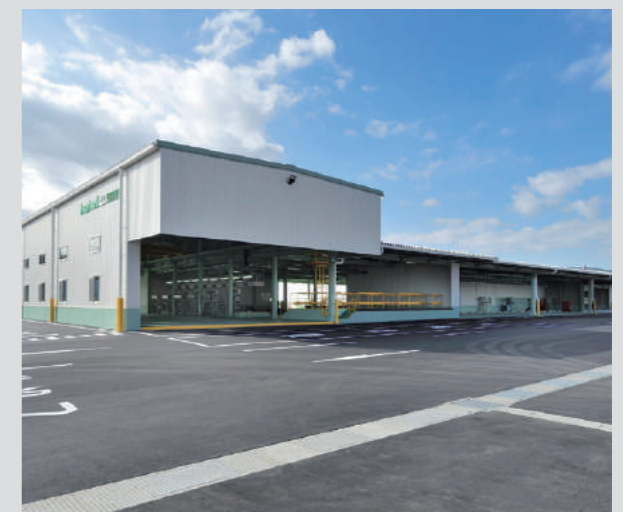
岩谷瓦斯株式会社 東京ヘリウムセンター土木建築工事(2018年11月竣工)
