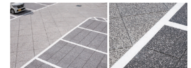
「涼畳」で舗装した路面
