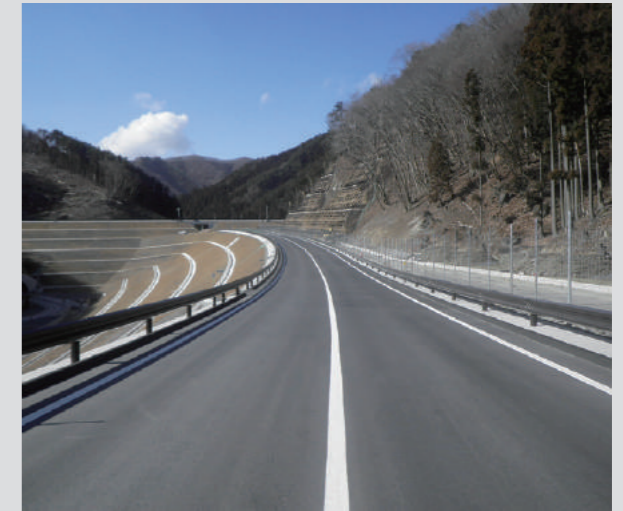
国道45号 大曾根地区舗装工事(2019年3月竣工)
