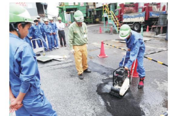
「楽ファルト」を使った施工体験
