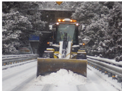
降雪時の除雪作業（「平成30-31年度 佐川維持工事」）
