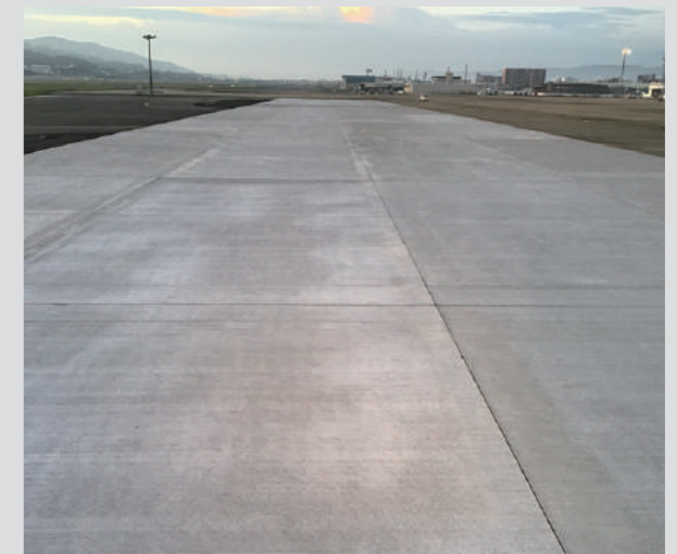
平成30年度福岡空港滑走路増設国際線エプロン新設外工事(第2次) (2019年8月竣工)
