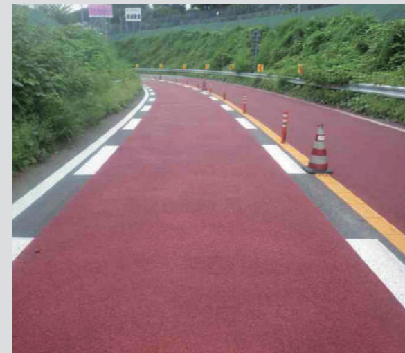
中央自動車道八王子管内舗装補修工事(2019年3月竣工)
