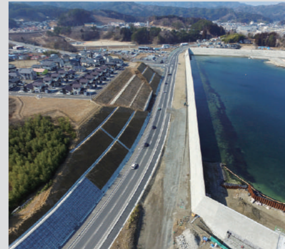
織笠地区改良舗装工事(2019年3月竣工)
