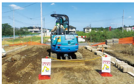
作業現場の安全管理
