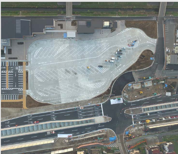
道路休憩施設舗装他工事(千葉県)
