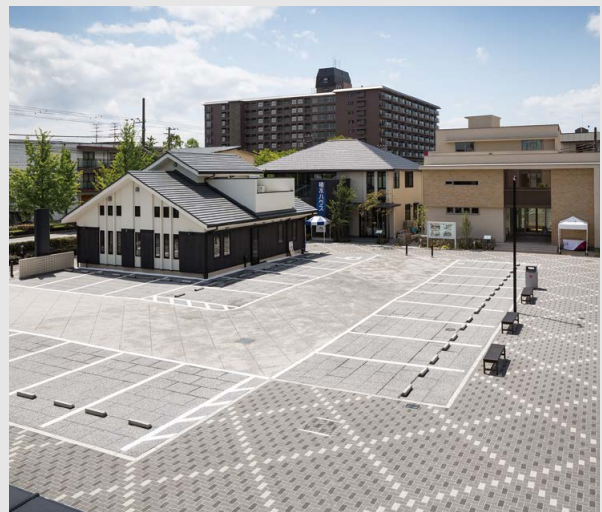
ABCハウジング西宮・酒蔵通り住宅公園 開設工事(兵庫県) 2018年5月竣工
