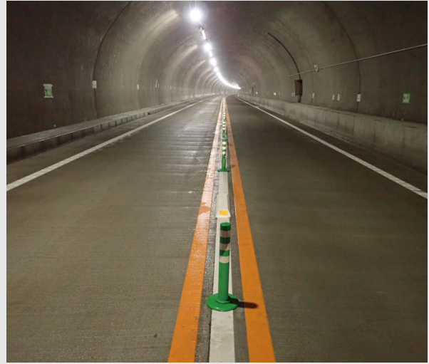
平成29年度佐久間第1トンネル舗装東栄地区工事(愛知県) 2018年8月竣工
