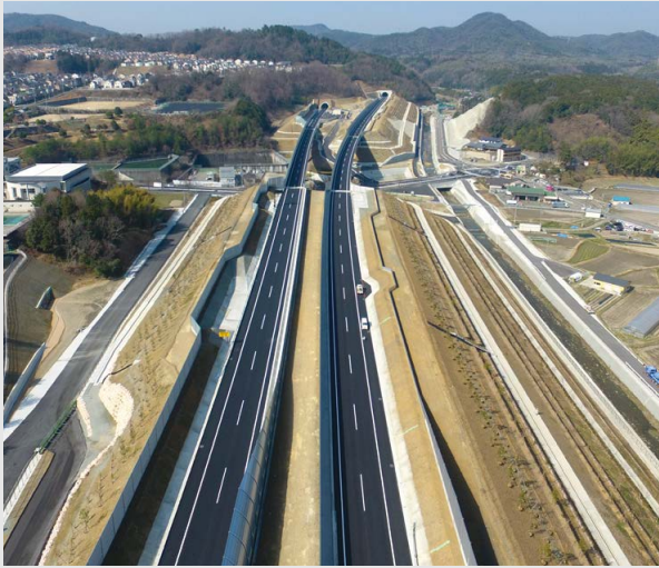
新名神高速道路 川西舗装工事(兵庫県)
