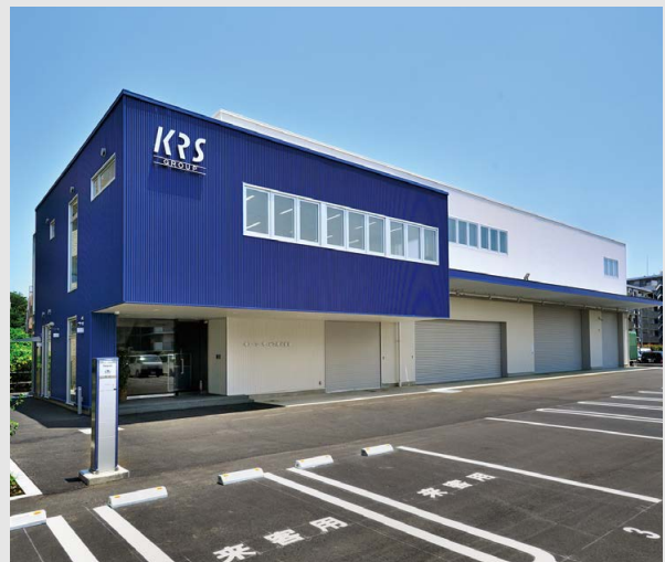
キューソーサービス東京営業所新築工事(東京都)
