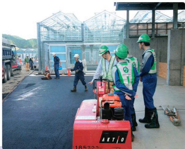
静岡営業所管轄工事にて
