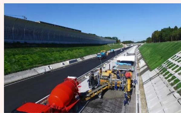
【新名神本線部】連続鉄筋コンクリート舗装施工状況
