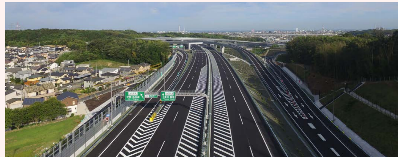
【新名神本線部四日市 JCT】完成写真全景
