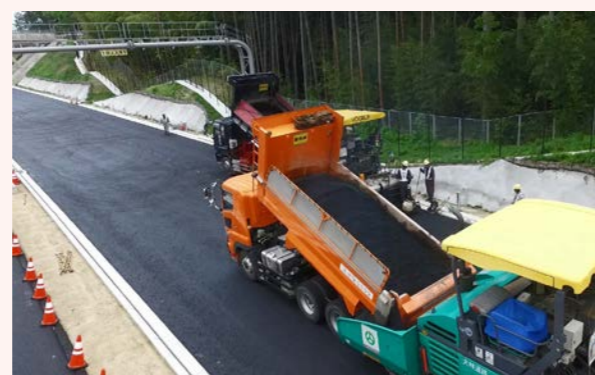
【東海環状線】アスファルト舗装施工状況
