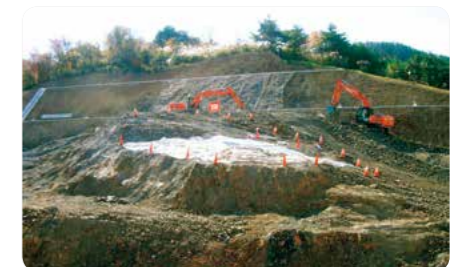
担当現場での発破作業
