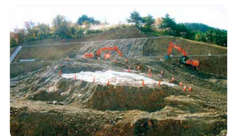
担当現場での発破作業
