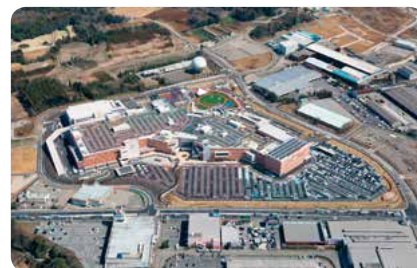
セブンパーク アリオ柏 外構工事
