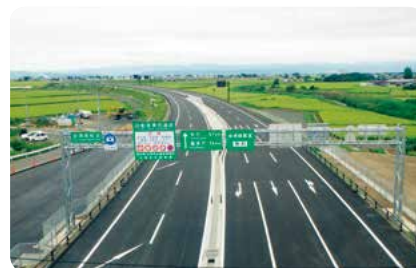
会津若松道路舗装工事
