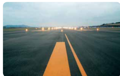
函館空港滑走路(30側)改良工事
