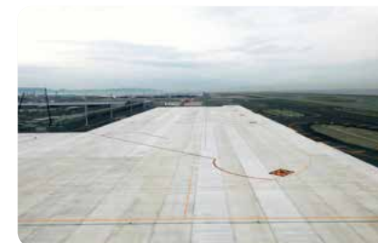
関西国際空港2期新ターミナル(T3)地区エプロン舗装等工事
