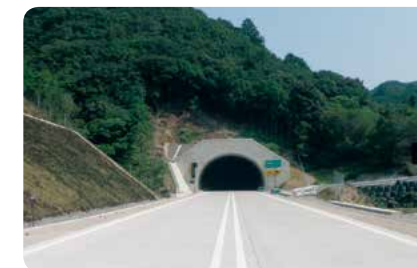
那智勝浦道路市屋第一トンネルコンクリート舗装工事
