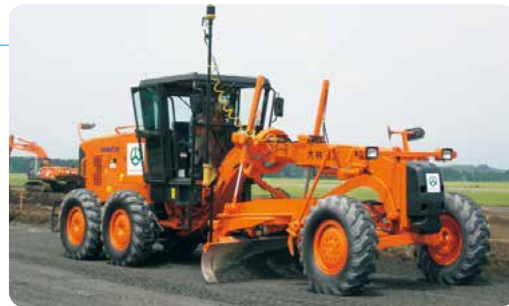
GNSSによる施工事例
