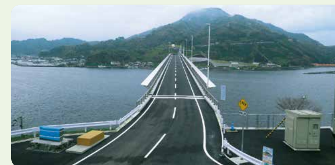
九島大橋全景
