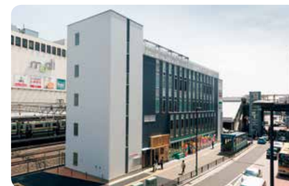
戸塚駅西口駅ビル新築工事
