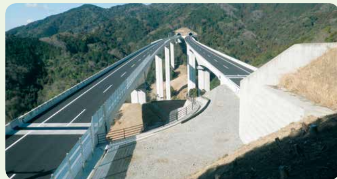
区間最長の日子橋全景
