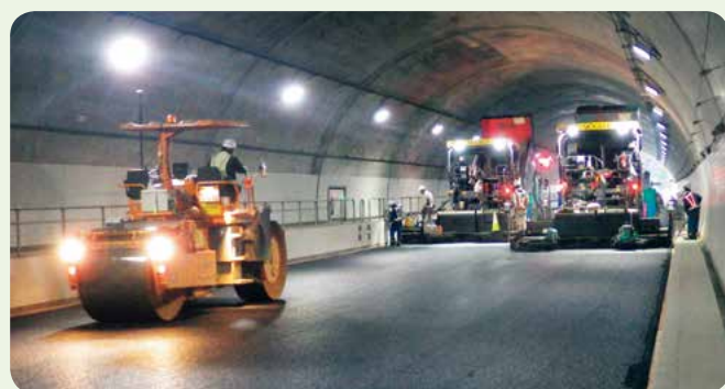
トンネル部の表層舗設状況
