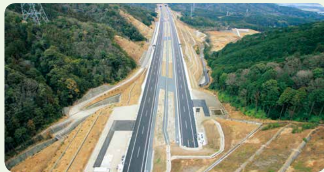
豊川市上長山地区 土工区間 (完成)
