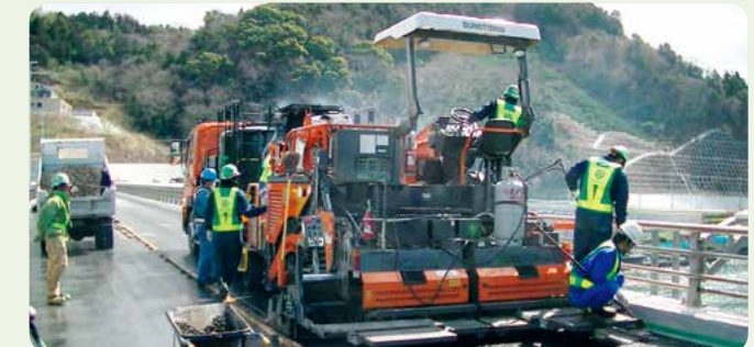
eグース施工状況
