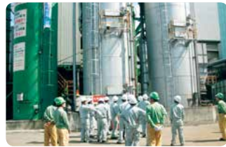
アスファルトプラント
