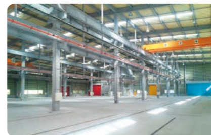
林鉄工所新工場新築工事
