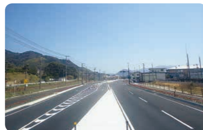
柳井バイパス柳井地区電線共同構
