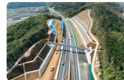
稲生地区外舗装工事
