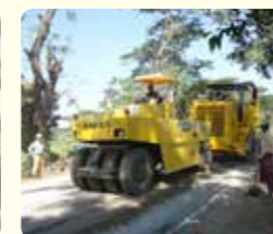
路上再生路盤工法 施工状況
