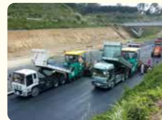
松倉沢橋～STA97+60 加熱アスファルト安定処理路盤工 8月下旬
