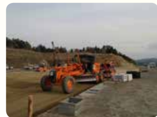
楢葉PA 上り線 路盤準備工 4月下旬
