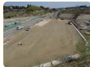
楢葉PA 上り線 路盤準備工 4月下旬
