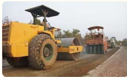
路盤施工状況
