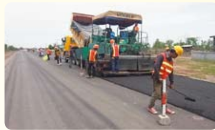
舗装施工状況
