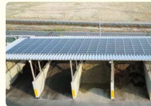
太陽光発電パネルの設置
