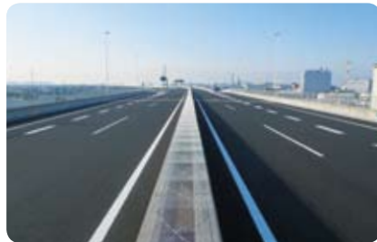
首都圏中央連絡自動車道 西久保 JCT ~ 寒川北 IC 間舗装工事
