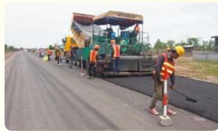
舗装施工状況
