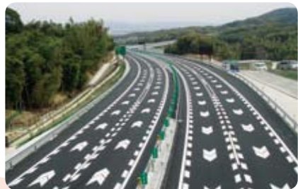
京都縦貫自動車道 京都舗装工事
