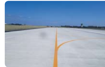
徳島 (23 震災関連) 駐機場等整備工事
