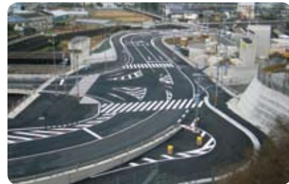
平成 24 年度 天神地区外舗装工事
