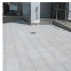
太陽光の近赤外線を反射して温度上昇を抑制する遮熱透水平板です。
