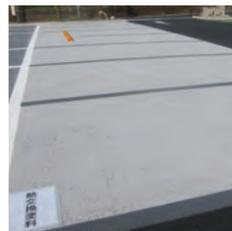
太陽光線のエネルギーを吸収しにくい特殊材料が入った塗料を塗布する工法です。
