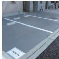
太陽光の近赤外線を高反射する遮熱塗料を塗布する工法です。
