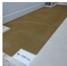
砂や真砂土と脱色アスファルトを用いた土系舗装です。
