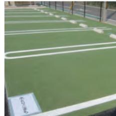
粒径10mm以下の小粒径骨材を使用した排水性舗装です。
