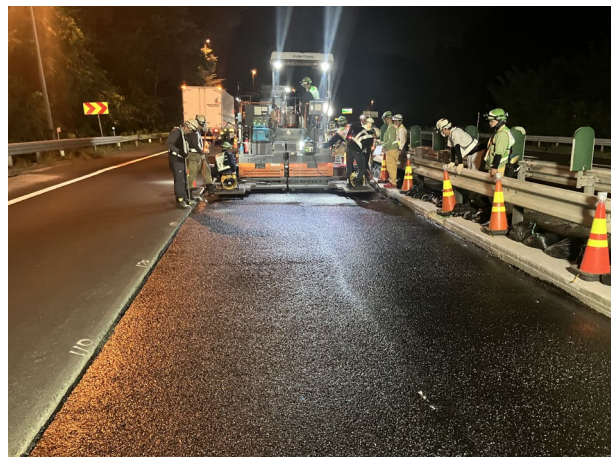
図1 eグース・スーパーの施工状況
