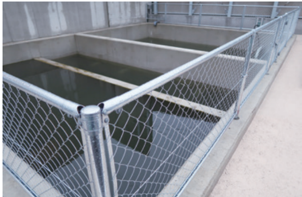
排水処理の仕組み(例：大分センターアスコン敷地内の沈砂池)
