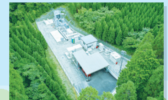
グリーン水素製造プラント（大林組）
