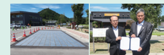
駐車場の路面に埋め込まれた太陽光発電パネル (左) 大熊町長 吉田 淳氏 (右) 大林道路(株) 代表取締役社長 黒川 修治
