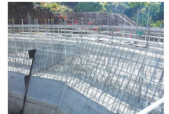
既存の鉄枠を使用することで廃材のほか、重機稼働などに伴うCO<sub>2</sub>排出量も削減
