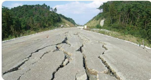
セメント安定処理路盤施工後に震災を受け、ひび割れた着工前の状況
