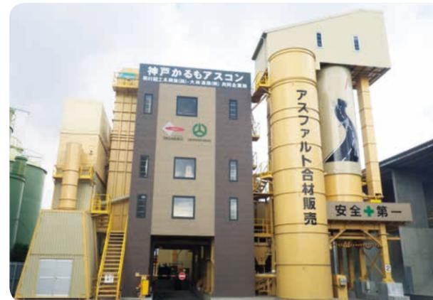
神戸市長田区に環境へ配慮した新アスファルト混合所を建設し、『神戸かるもアスコン』として奥村組土木興業株式会社との共同運営を開始しました。最新鋭の都市型プラントとして燃料に都市ガスを使用し、最新鋭の脱臭装置や騒音を減少させるための外装材など、周辺環境へ配慮した設備を導入しております。都市部に隣接した立地を活かし、お客様の多様なニーズに迅速に対応するとともに、高品質の製品を安定して供給することを目指します。
