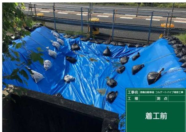
写真-2 陥没箇所の応急措置
