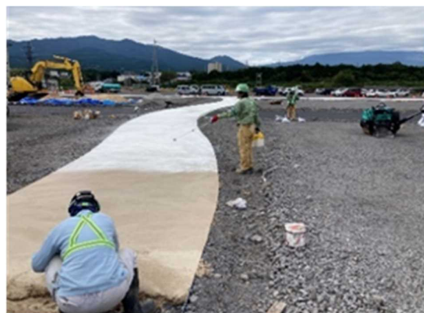
写真-3 養生剤材散布状況
