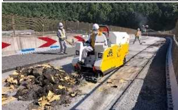
写真-1 既設防水撤去
