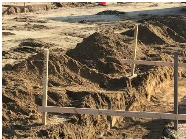
写真-2 丁張設置例
