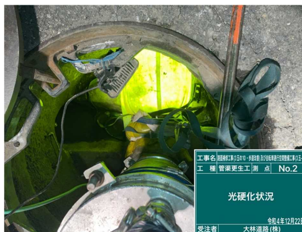
写真-7 光硬化状況
