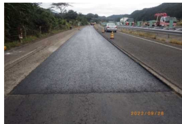
写真-7 本施工完了全景
