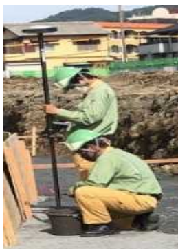
写真-1 GNSS測量機械使用状況
