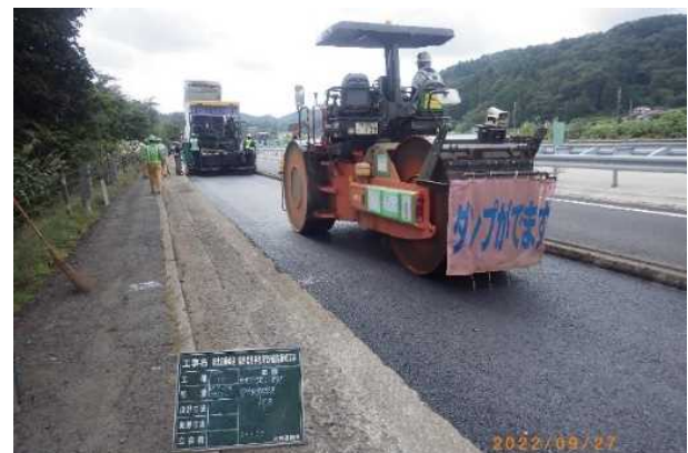
写真-6 本施工状況
