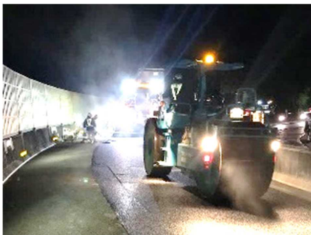
写真-3 表層工施工状況①
