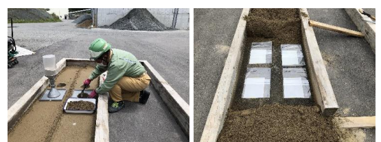
写真-1 現場密度試験
