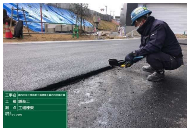
写真-5 施工継目サイドタック塗布状況
