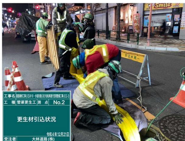
写真-5 更生材管内挿入
