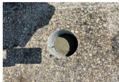
写真-6 D2 のひび割れ
