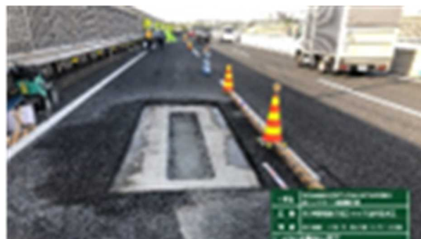
写真-7 発砲スチロール上面の超速硬モルタル
