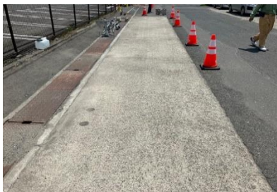
写真-5 D2 の路面状態
