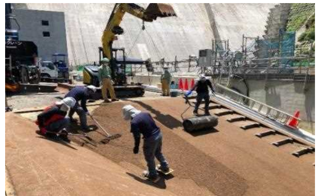
写真-5 ウインチ付きバックホウで吊り下げた転圧ローラによる締固め
