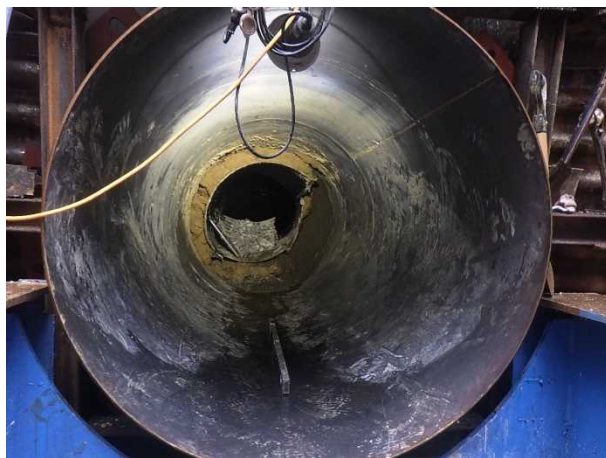
写真-7 既設コルゲートパイプ取込み
