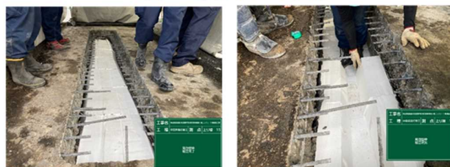
写真-6 発砲スチロール設置状況
