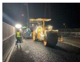
⑦表層施工状況
