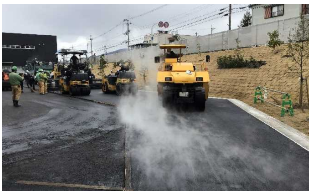
写真-7 舗設状況
