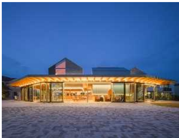
写真-5 建物全体図(センターハウス)
