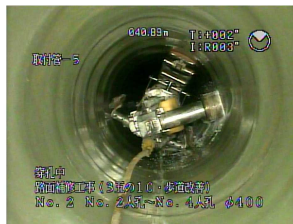
写真-8 ロボット削孔状況
