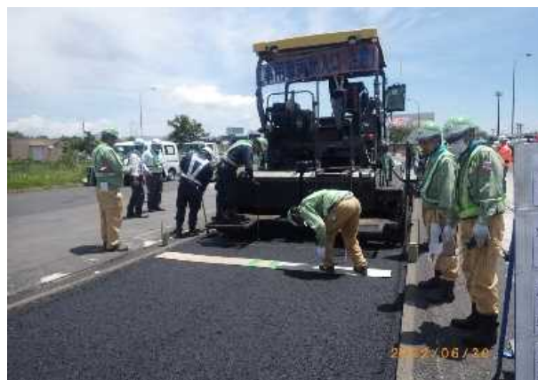
写真-5 試験舗装施工状況
