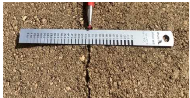
写真-6 ジョイント部の開きの発生状況(最大3mm)
