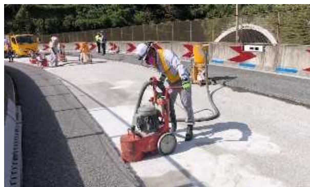
写真-2 床版研掃状況
