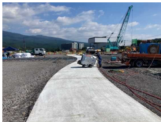
写真-4 目地切断状況
