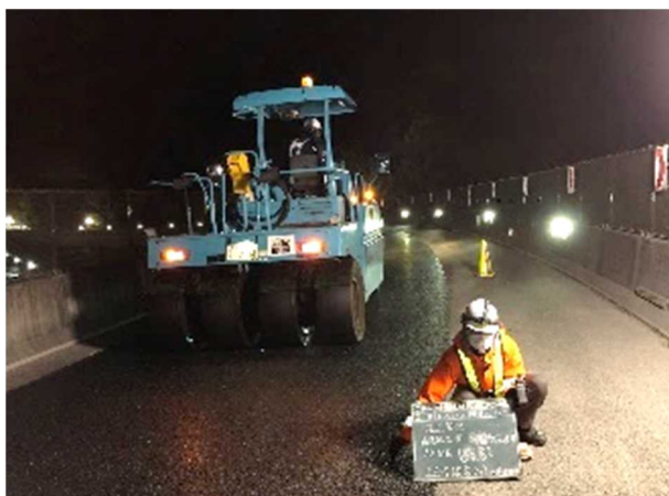
写真-4 表層工施工状況②
