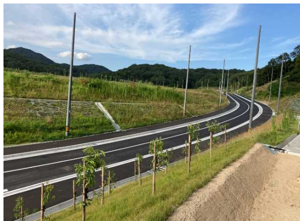
写真-10 完成写真
