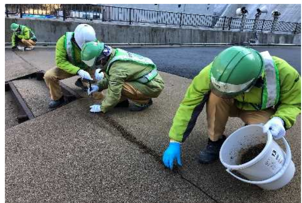
写真-7 ジョイント部の補修状況
