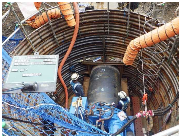
写真-5 鋼管据付完了
