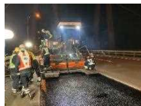
④グースアスファルト施工状況
