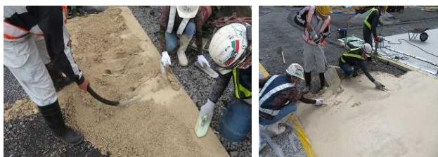
写真-2 敷きならし・締固め状況
