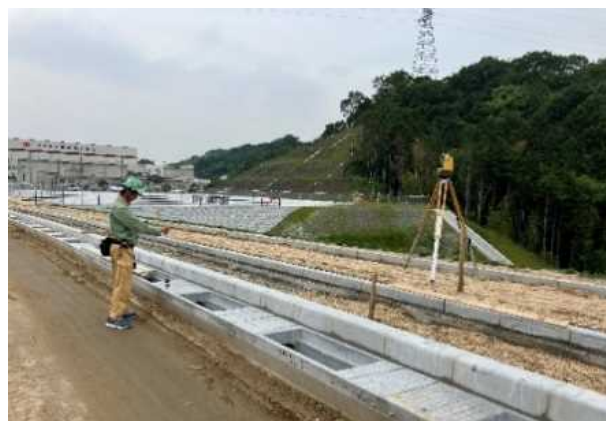
写真-7 構造物出来形確認状況
