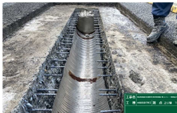
写真-5 鋼製ボイド管内部
