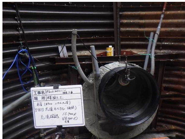
写真-9 モルタル充填
