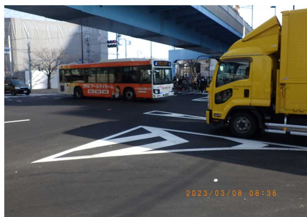
写真-12 タフアスコン施工箇所
