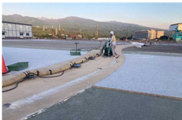
写真-5 ショットブラスト施工状況
