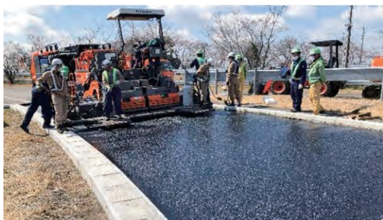
写真－1 試験施工状況
