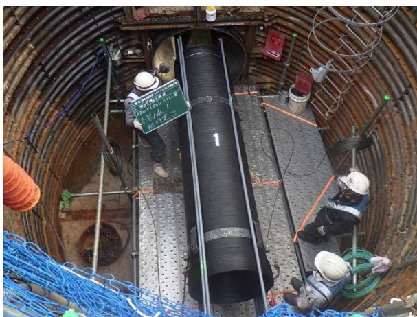
写真-8 ハウエル管挿入
