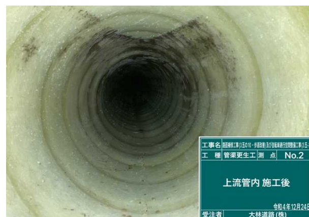
写真-11 本更生完成
