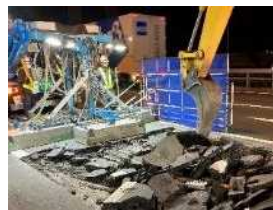
①IH施工状況
