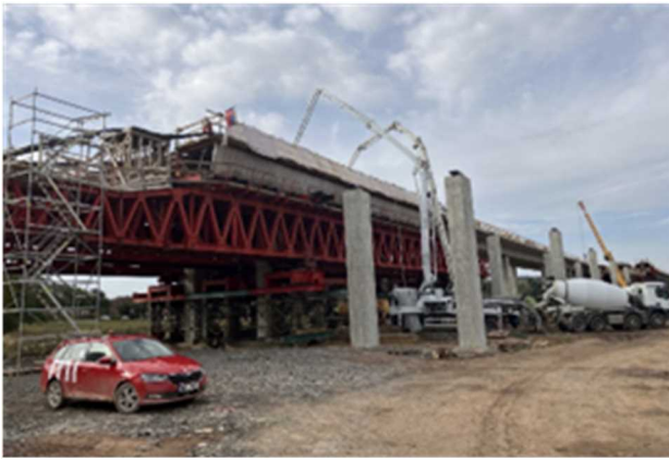
写真-10 建設中の高速道路の橋梁
