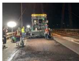
⑤仮舗装状況
