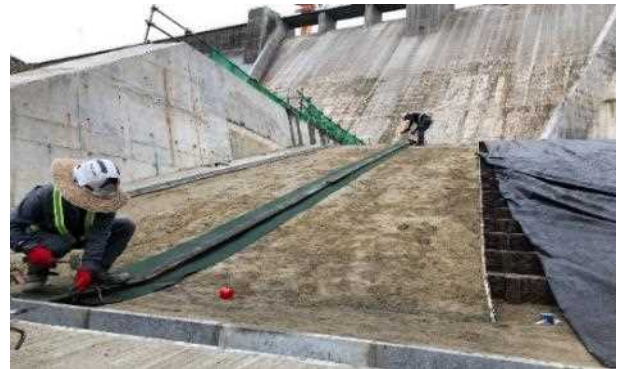
写真-4 施工ジョイント下部の防草シートの設置
