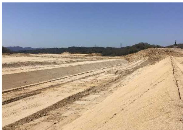
写真-1 土工事完了写真(当社施工前)
