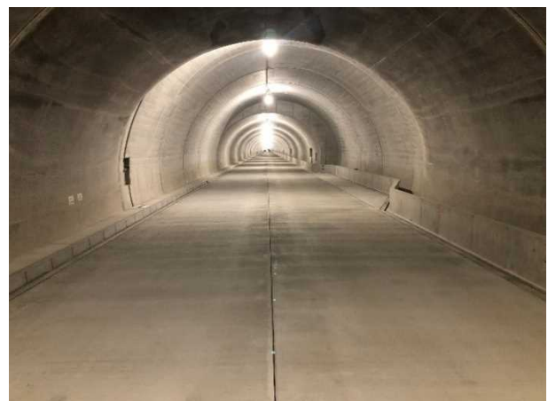
写真-4 完成写真
