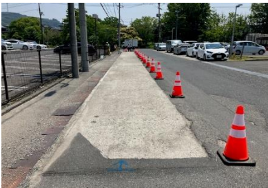
写真-2 D1 の路面状態
