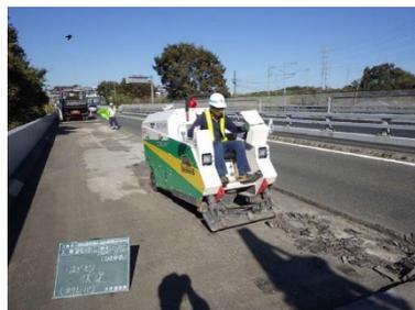
写真-2 残アスファルト除去状況
