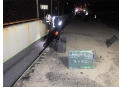
写真-11 端部表面保護材塗布状況 (グレートⅡ)
