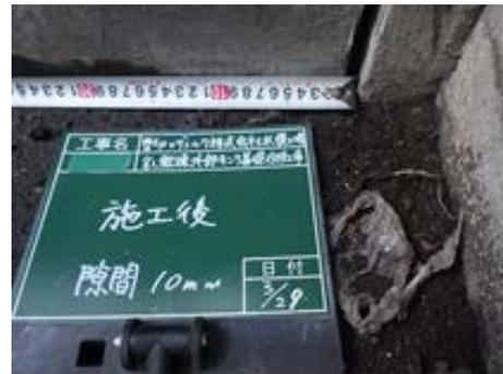
写真-11 基礎下端修正後
