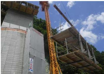
写真-2 クレーンによる吊り上げ状況
