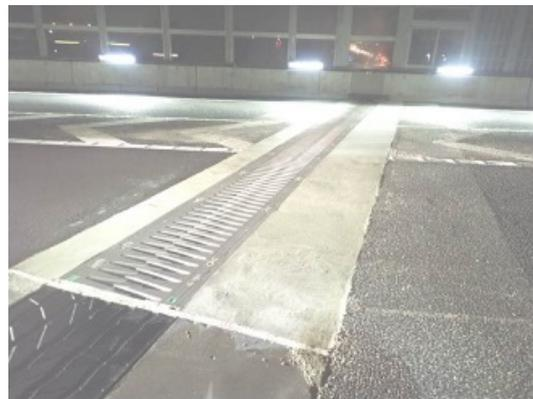
写真-11 2車線分の設置完了状況
