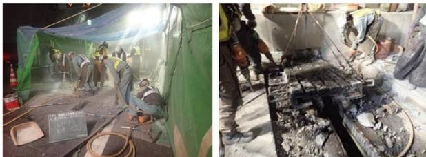
写真-3 既設伸縮装置撤去状況
