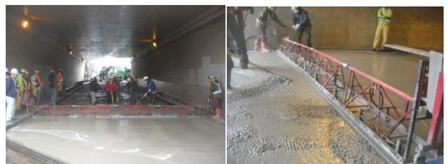
写真-3 敷きならし・締固め状況
