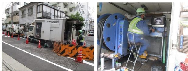
写真-3 シームレスシステム工法の施工状況
