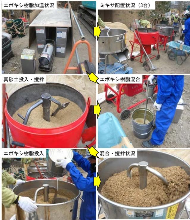
写真-2 混合物製造状況
