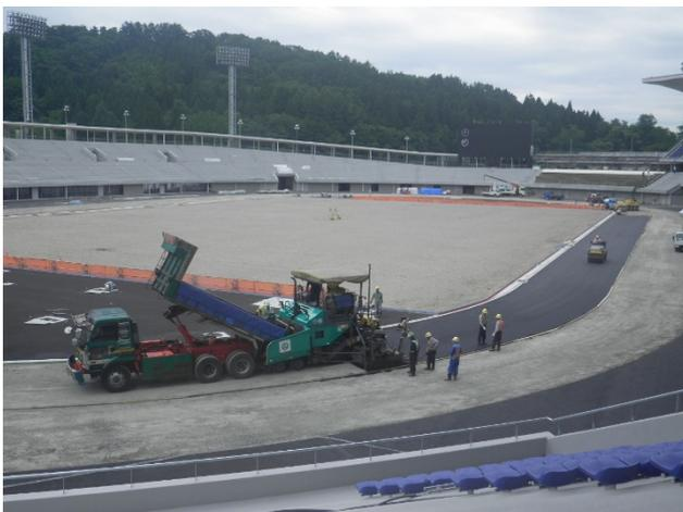
写真-2 トラック走路基層施工状況
