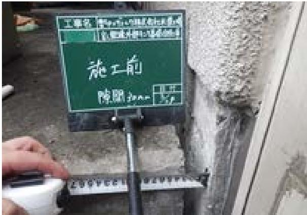
写真-1 基礎上端の隙間
