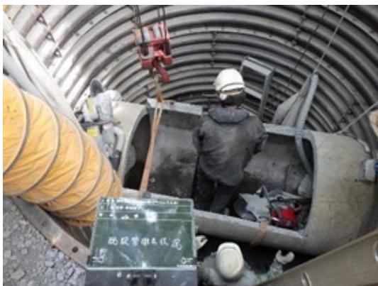
写真-1 本管切断状況
