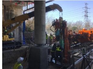
写真-3 鋼管建込み状況
