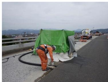
写真-4 上面 WJ 研り状況(床版断面修復工)
