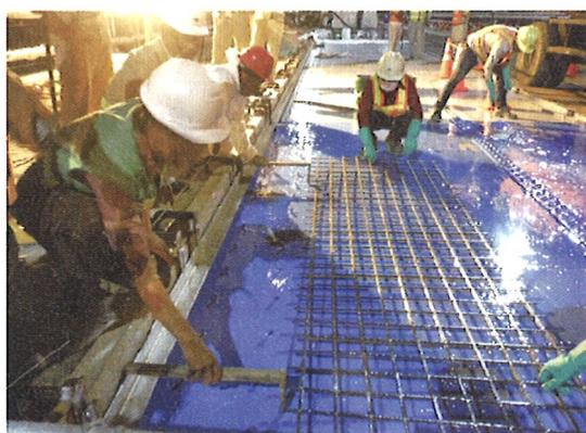
写真-5 CFRP 格子筋設置状況
