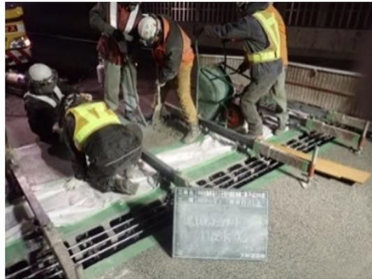
写真-10 超速硬コンクリート打設状況
