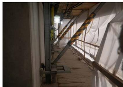
写真-7 コンクリート養生時のシート
