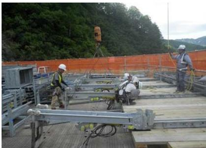
写真-1 仮設ヤードでの型枠・足場組立状況
