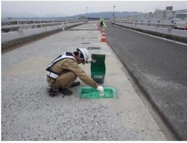
写真-5 プライマー状況 (床版断面修復工)
