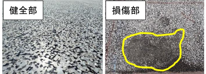
写真-1 研磨路面（左：健全部、右：損傷部）
