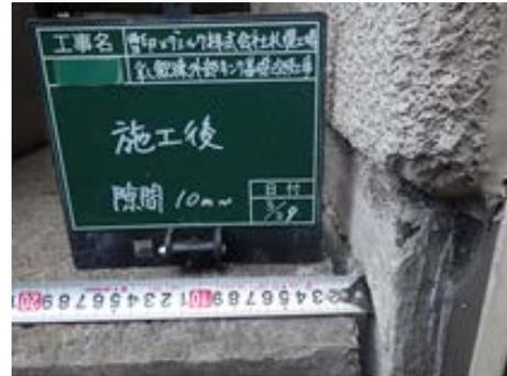
写真-10 基礎上端修正後
