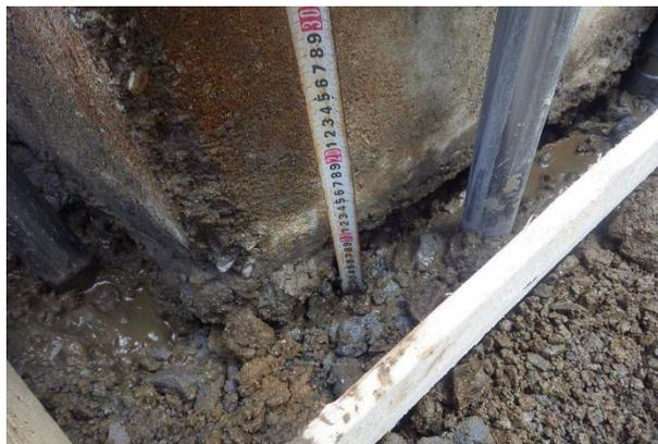
写真-9 タンク基礎沈下修正後
