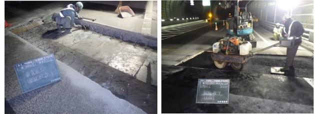
写真-4 落下防止鋼板および仮舗装状況
