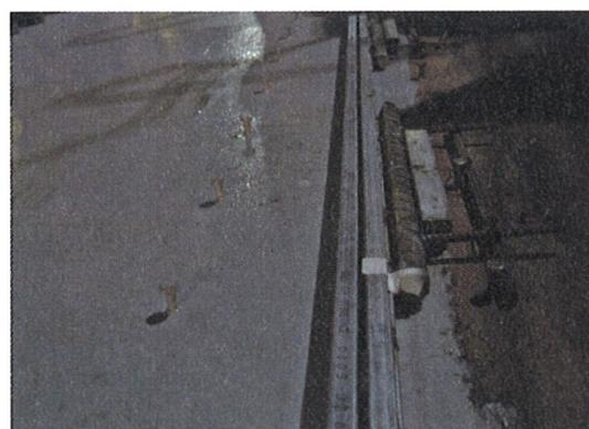
写真-3 鋼製型枠設置状況
