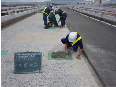
写真-6 ジェット Co 打設状況 (床版断面修復工)
