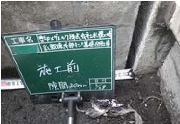
写真-2 基礎下端の隙間
