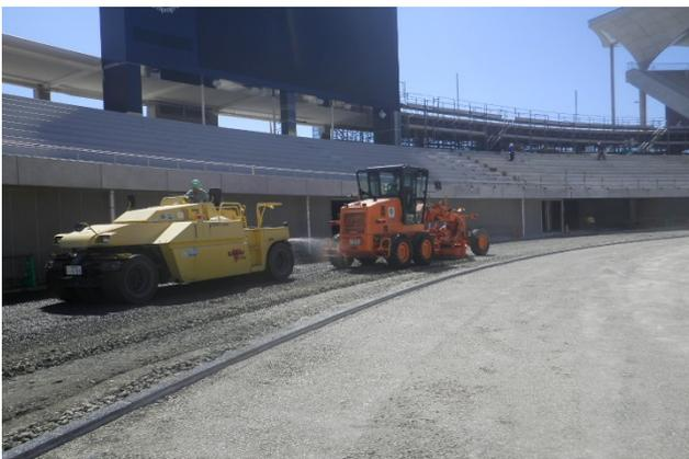
写真-1 アウトフィールド路盤施工状況
