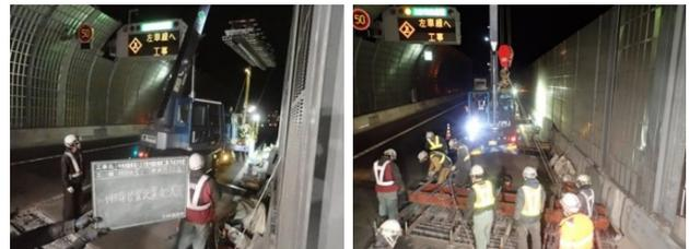
写真-6 伸縮装置設置状況
