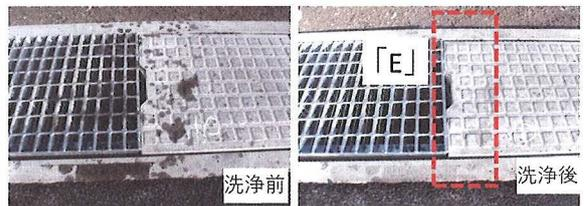
写真-13 コンクリートのアスファルト乳剤・油汚れ
