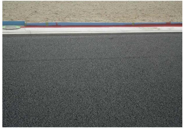
写真-4 施工時に発生した筋状の跡
