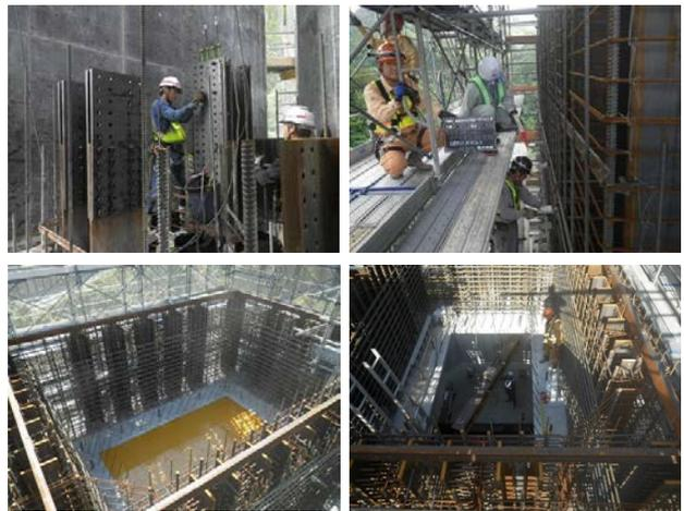
写真-3 H鋼・鉄筋設置状況
