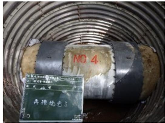
写真-2 Y ジョイント再接続完了状況
