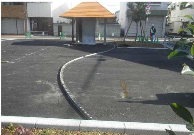
写真-1 ステンレス製曲線見切材
