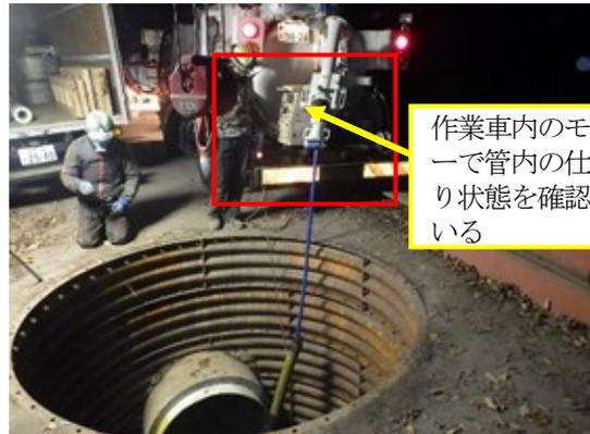
写真-10 TVカメラによる管内仕上りの確認状況
