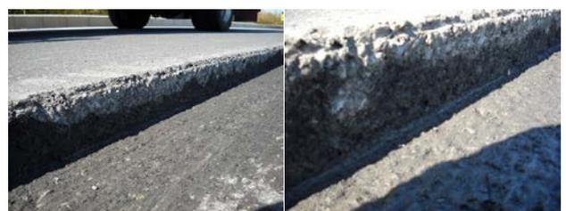
写真-10 基層・中間層の側面の状態
