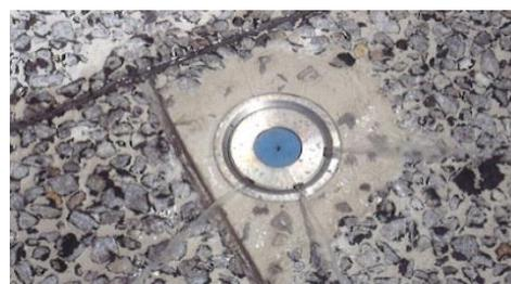
写真-3 路面散水装置（拡大）
