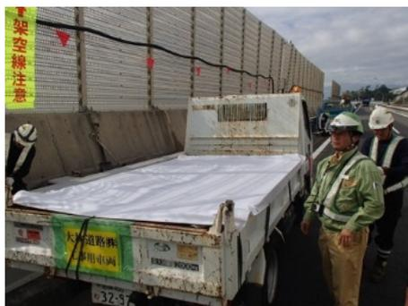
写真-4 荷台からの飛散防止対策
