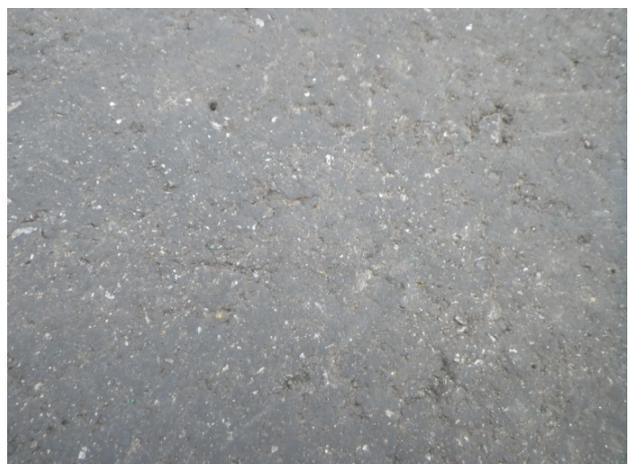
写真-1 オークマスチック Crawler の仕上り面
