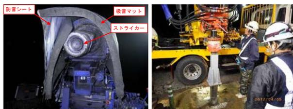
写真-8 防音シート・吸音マット設置状況(左)とサイレントストライカーの使用(鋼管打込み)(右)
