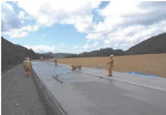
写真-5 人力フロート施工状況
