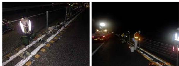
写真-5 端末金具取付け(左)とワイヤーロープ設置(右)
