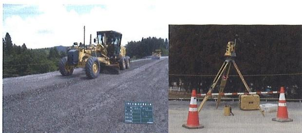
写真-6 TSマシンコントロールシステムによる整正状況
