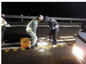
写真-2 中間支柱基礎ブロック設置状況
