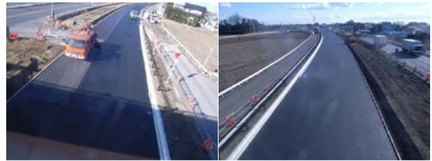
写真-14 タックコート散布状況
