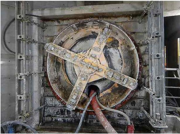
写真-11 推進機到達状況
