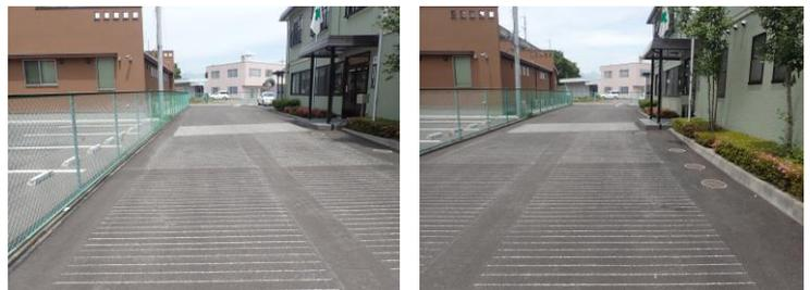
写真-4 同じ上幅 左:階段状 右:面取り
