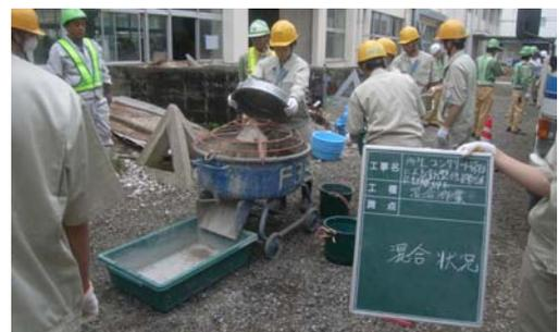
写真-2 再生コンの製造状況
