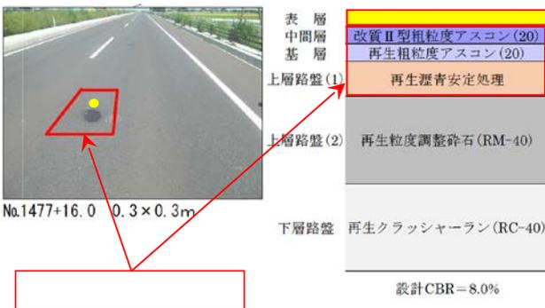
図-9 損傷部のコア採取位置
