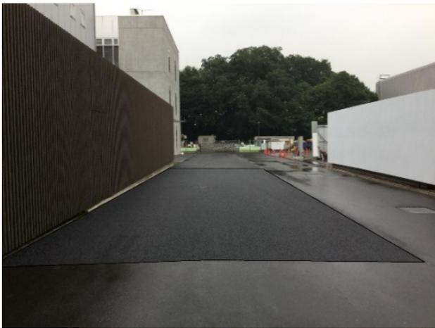
写真-2 研磨前の母体舗装(黒枠内)
