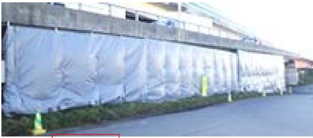
写真-5 枠組足場と防音シートによる防音壁
