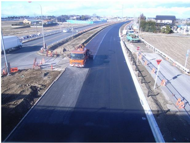
写真-1 表層施工前のタックコート散布状況
