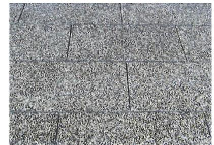
写真-5 石貼り風保水性舗装外観
