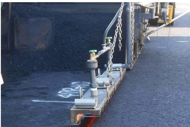
写真-5 L型ジョイントヒータ
