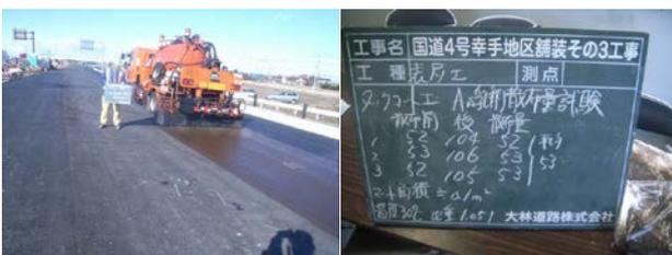
写真-13 乳剤散布量の確認状況
