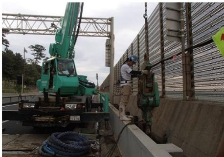
写真-1 バイブロハンマーによるH型鋼打設状況
