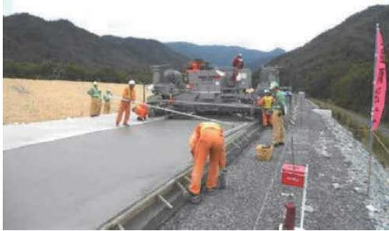
写真-4 コンクリート打設状況
