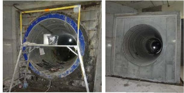
写真-13 推進機解体完了(左)と坑口仕上げ完了(右)
