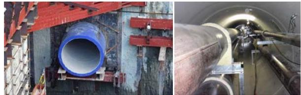
写真-14 新病院側出口(左)と熱供給管設置状況(右)
