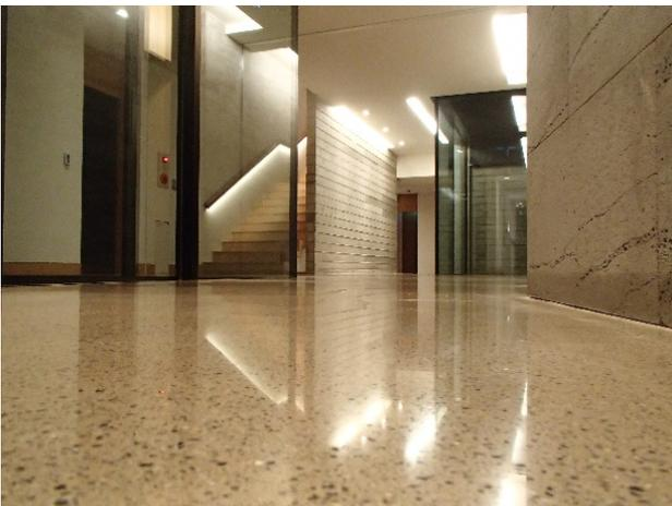
写真-1 コンクリート床の鏡面仕上げ例
