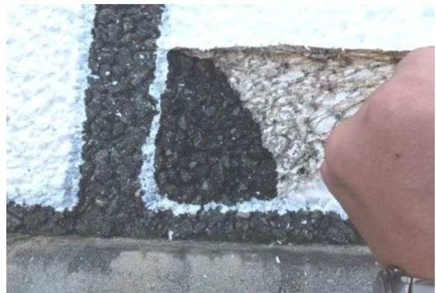
写真-10 5層施工部の撤去状況
