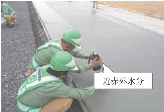
写真-6 近赤外水分計測定状況
