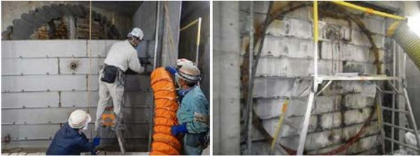
写真-5 開口部 鋼板設置状況
