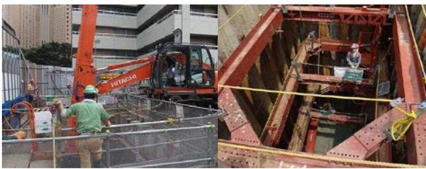
写真-2 発進立坑掘削状況(左)と山留設置(右)
