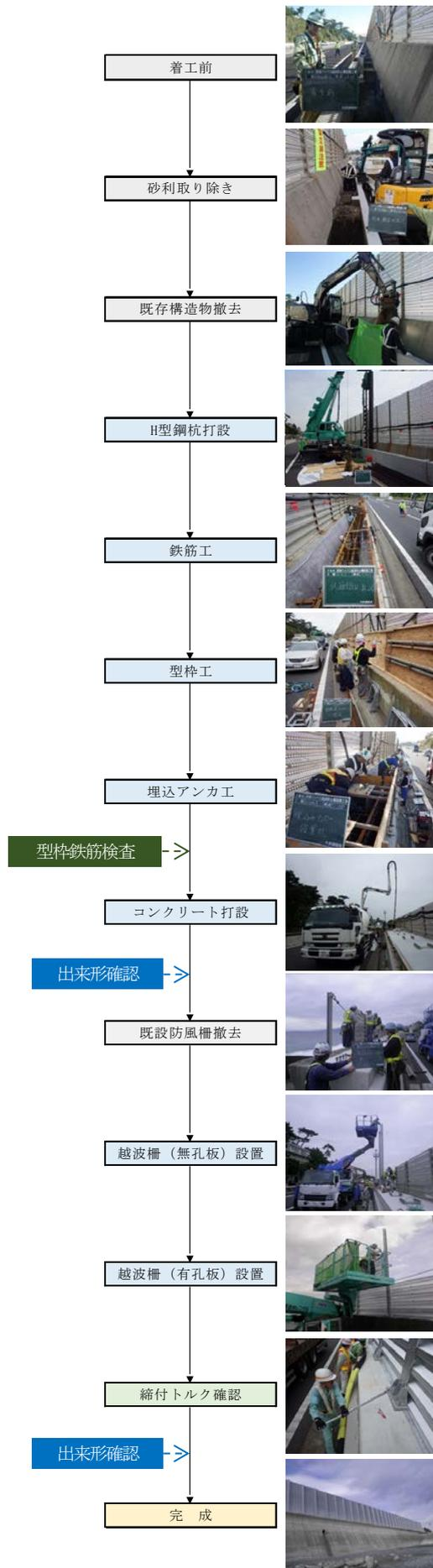
図-4 0.9KPの越波防止柵工の施工の流れおよび状況
