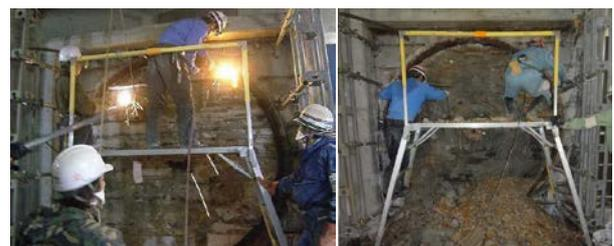
写真-10 鏡切断(左)と面盤掘削状況(右)
