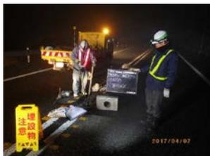
写真-11 人力掘削作業・埋設物注意看板設置
