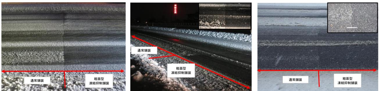
写真 1 凍結抑制舗装（粗面型）の効果を確認した状況例（左から供用 1 冬目、2 冬目、4 冬目）
