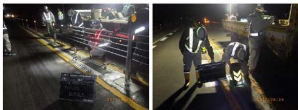
写真-6 中間ターンバックル設置状況(左)と安全ブロック設置状況(右)
