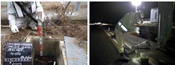
写真-10 埋設管路調査(右)と探針棒による確認(左)
