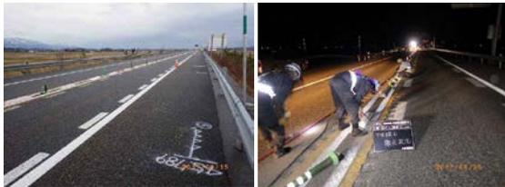
写真-1 施工位置マーキング(左)と中分縁石・車線分離標撤去状況(右)
