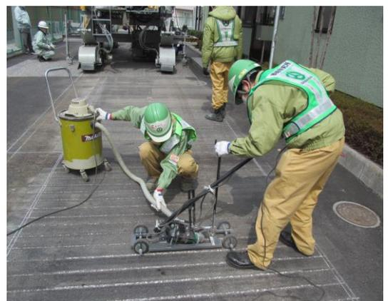
写真-2 削溝用面取マシン
