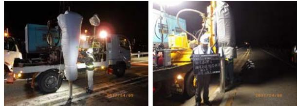
写真-4 スリーブ打設状況(左)と鋼管杭打設状況(右)
