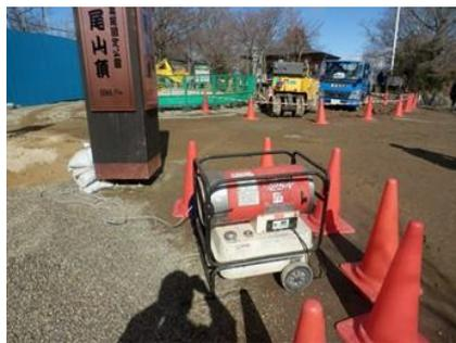
写真-2 骨材の加熱
