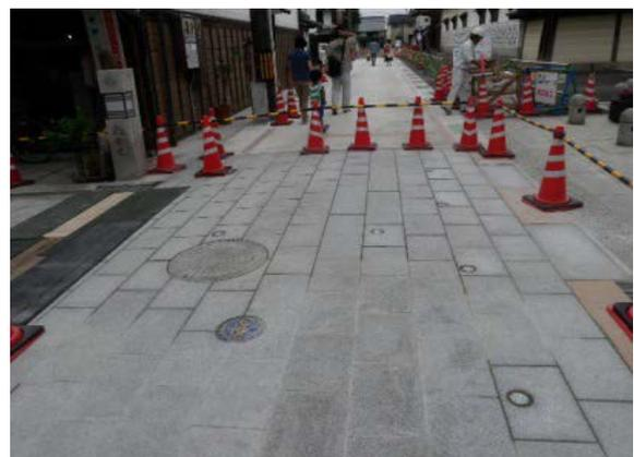
写真-9 目地モルタル注入完了
