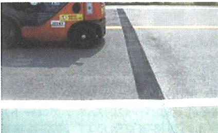
写真-9 埋設管復旧箇所に生じた段差補修例
