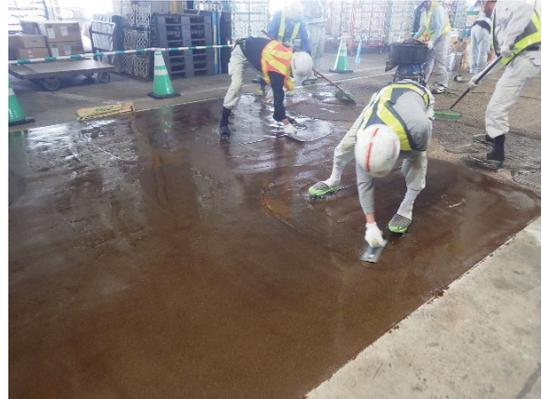
写真-9 樹脂モルタル施工状況
