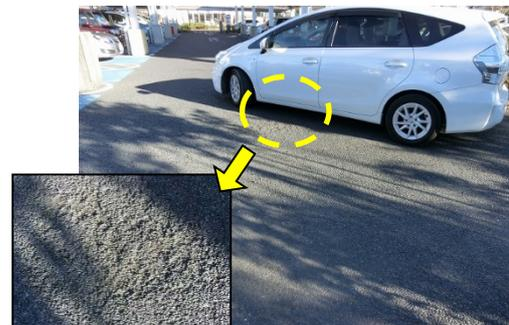
写真-1 コーナー部における骨材飛散例
