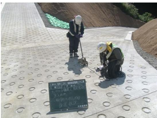
写真-11 耐熱バックアップ材設置状況
