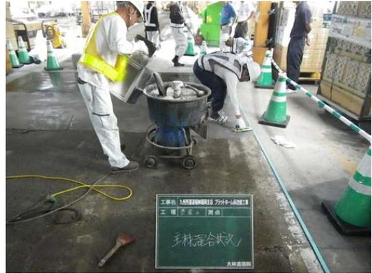
写真-8 樹脂モルタル攪拌状況
