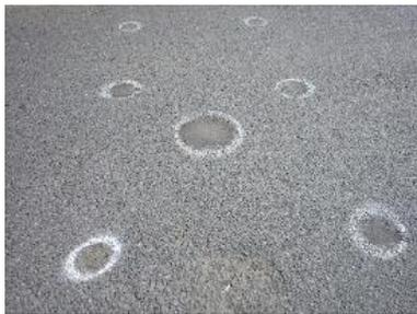
写真-6 ポットホール補修状況(補修1ヵ月後)
