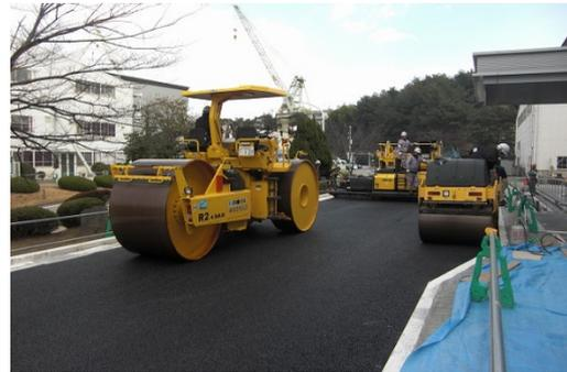
写真-4 母体混合物舗設・転圧状況
