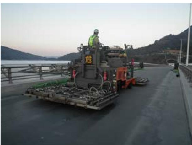
写真-2 ロードヒータ使用状況
