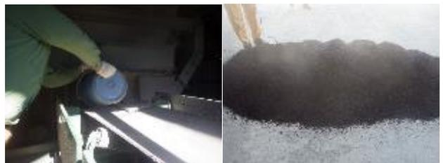
写真-5 バインダ投入・練り落とし状況
