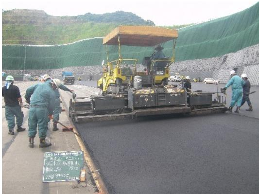
写真-6 保護層施工状況
