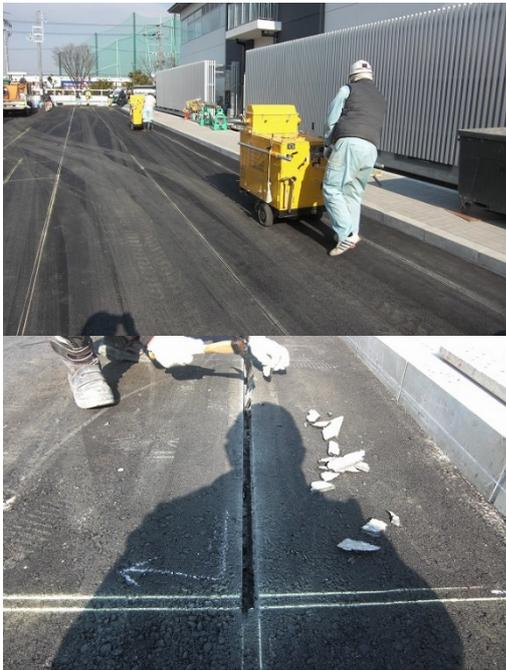
写真-2 乾式ロードカッター2台切りと溝内はつり清掃状況
