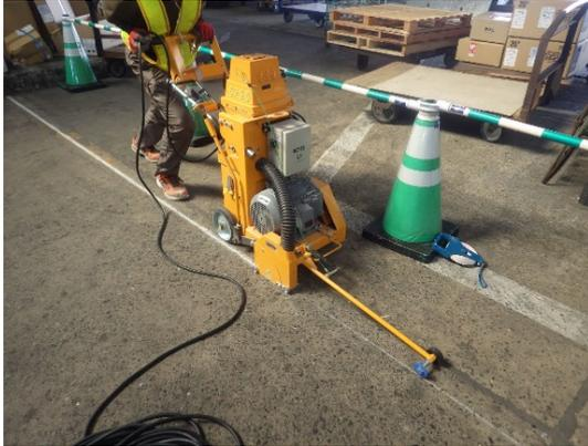
写真-2 カッター目地の施工状況
