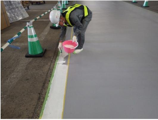
写真-11 ライン施工状況
