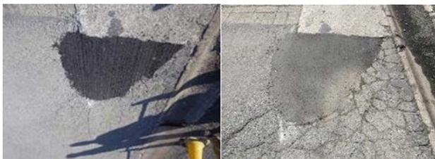
写真-7 段差修正(左:補修直後 右:補修1ヵ月後)
