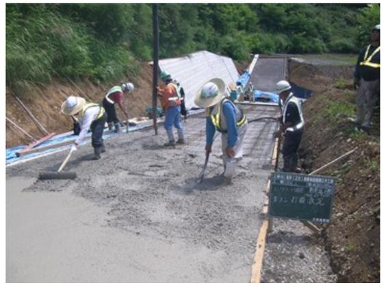
写真-4 生コンクリート打設状況
