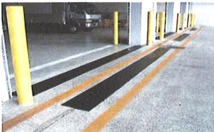
写真-10 倉庫前面に生じた舗装の段差補修例
