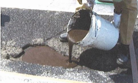
写真-3 流込みによる施工
