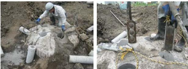
写真-4 バースター工法破壊状況
