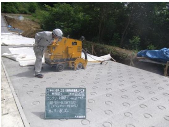
写真-10 横収縮目地 カッター切断状況
