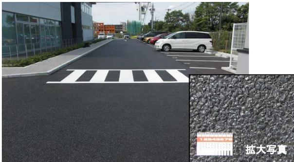
写真-8 供用後の打ち水ロード(施工4か月後)
