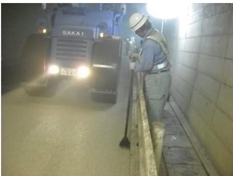
写真-21 端部締固め状況
