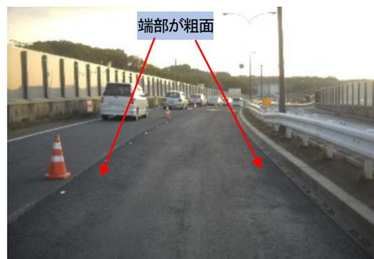
写真-8 R2→水平振動 R の表面性状(右)
