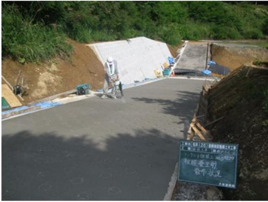
写真-8 被膜養生剤散布状況
