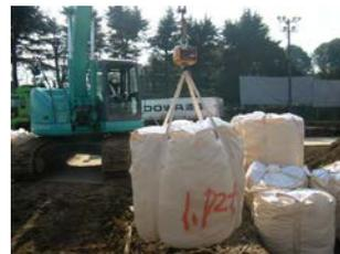
写真-10 泥土積込み状況 写真-11 特管汚泥積込状況
