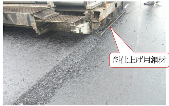
写真-7 ジョイント部の端部加工
