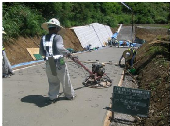
写真-6 トロウエルによる仕上げ状況
