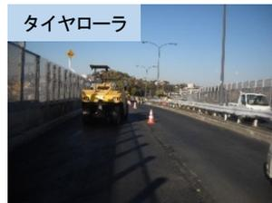
写真-9 水平振動ローラとタイヤローラによる転圧状況
