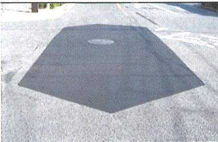
写真-8 交差点部マンホール周りの補修例
