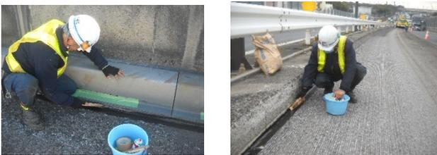
写真-4 プライマ塗布・L型止水テープ設置状況
