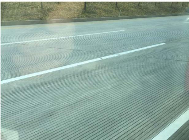
写真-20 グレーピング(縦断方向)
