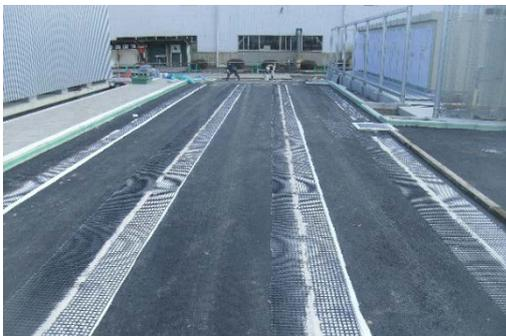
写真-3 点滴パイプ・導水シート・ジオテキスタイル敷設完了
