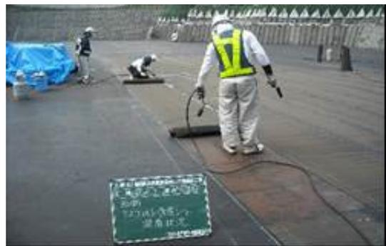
写真-3 遮水シート施工状況
