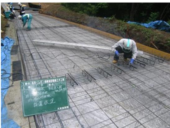
写真-3 横収縮目地設置状況
