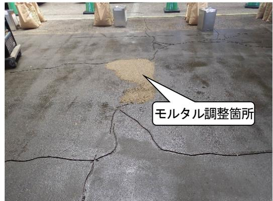
写真-5 調整モルタル完了
