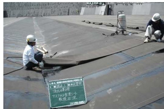
写真-4 遮水シート施工状況
