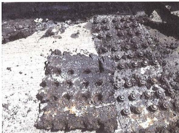
写真－6 既設舗装版撤去状況（添接版部）
