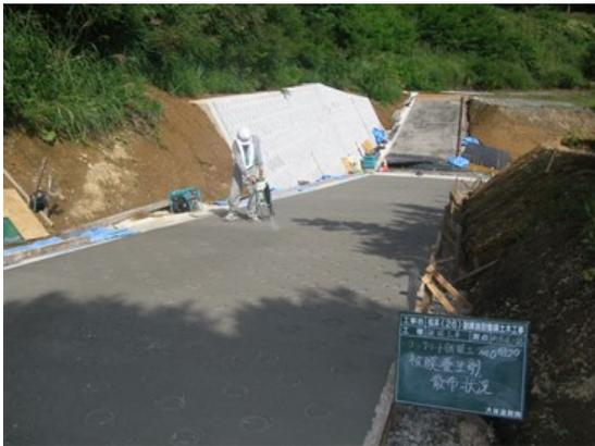
写真-9 養生マット設置状況
