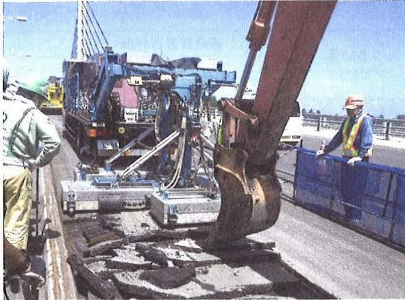
写真－5 既設舗装版撤去状況
