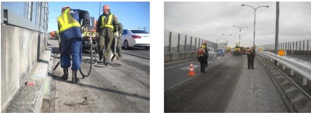
写真-3 端部撤去およびブローアーによる清掃状況
