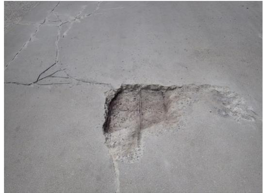
写真-4 はく離による破損箇所
