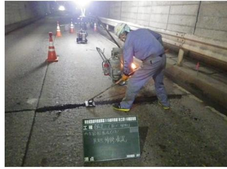
写真-7 既設コンクリート版の目地補修
