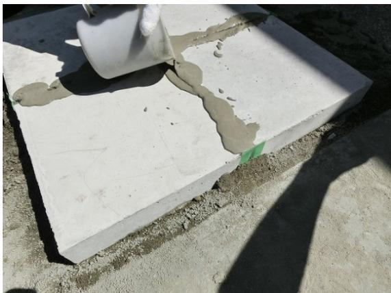
写真-3 目地への充填確認
