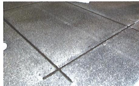
写真-12 充填による補修例
