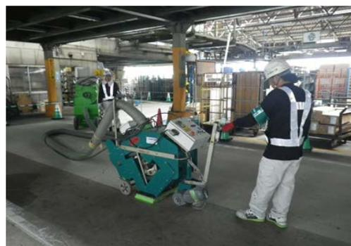
写真-1 ショットブラストの施工状況
