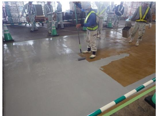
写真-10 トップコートの施工状況
