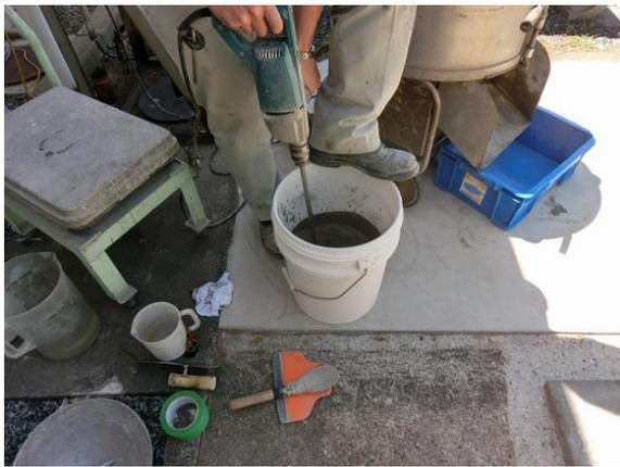
写真-1 目地モルタルの製造
