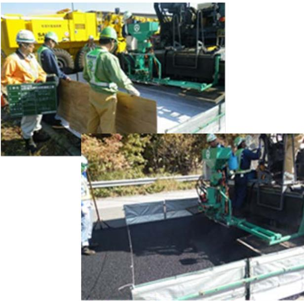
写真-3 ゴム粒子散布キャリブレーション状況
