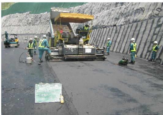
写真-2 下部遮水層施工状況
