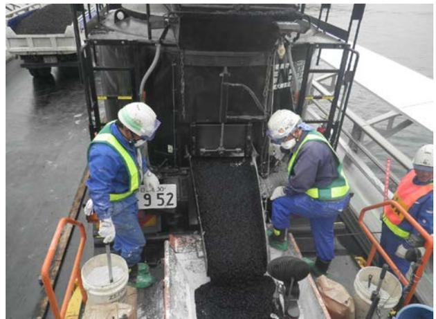
写真-3 クッカ車荷卸し状況
