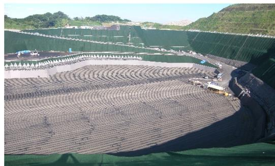
写真-5 遮水シート施工完了状況
