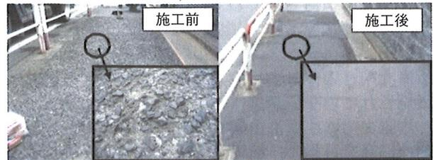
写真-11 舗装の‘荒れ’の補修例
