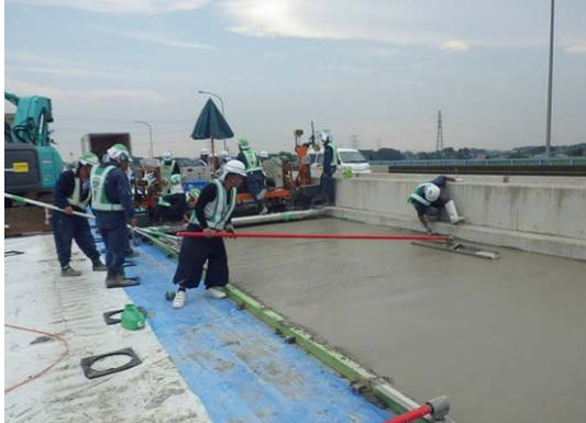
写真-10 SFRC打設状況
