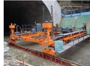
写真-1 両勾配のブレードスプレッダ(左)、コンクリートフィニッシャー(右)、コンクリートレベラー(中央)
