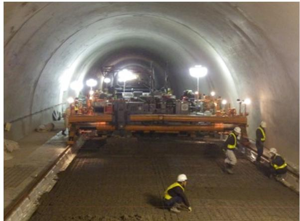
写真-6 鉄網・補強鉄筋の設置状況
