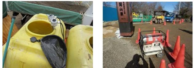
写真-1 水と骨材の加温状況
