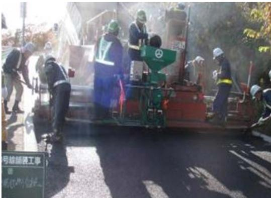
写真-5 敷きならしおよびゴム粒子散布状況
