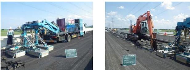
写真-1 IH式舗装版撤去工法
