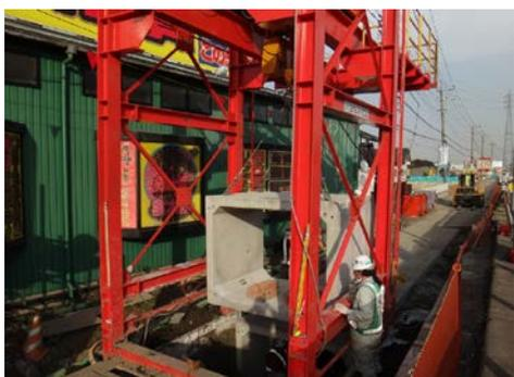
写真-6 函体設置状況
