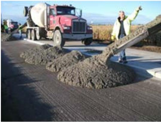
写真-3 As 切断面に材料荷下し
