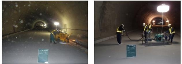
写真-12 カッター切断・目地溝清掃状況
