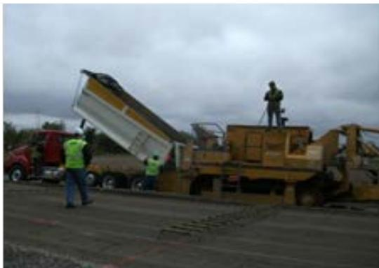
写真-11 材料供給機(RTP-500)
