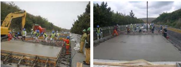
写真-9 敷きならし・締固め状況
