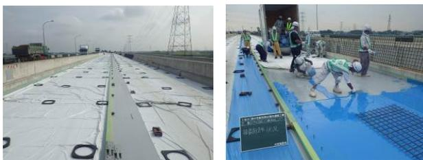
写真-8 防災シート敷設状況と接着剤塗布状況
