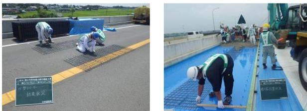
写真-9 CFRP格子筋結束状況と設置状況
