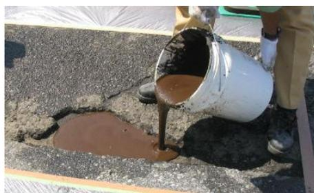
写真-3 流込みによる施工
