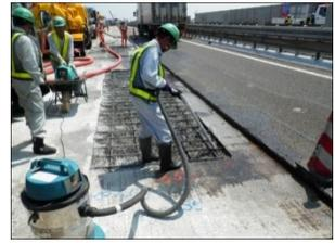
写真-3 汚濁水の吸引回収・清掃
