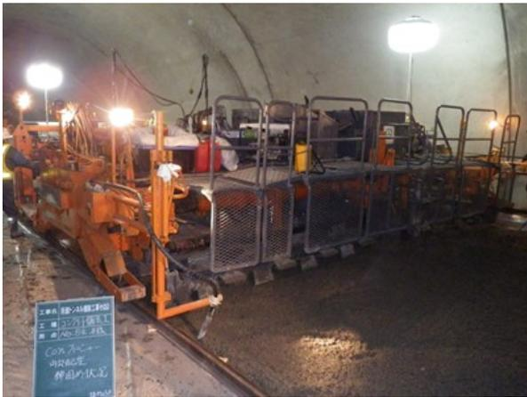
写真-8 コンクリートの締固め状況
