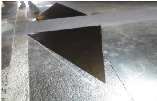
写真-7 橋梁ジョイント部の補修例
