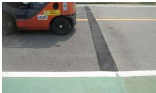
写真-9 工場構内の舗装の段差の補修例
