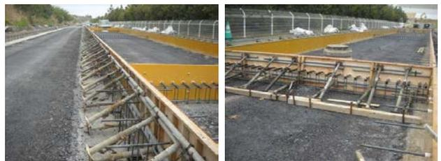
写真-3 型枠の設置状況
