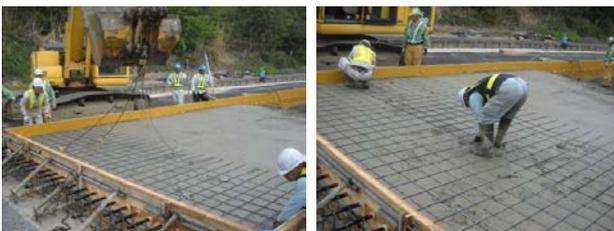
写真-8 鉄網の設置状況
