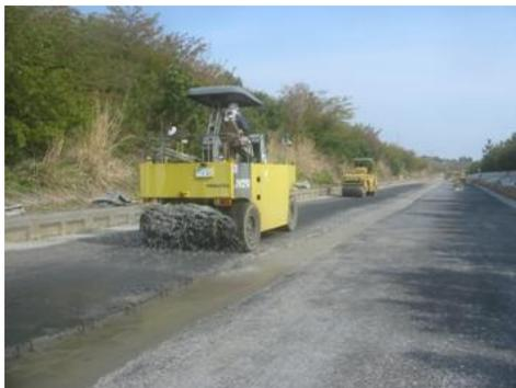
写真-1 路盤の施工状況
