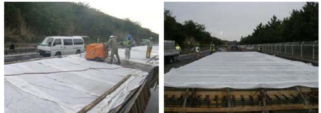
写真-13 誘発目地施工・後期養生状況
