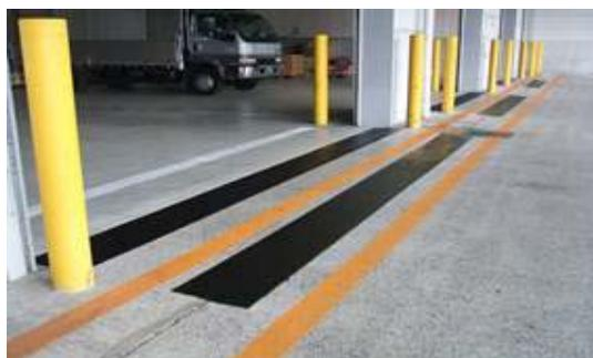
写真-10 倉庫前面の舗装の段差の補修例
