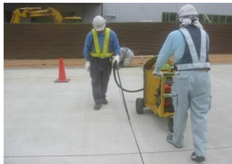
写真-14 目地材の注入状況
