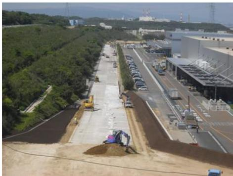
写真-16 コンクリート舗装の打設完了状況 (2)
