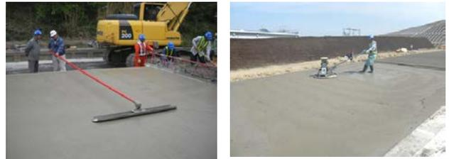
写真-10 フロート・回転ゴテによる仕上げ状況
