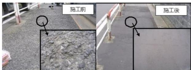
写真-11 舗装の‘荒れ’の補修例
