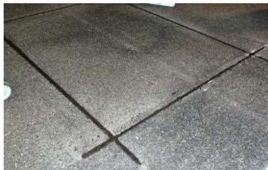
写真-12 充填による補修例
