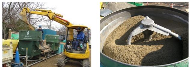
写真-2 混合・攪拌状況
