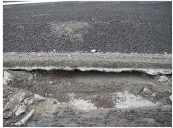
写真-4 ゴムラテックスモルタルの「浮き」現象
