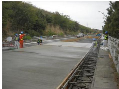
写真-12 初期養生(養生剤の散布)状況
