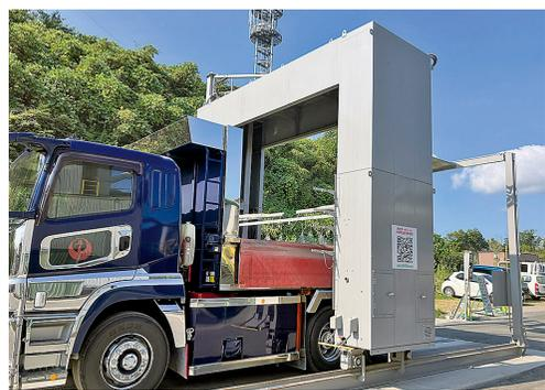
10tダンプへの合材付着防止剤自動散布状況
