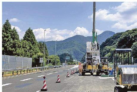
1車線規制での車載専用プラントの設置状況(報道発表資料から)
