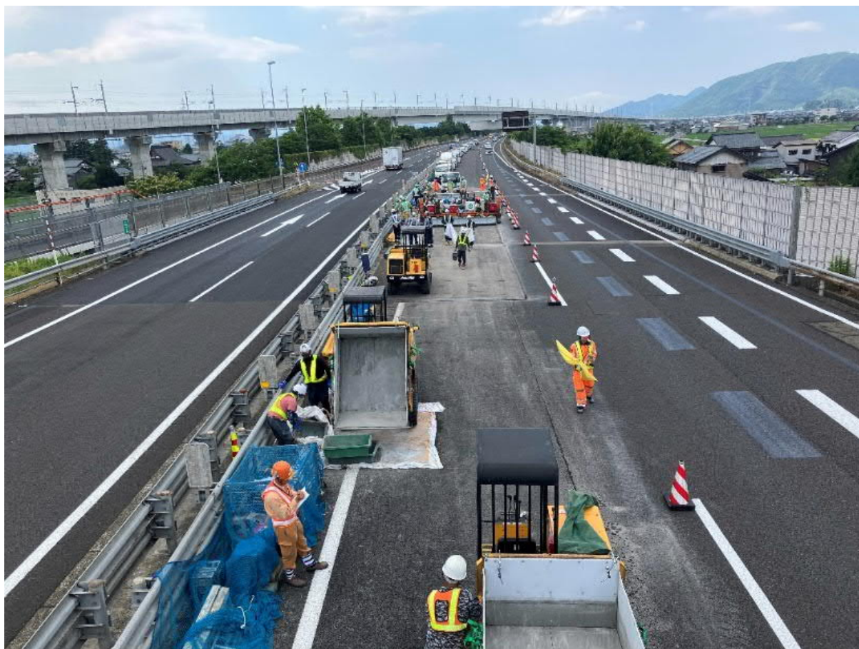
1車線規制での床版増厚工事の状況
