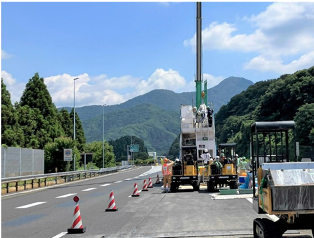
1 車線規制での専用車載プラント設置状況
