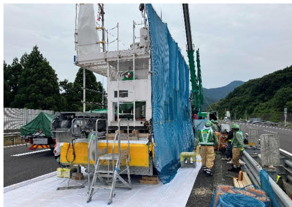
1 車線に収まる新開発の車載型専用プラント
