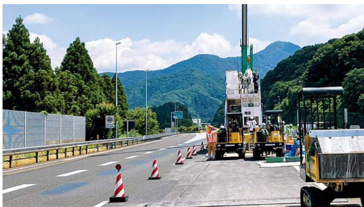
1車線規制での専用プラントの設置状況
