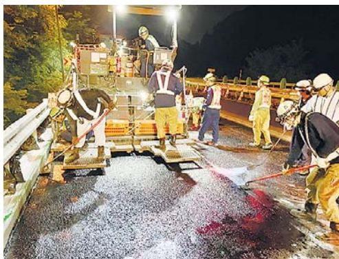
eグース・スーパーの施工状況
