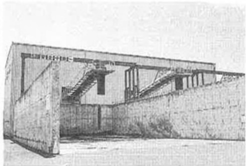
完成した中間処理施設
