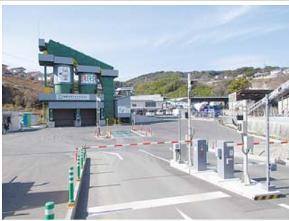
手前が自動開閉ゲートと車番認証システム。その先は自動計量装置（別府サテライトアスコン）
