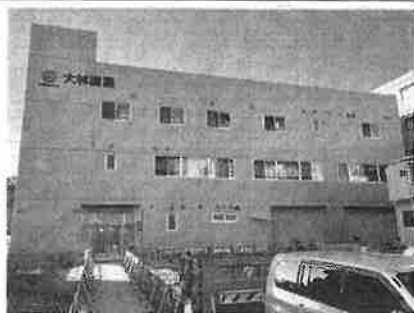
建設地は江戸川区南葛西
