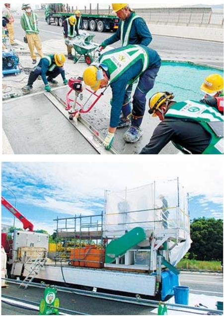
スティフクリートの施工状況(上)と専用車載ミキサー
