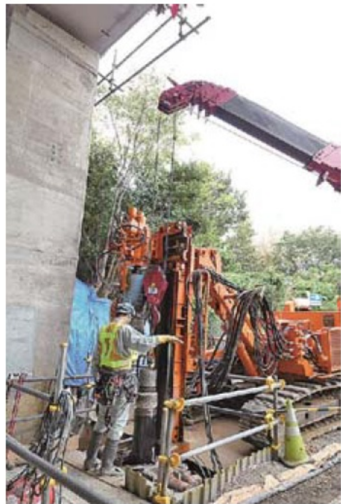
東山橋での施工状況
