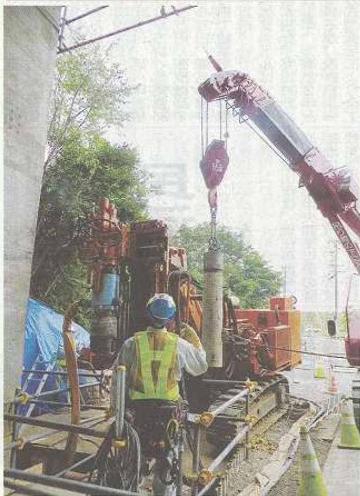
東山橋では大林組が開発した技術で工期・コストを削減
