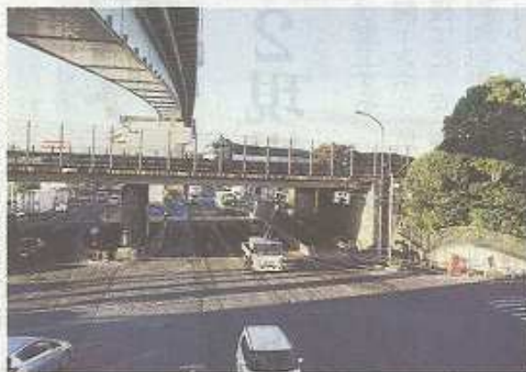
交通量の多い国道と交差する村中東高架橋
