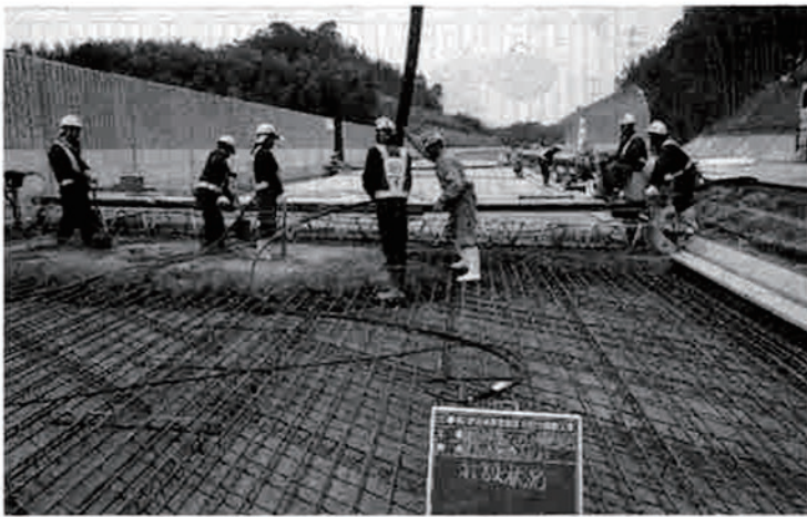
施工工程の回復に大きな役割を果たした
