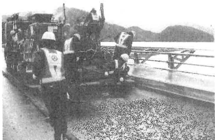
グースフィニッシャーによる敷きならし
