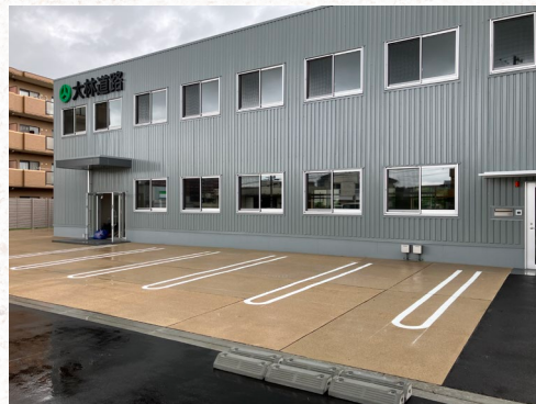
施工完了後(降雨時)
