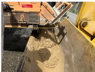
舗装材の排出
