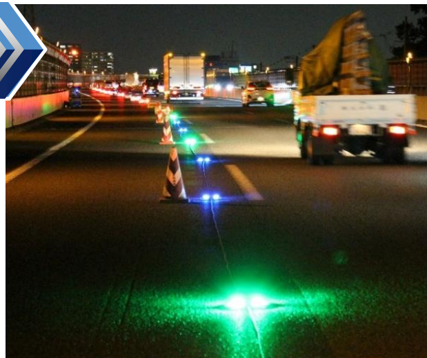
図5 車線規制箇所に設置したミチテラ
